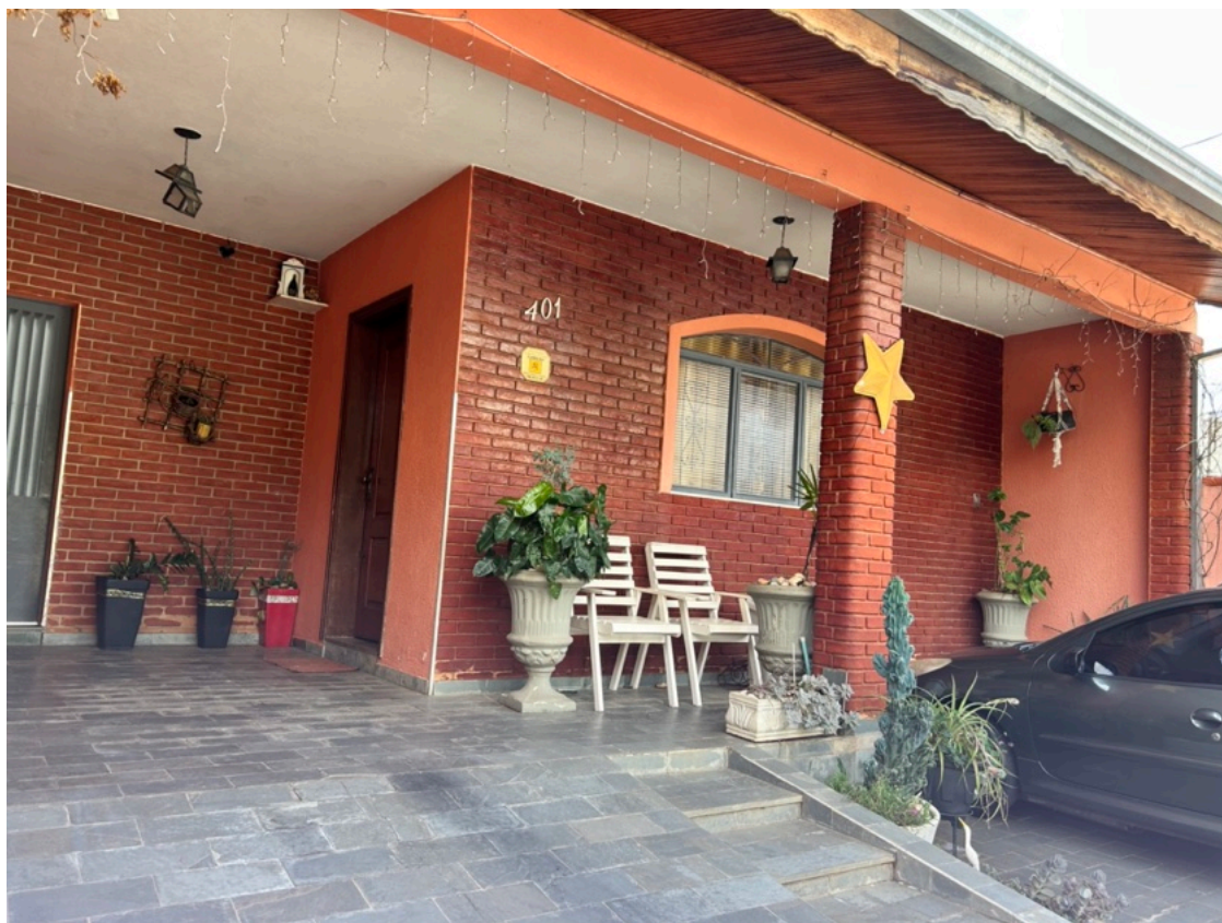
Foto I: ilustra fachada do imóvel
