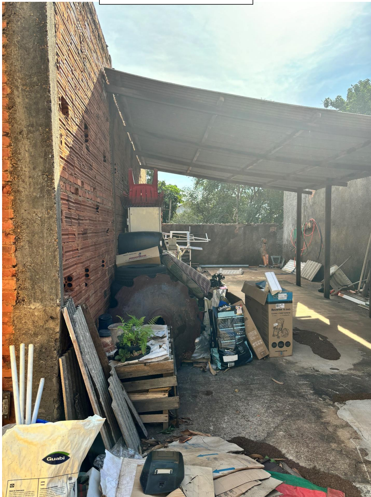
FOTO 6- VISTA DO FUNDO DO LOTE 13
