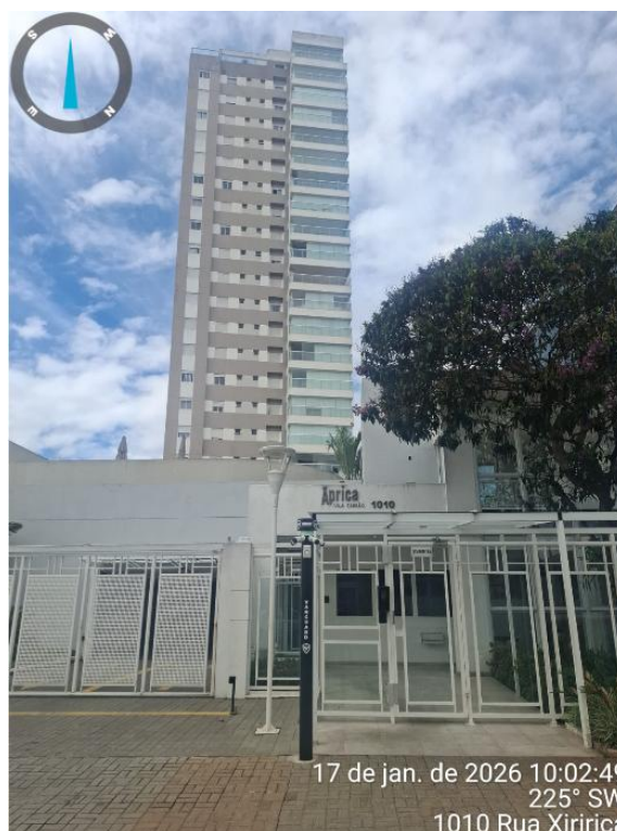
Foto 2 - Vista da fachada do imóvel em questão
