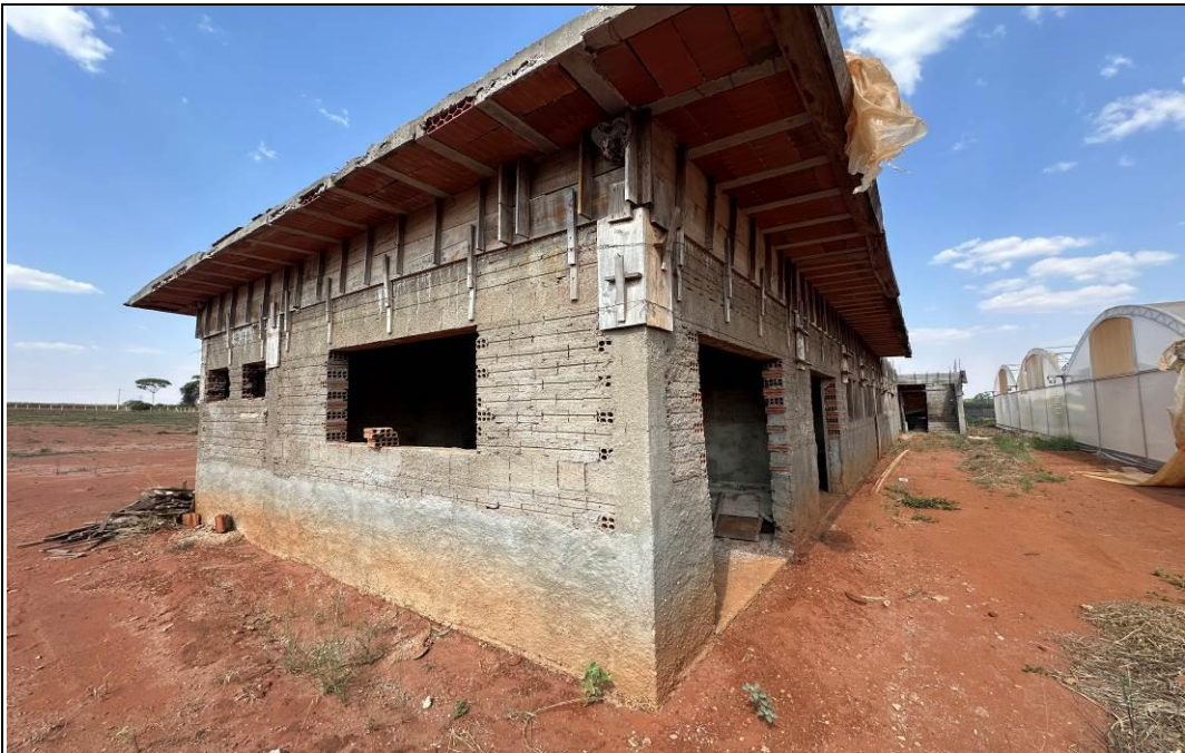
FOTO 02 – Vista parcial externa da edificação inacabada.
