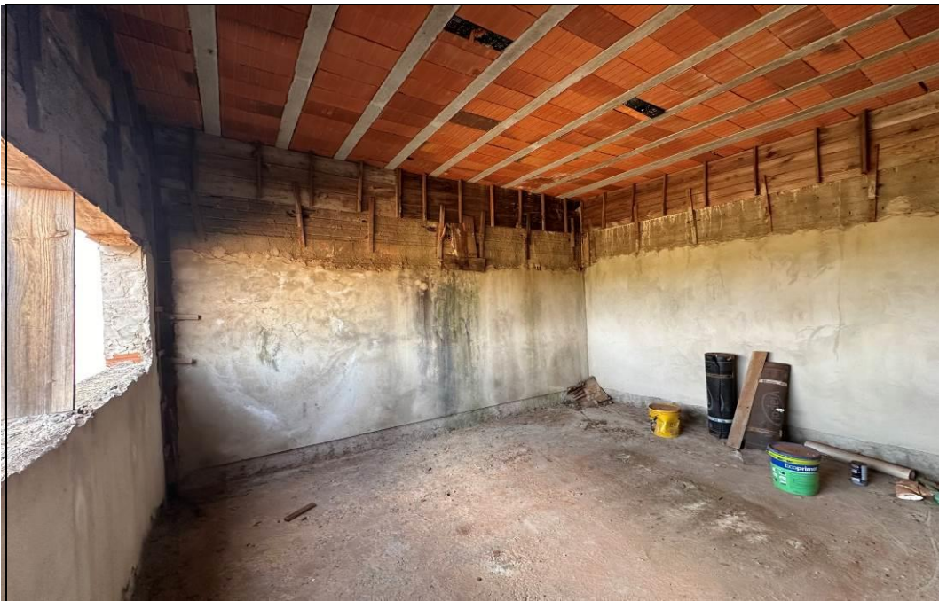
FOTO 06 – Vista parcial interna da edificação inacabada.
