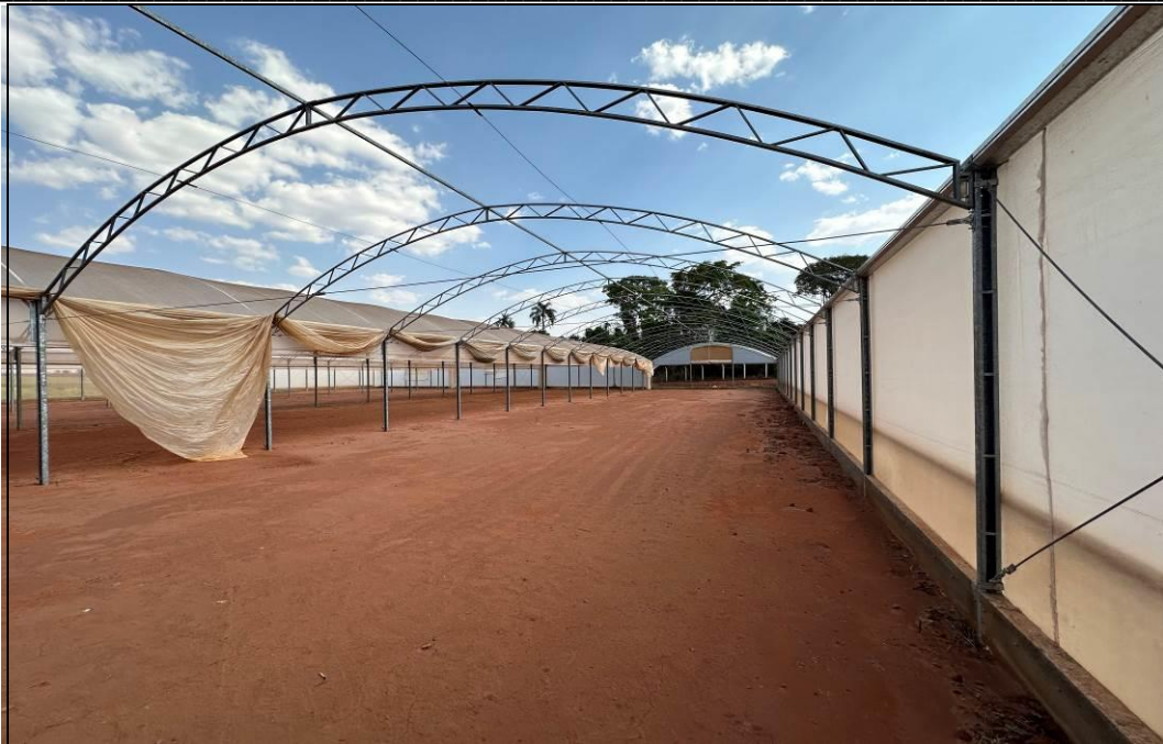
FOTO 10 – Vista parcial das estruturas de estufas agrícolas.
