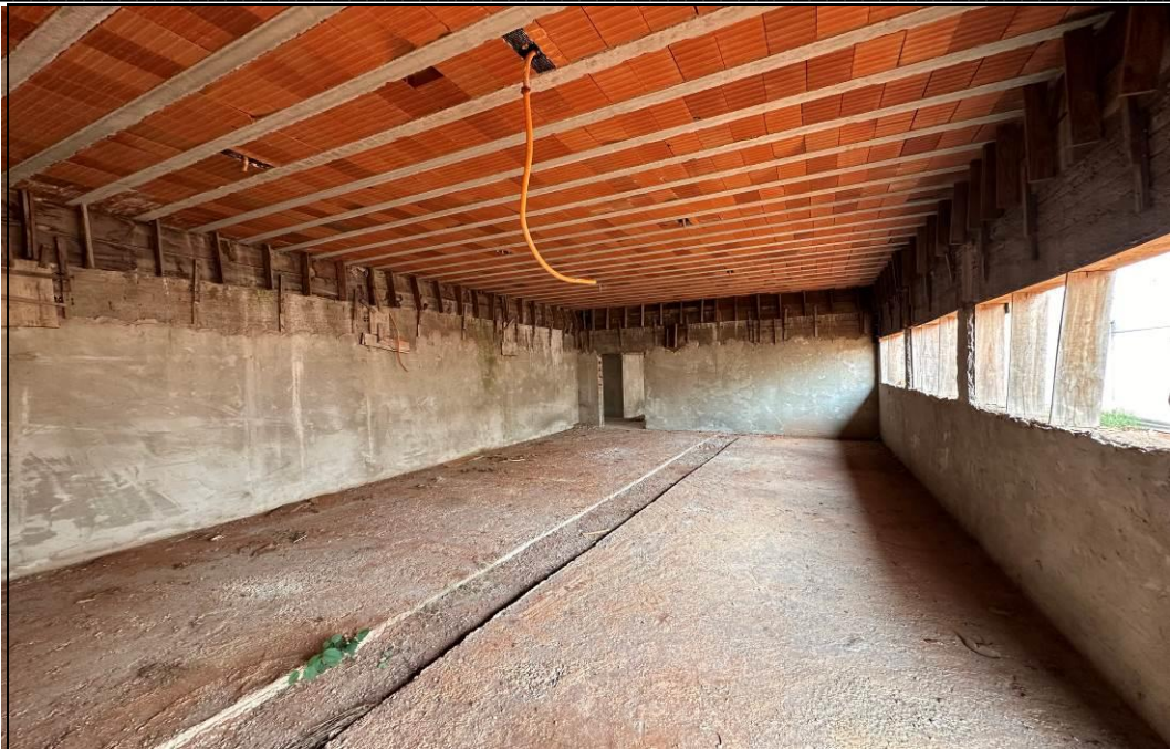
FOTO 03 – Vista parcial interna da edificação inacabada.
