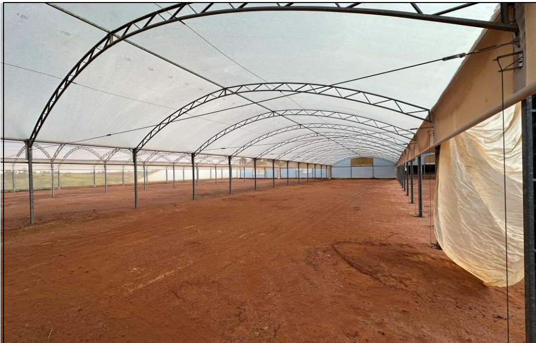
FOTO 11 – Vista parcial das estruturas de estufas agrícolas.
