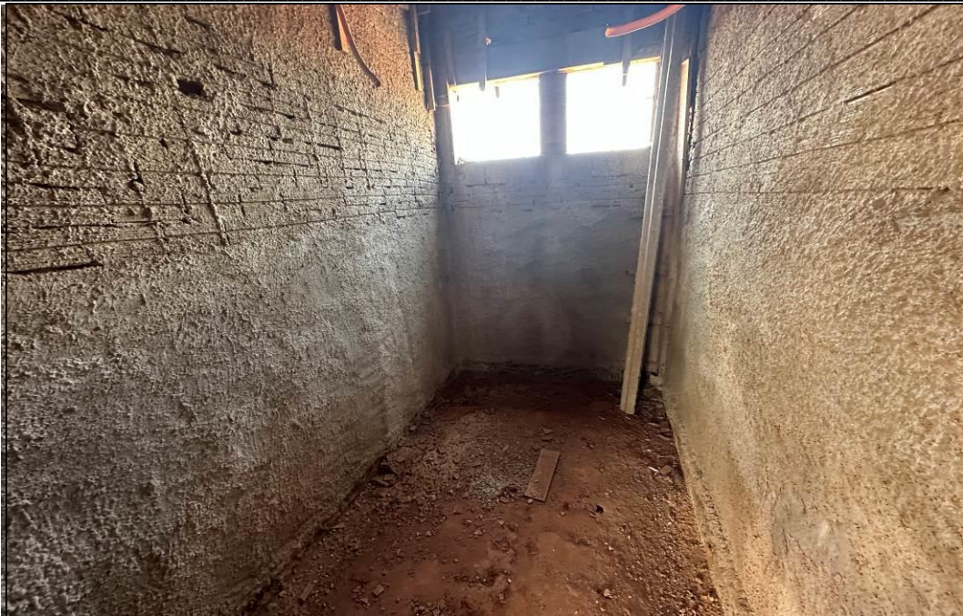
FOTO 05 – Vista parcial interna da edificação inacabada.
