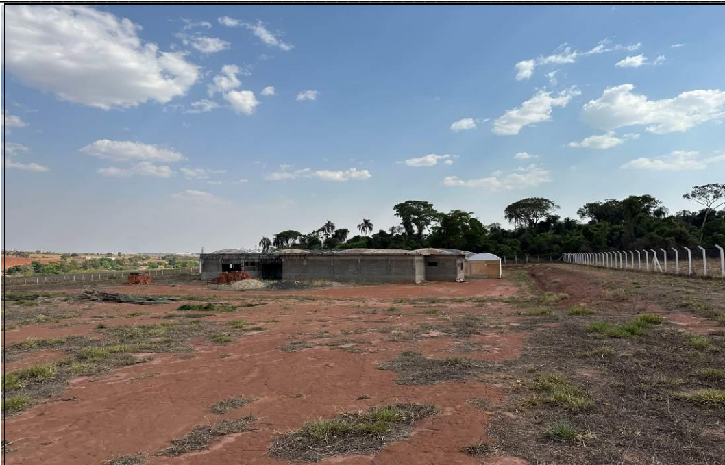
FOTO 01 – Vista parcial da construção inacabada pertencente a propriedade.
