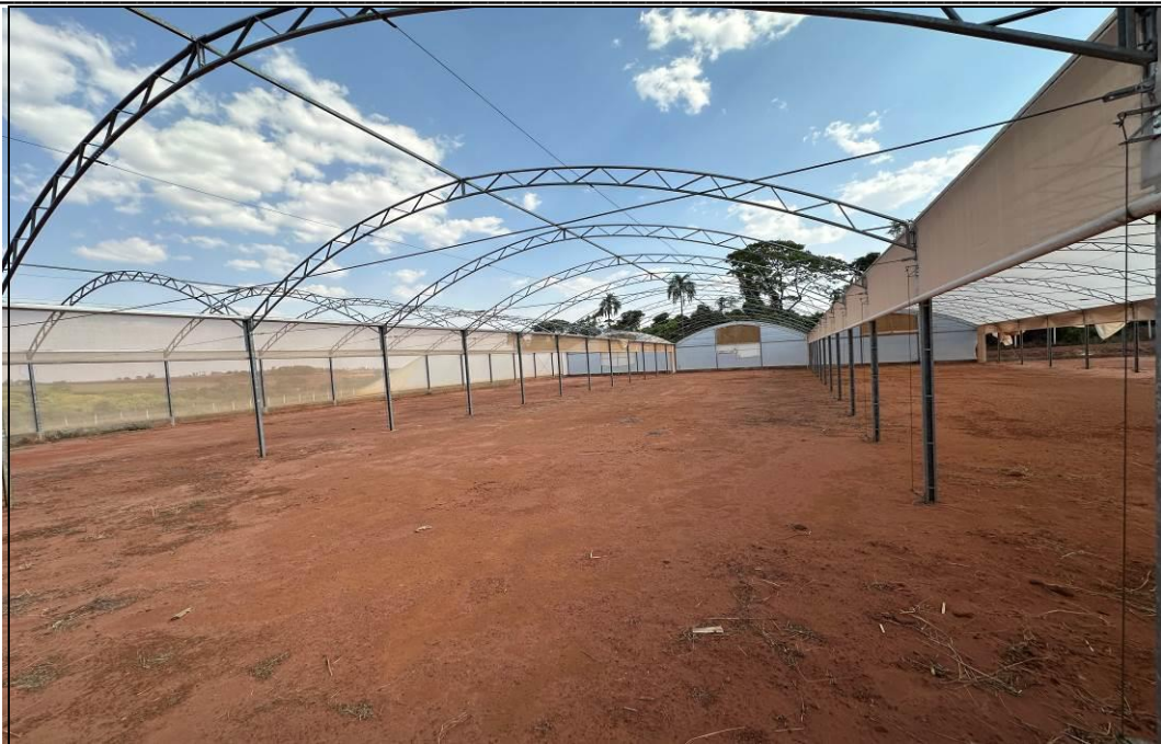
FOTO 12 – Vista parcial das estruturas de estufas agrícolas.
