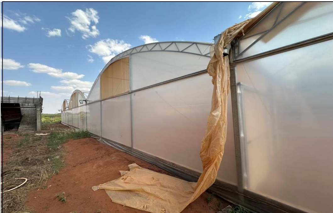
FOTO 08 – Vista parcial das estruturas de estufas agrícolas.
