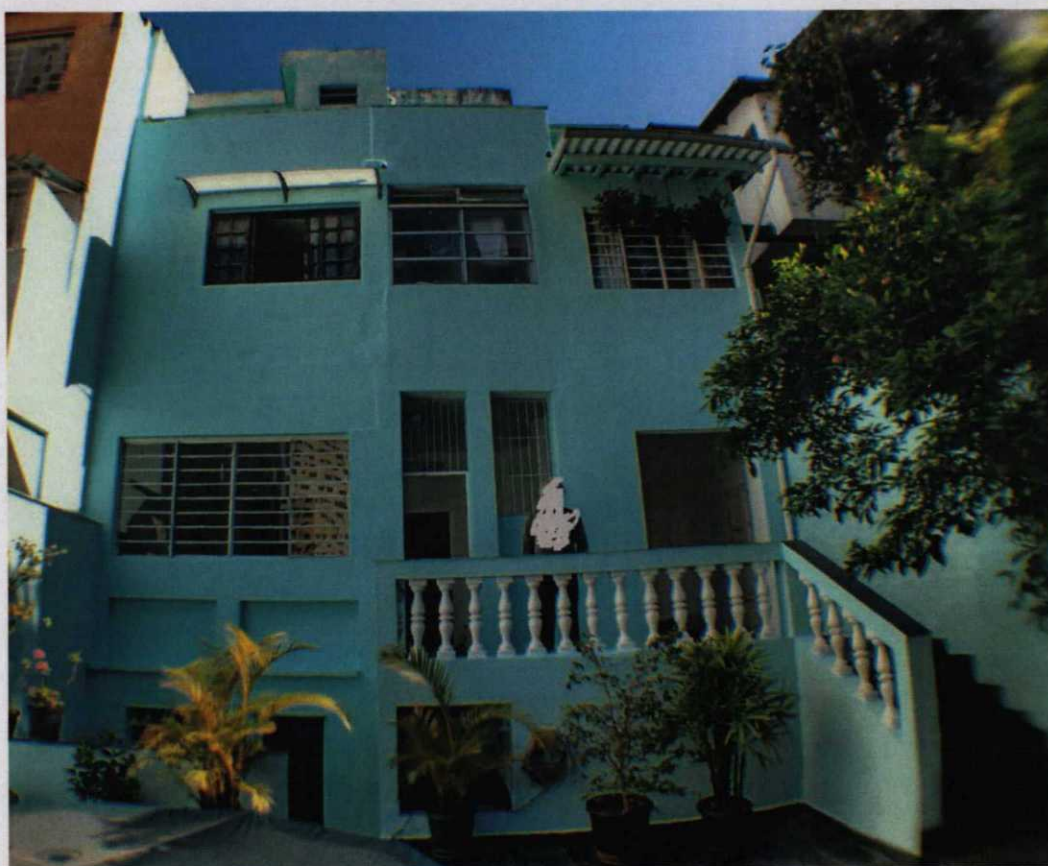
Foto 11 – Fachada dos Fundos
