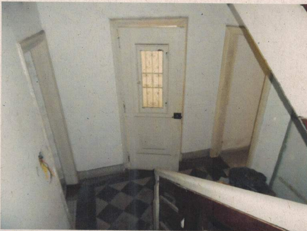
Vista do espaço que interliga os cômodos
