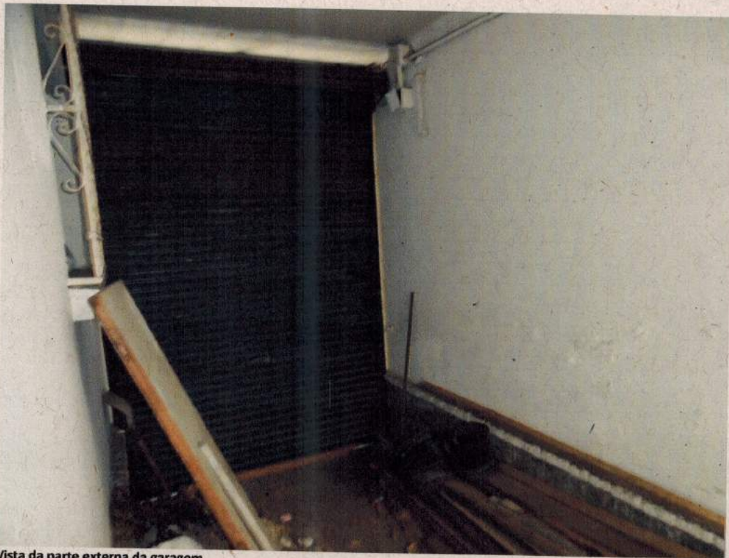
Vista da parte externa da garagem
