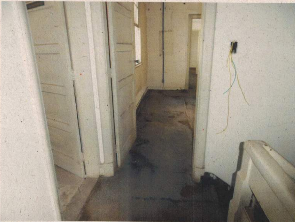
Vista do corredor de acesso aos cômodos
