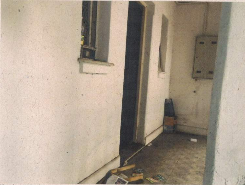
Vista da corredor de acesso para entrada
