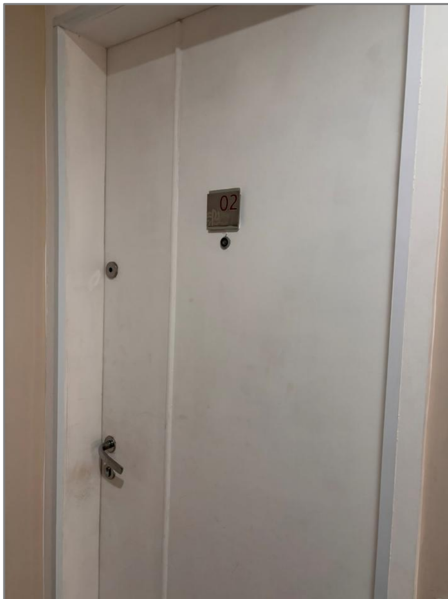
Foto 6 – Placa de identificação da unidade avalianda (nº 02 do Edifício Verano).
