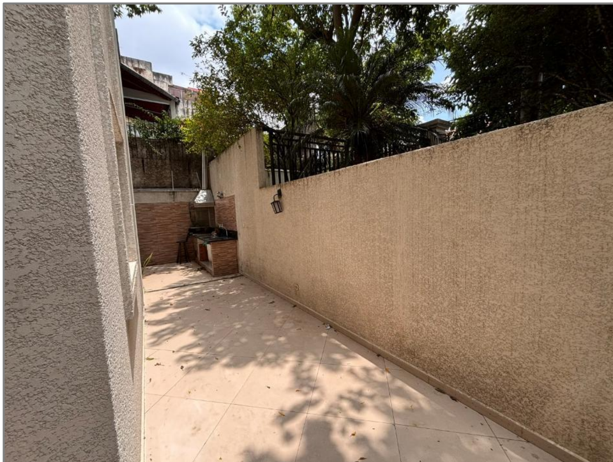
Foto 8 – Unidade nº 02 – Edifício Verano : Vista parcial da área descoberta privativa.
