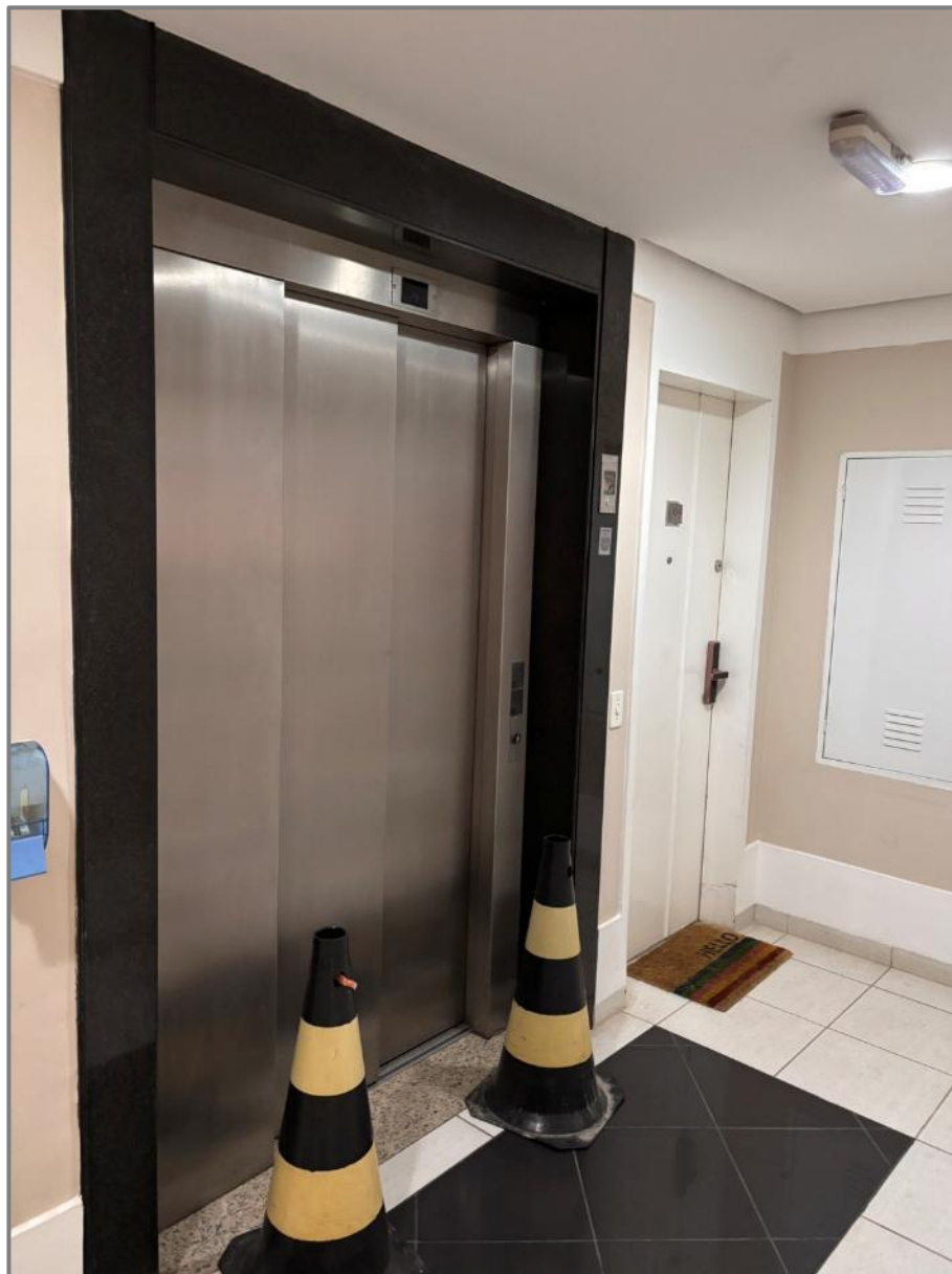
Foto 16 – Áreas Comuns do Condomínio: Elevador.
