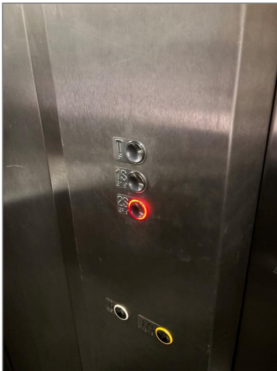
Foto 23 – Áreas Comuns do Condomínio: Acesso ao 2º SS.
