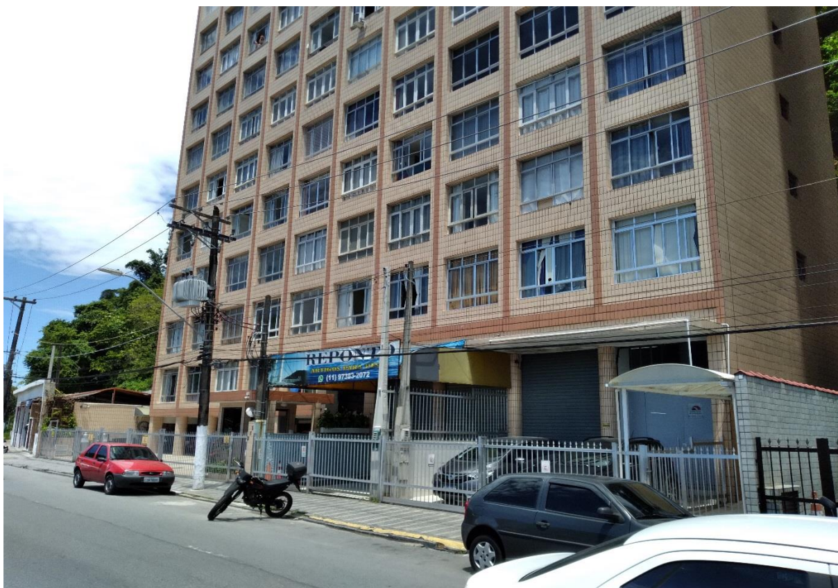
FOTO 02 -Vista parcial da fachada frontal do “Condomínio Edifício Biquinha” (Fachada).
