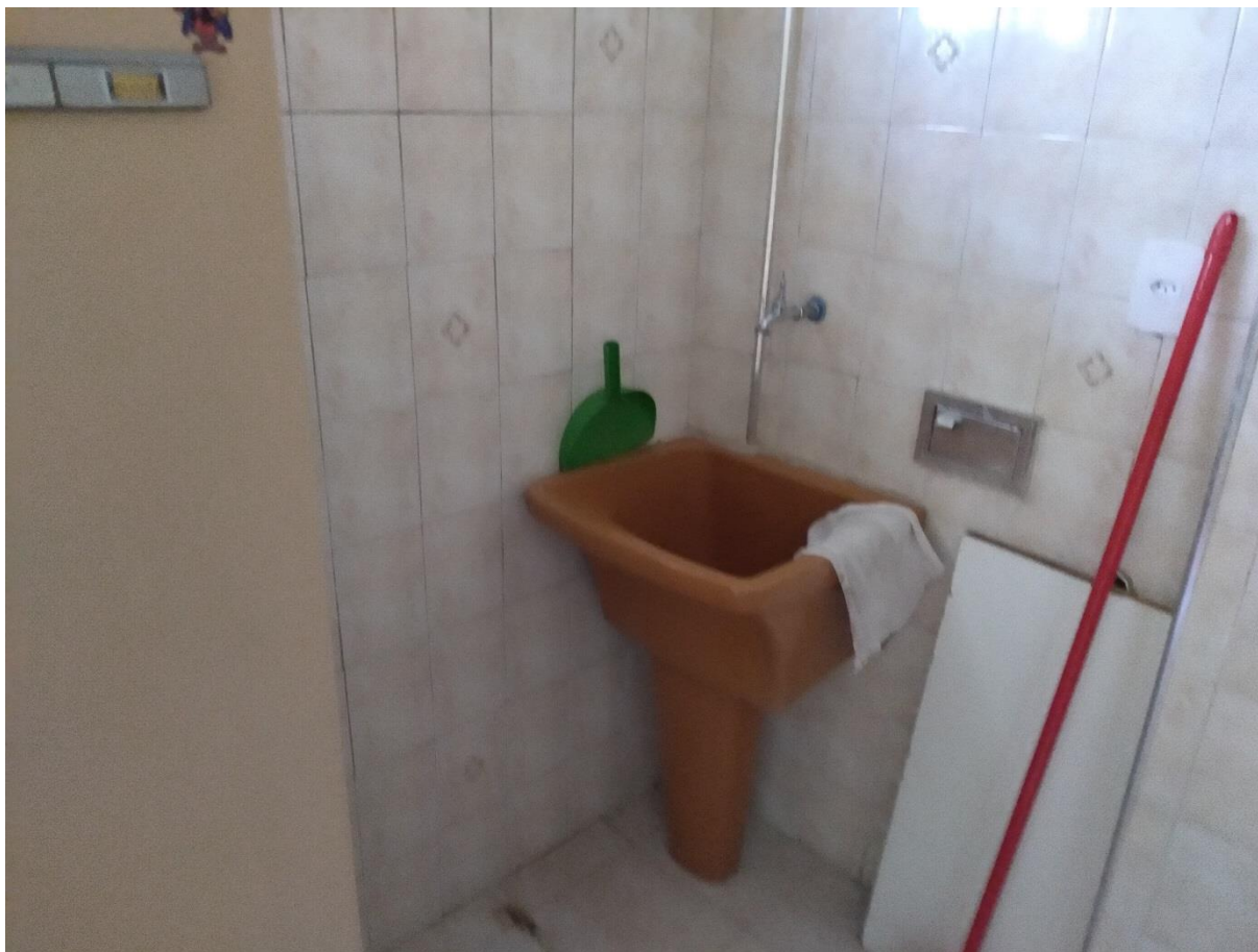
FOTO 10 – Vista parcial interna do estado do imóvel avaliando (área de serviços).
