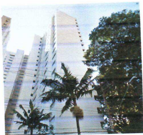
Fachada lateral e fundos
