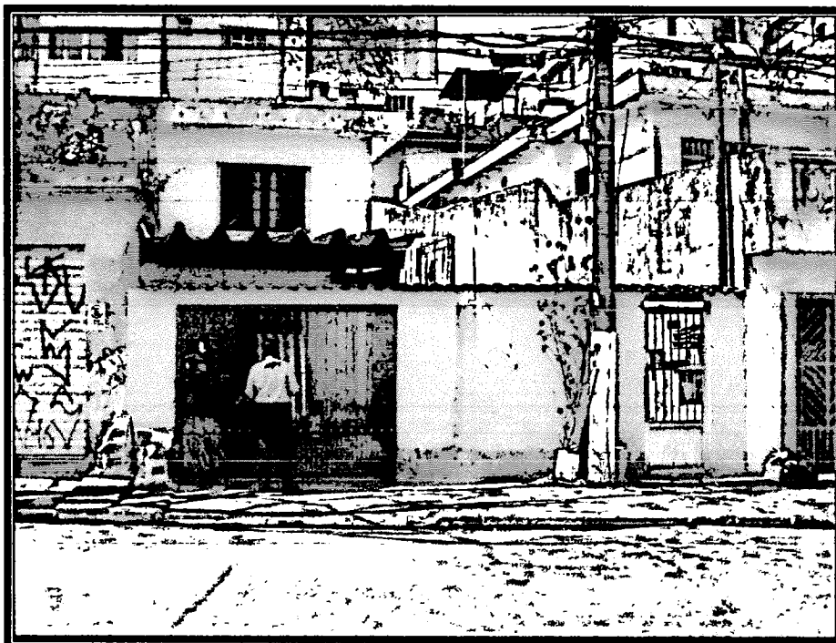
Vista da frente do imóvel avaliando.
