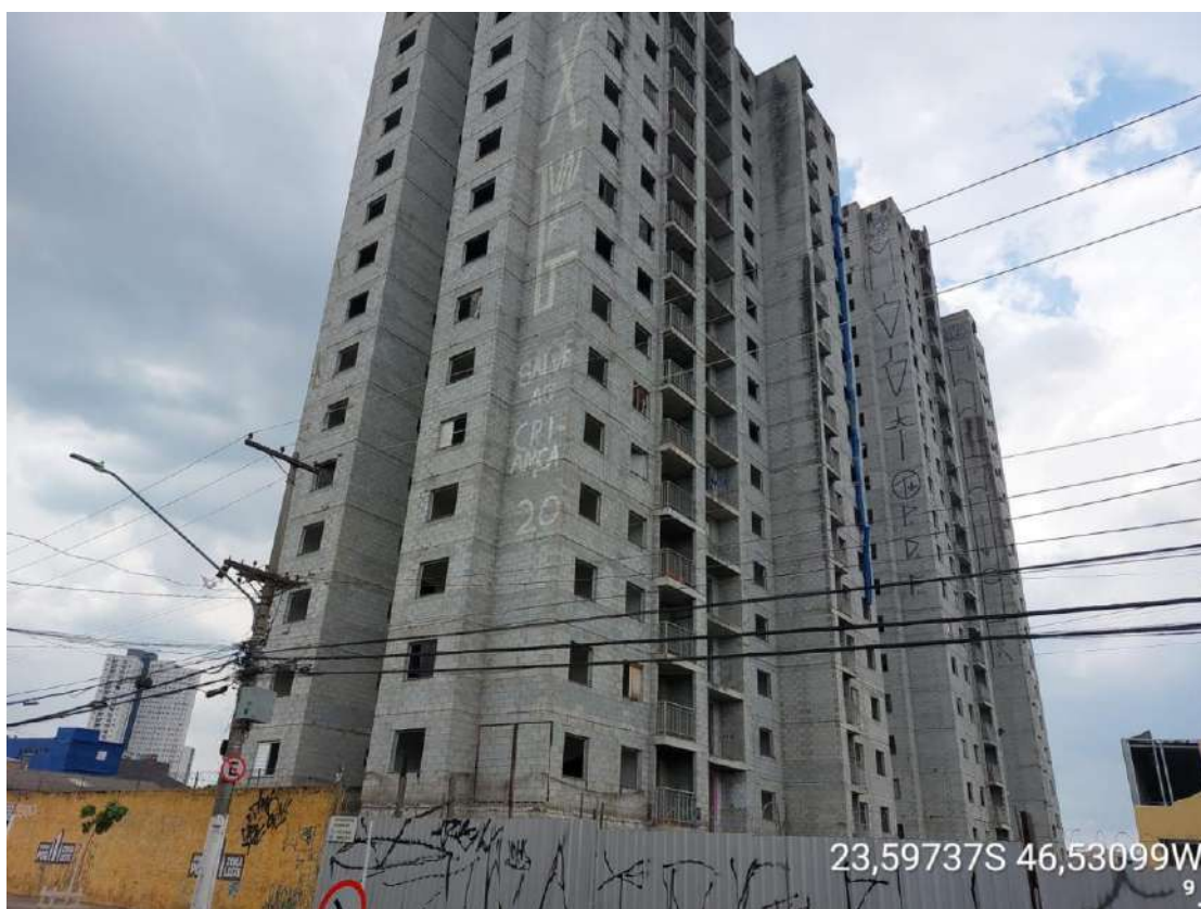
Foto 8: Vista frontal e lateral do imóvel avaliando (Avenida Vila Ema)
