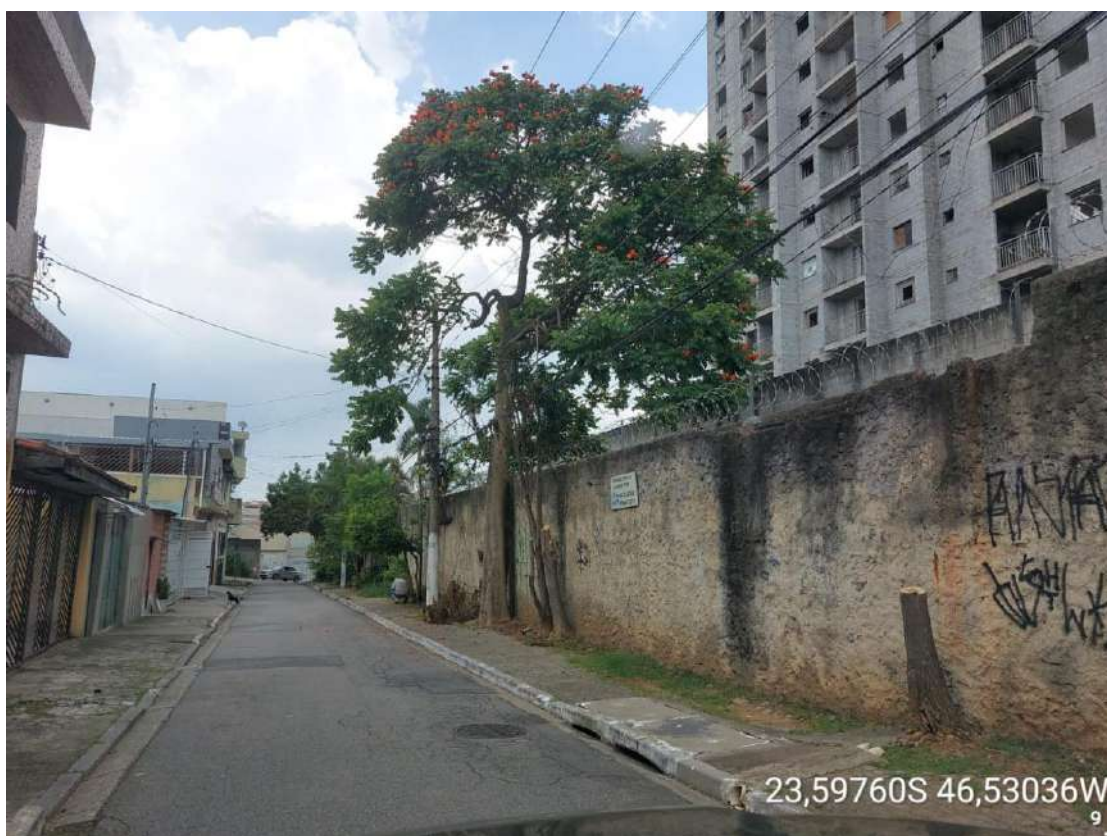
Foto 2 : Vista lateral do imóvel avaliando (Rua Ângelo Franchini)
