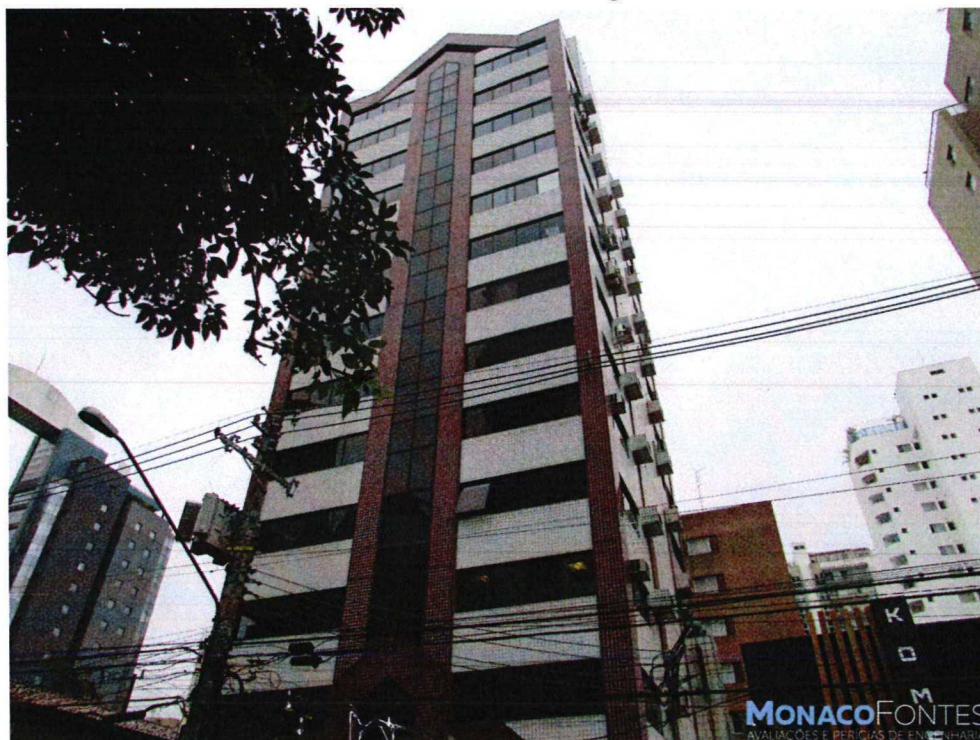
Na imagem acima, tem-se uma tomada da testada do Edifício Ibirapuera Office Center.
