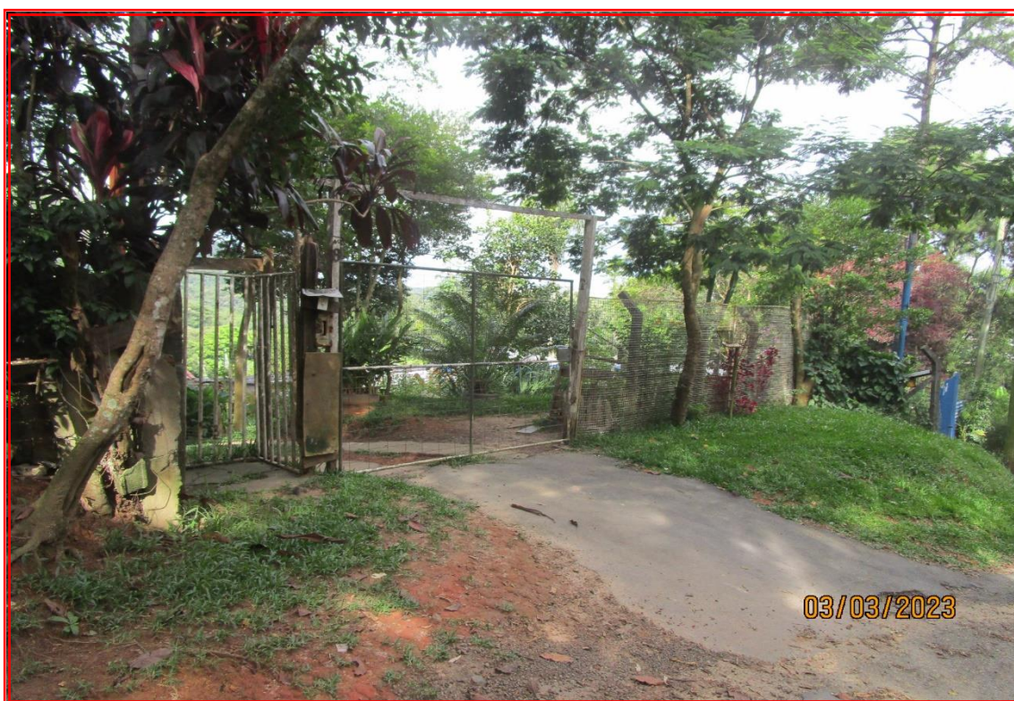
Foto nº 07: Vista geral do portão de entrada.
