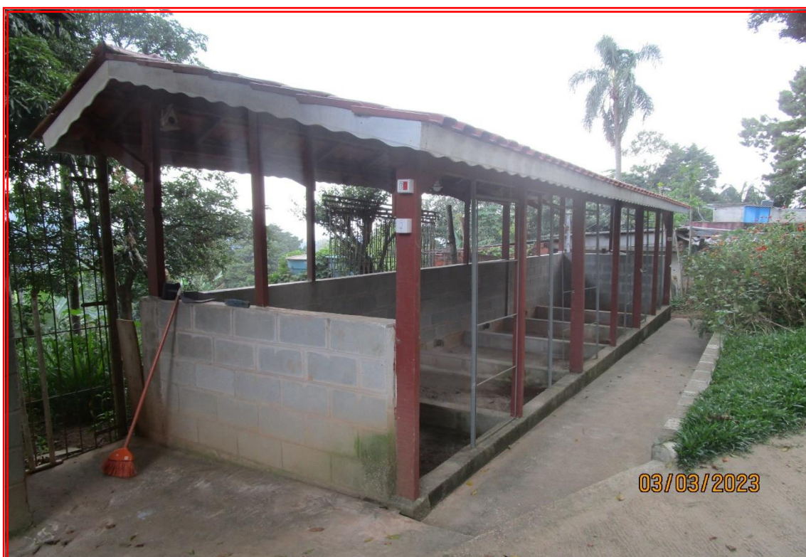
Foto nº 13: Vista geral da cobertura.
