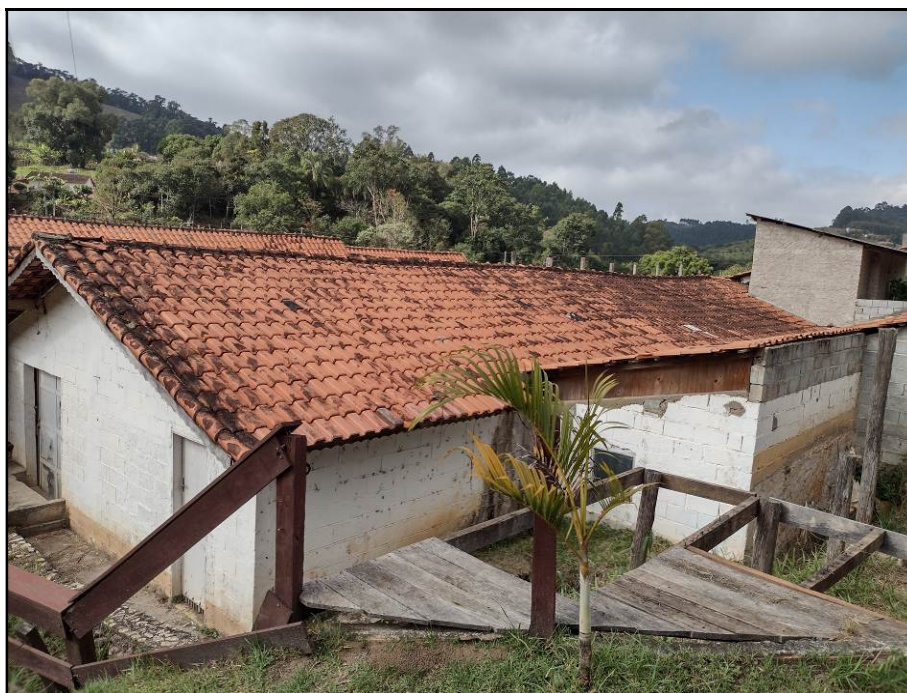
Vista da construção 03.
