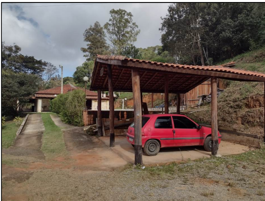
Vista da construção 06 – cobertura.
