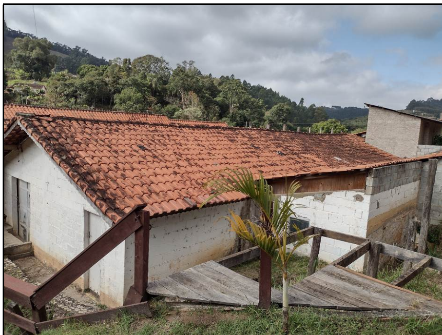
Vista da construção 3 – galpão de eventos.
