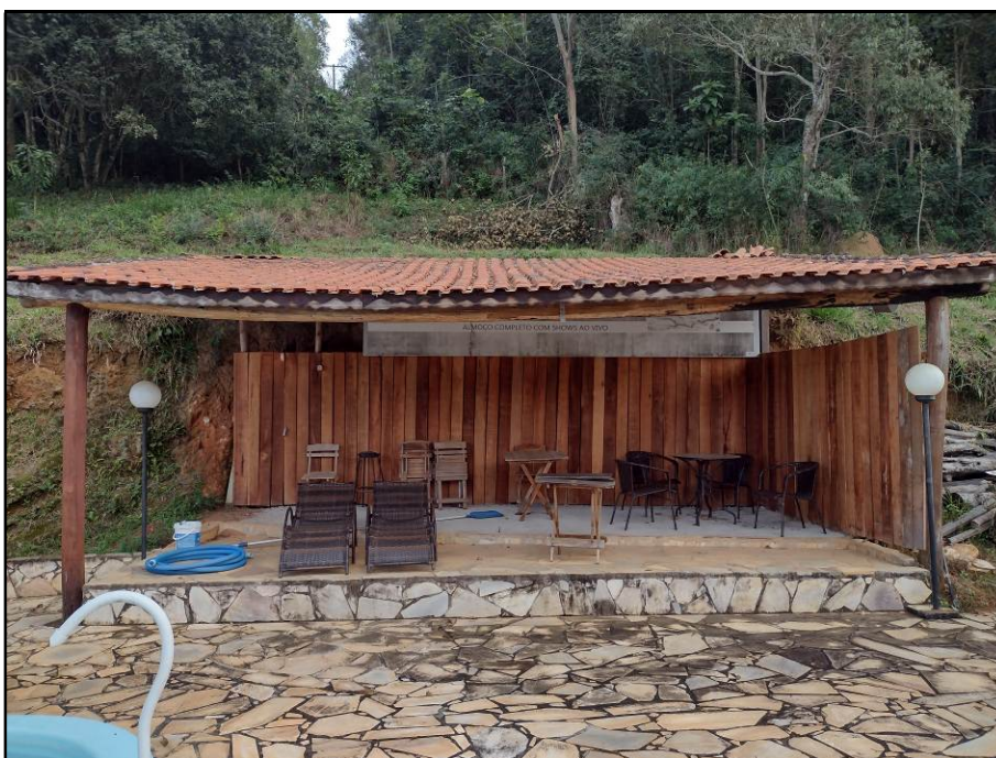
Vista da construção 07 – cobertura.
