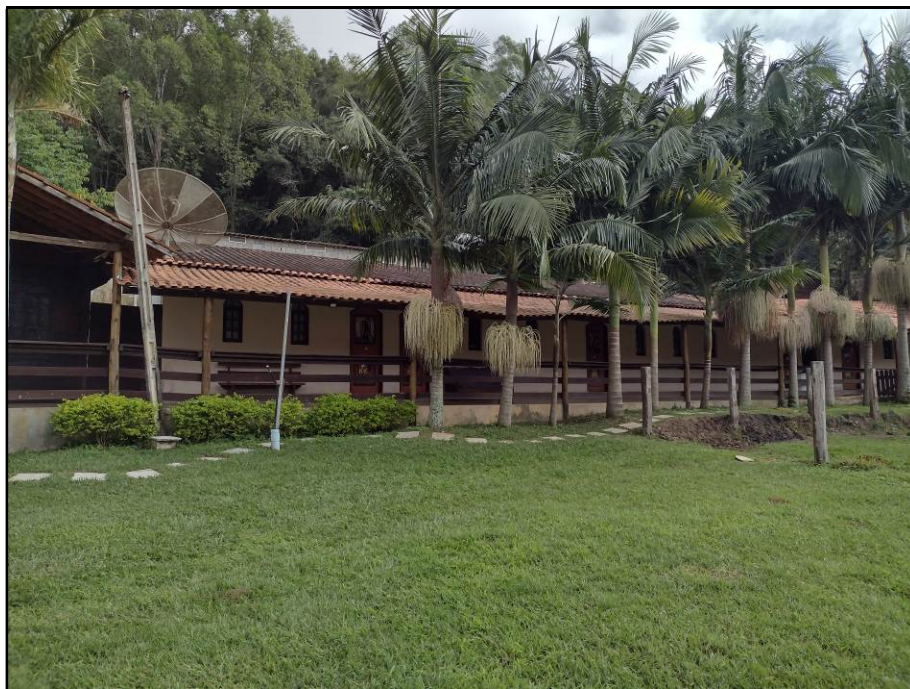
Vista da construção 01.
