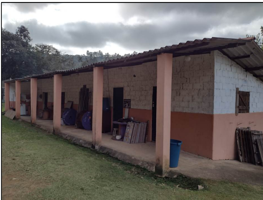
Vista da construção 05 – galpão.
