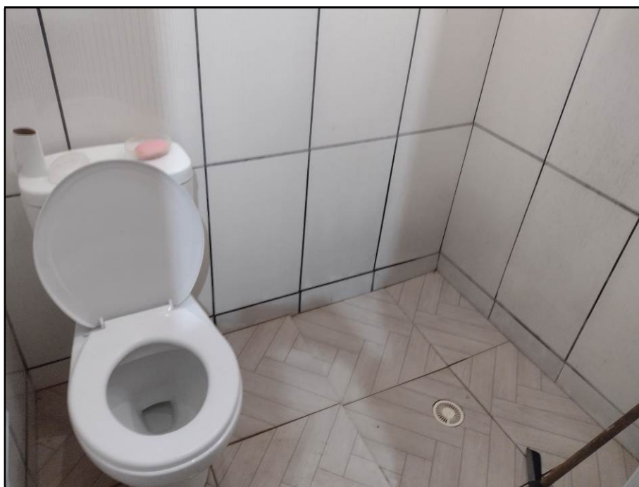
Vista do banheiro de um dos chalés da construção 1 - Chalés em alvenaria.
