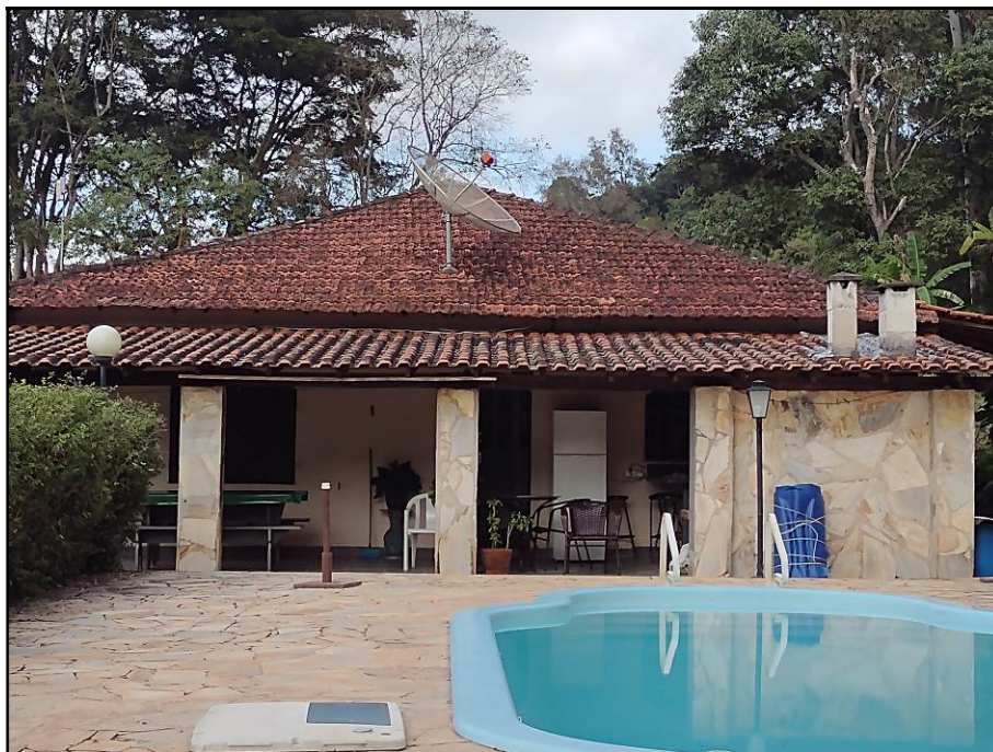
Vista da construção 04.
