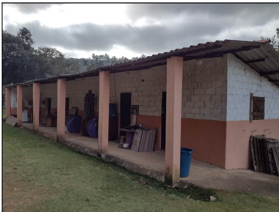
Vista da construção 05.
