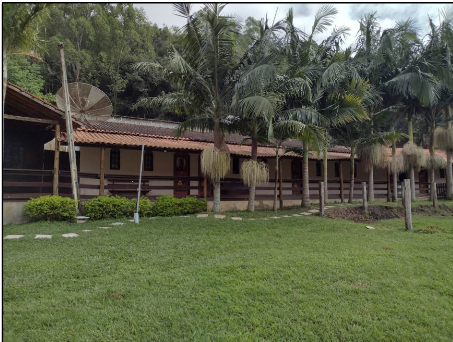
Vista da construção 1 – Chalés em alvenaria.
