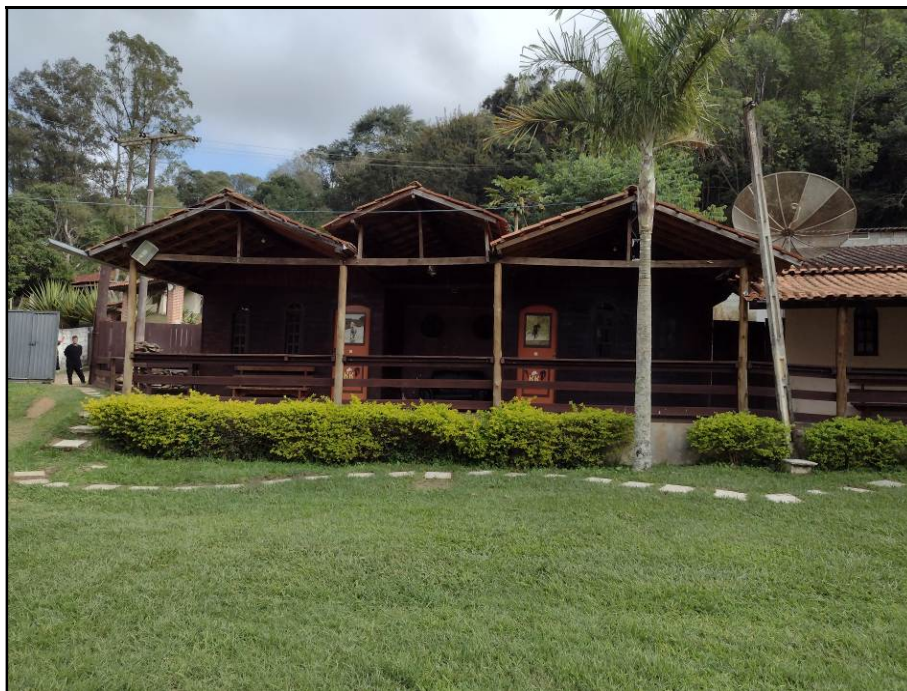
Vista da construção 02.
