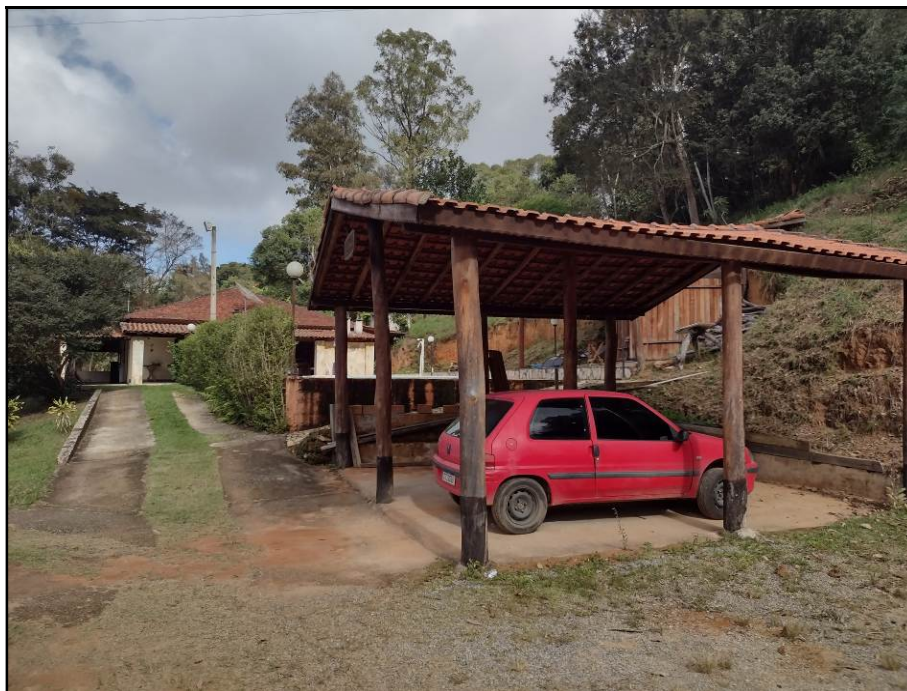
Vista da construção 06.
