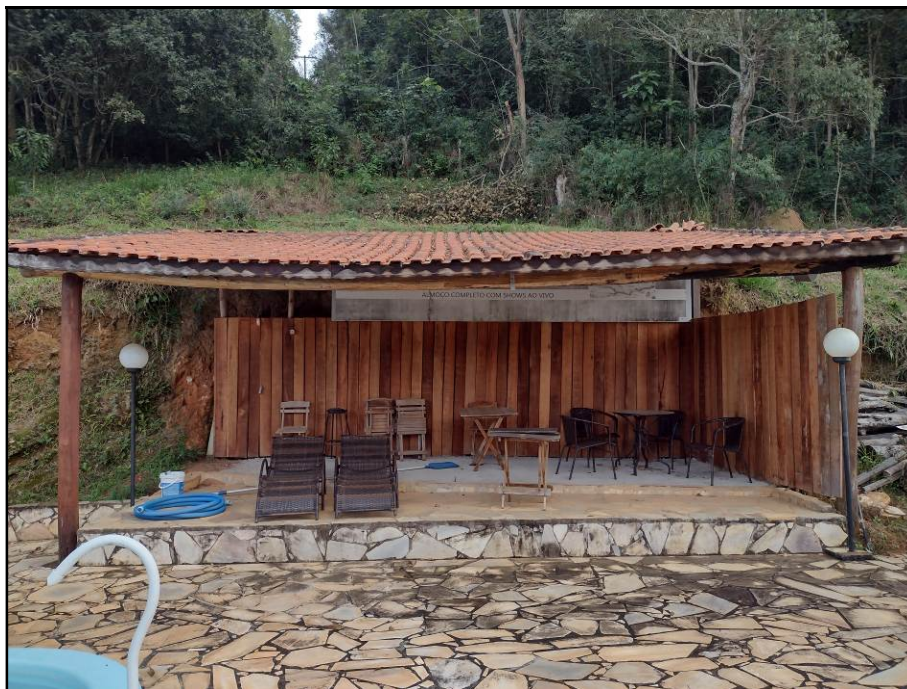
Vista da construção 07.
