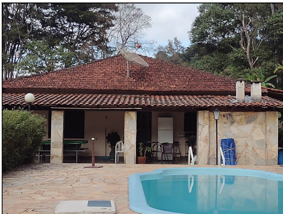
Vista da construção 4 – casa.
