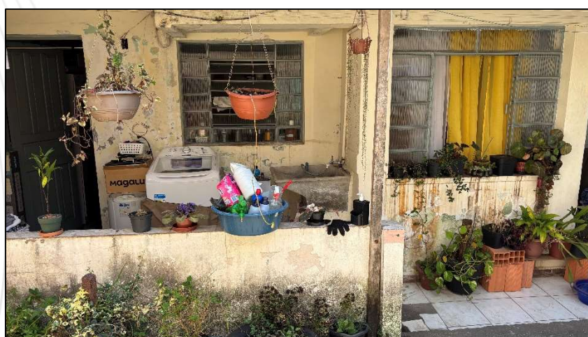
Foto 63. Fachada da casa inferior 3
