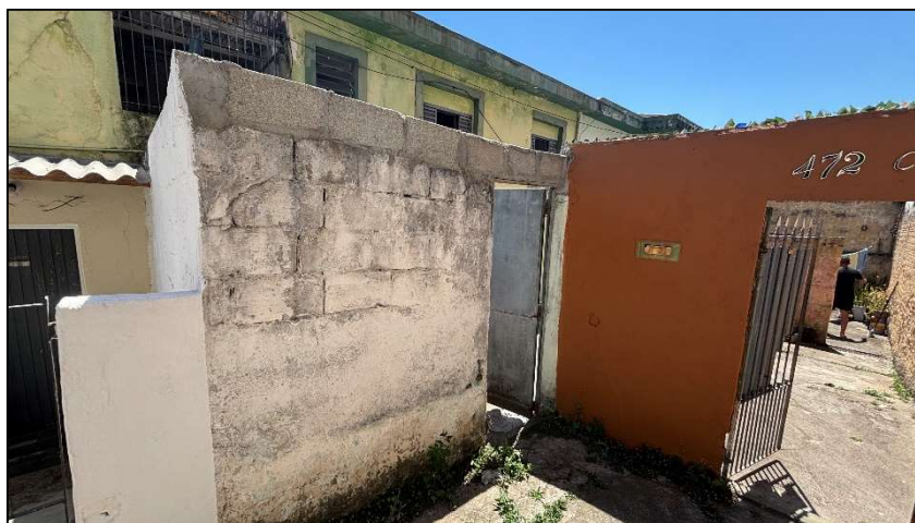
Foto 44. Fachada da casa inferior 2
