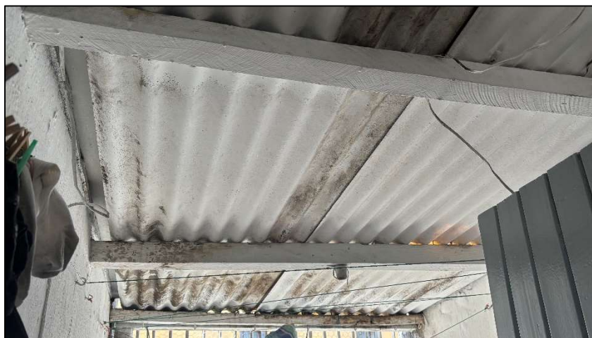
Foto 13. Área de serviço da casa térrea
