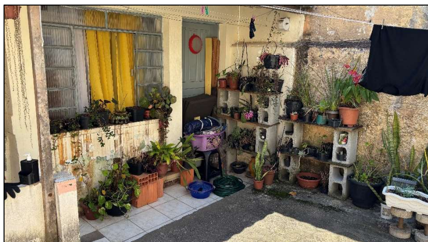
Foto 62. Fachada da casa inferior 3
