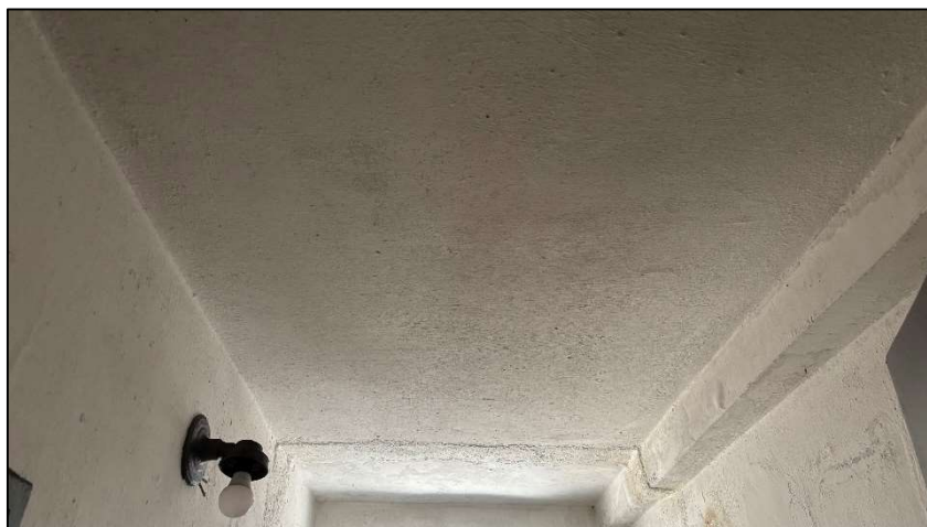
Foto 50. Banheiro da casa inferior 2
