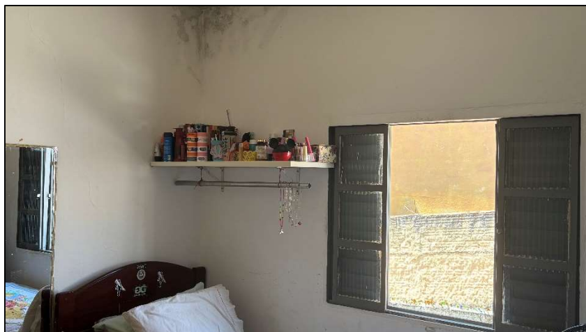
Foto 20. Dormitório 1 da casa térrea
