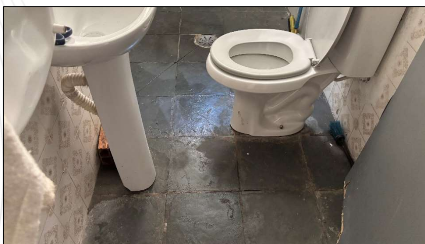
Foto 52. Banheiro da casa inferior 2
