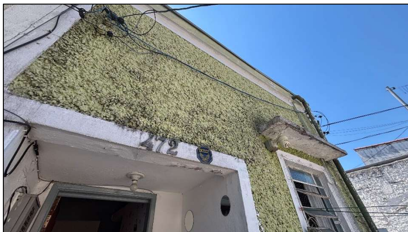
Foto 4. Fachada da casa térrea
