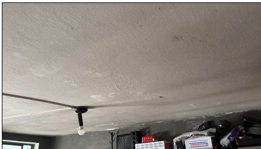
Foto 47. Cozinha da casa inferior 2
