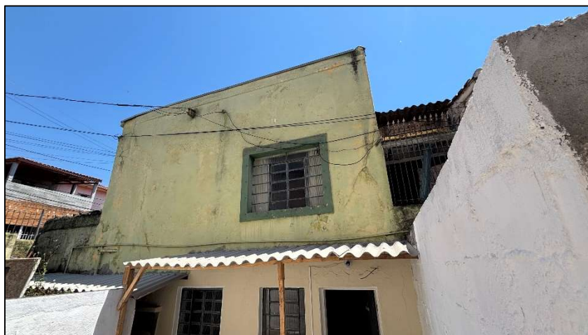
Foto 27. Fachada da casa inferior 1
