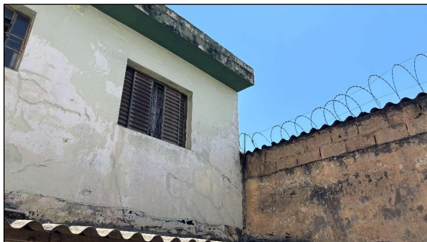
Foto 61. Fachada da casa inferior 3
