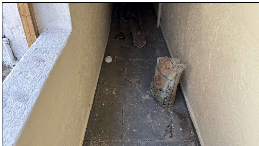
Foto 43. Área de serviço da casa inferior 1
