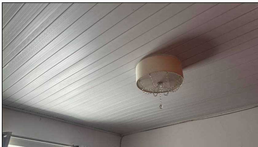
Foto 10. Sala da casa térrea
