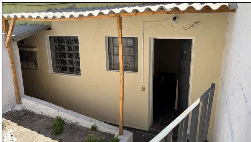
Foto 28. Fachada da casa inferior 1
