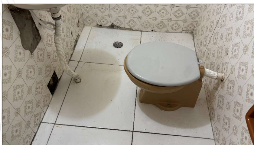
Foto 38. Banheiro da casa inferior 1
