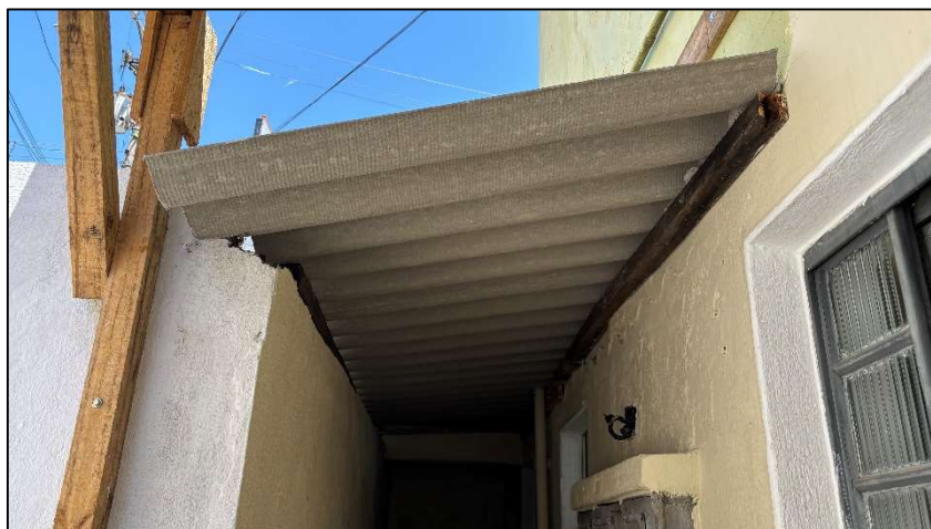
Foto 42. Área de serviço da casa inferior 1
