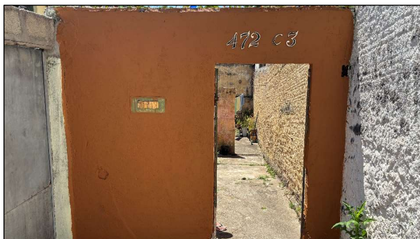
Foto 58. Fachada da casa inferior 3
