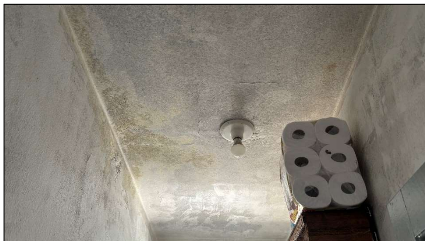
Foto 16. Banheiro da casa térrea
