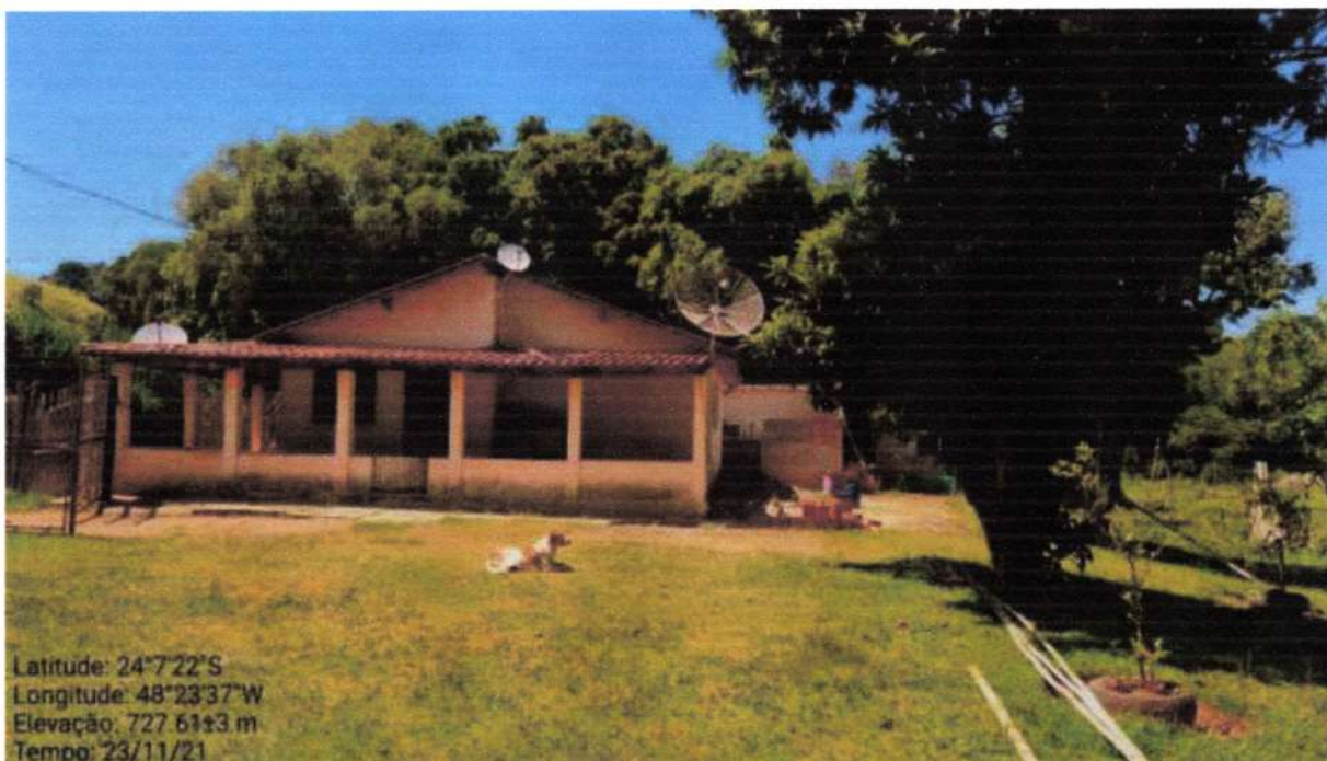
Foto 05 – Fachada Imóvel residencial
