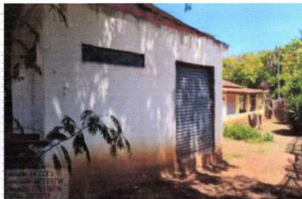
Foto 09 – Galpão usos diversos
