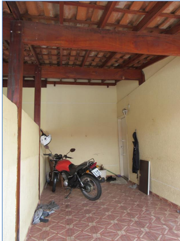
ASPECTOS DA EDIFICAÇÃO - CASA C DO BLOCO 11.
