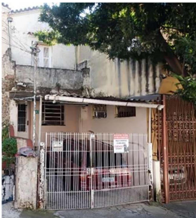
VISTA DA FACHADA DO IMÓVEL SOB O N° 643 OBJETO DA PRESENTE AÇÃO.
