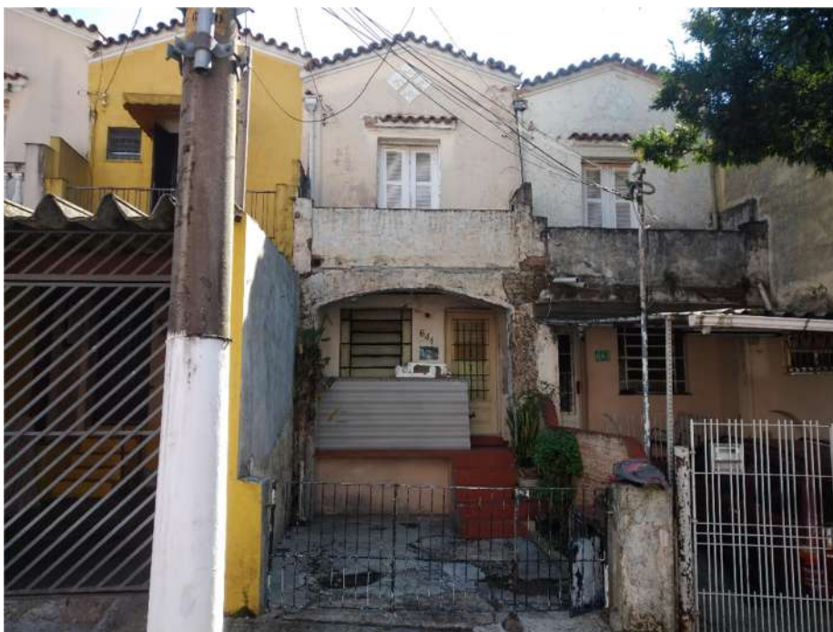
VISTA DA FACHADA DO IMÓVEL SOB O N° 641 OBJETO DA PRESENTE AÇÃO.
