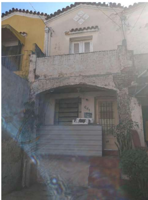
VISTA DA CONSTRUÇÃO ERGUIDA SOBRE O TERRENO.
