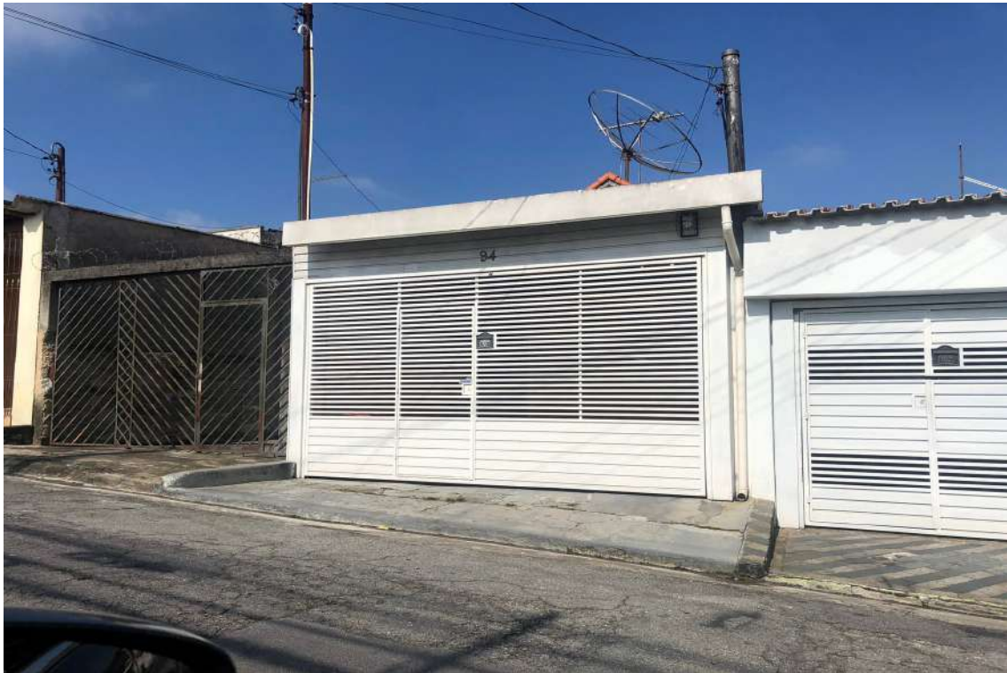
1 - Vista da fachada frontal do imóvel avaliando
