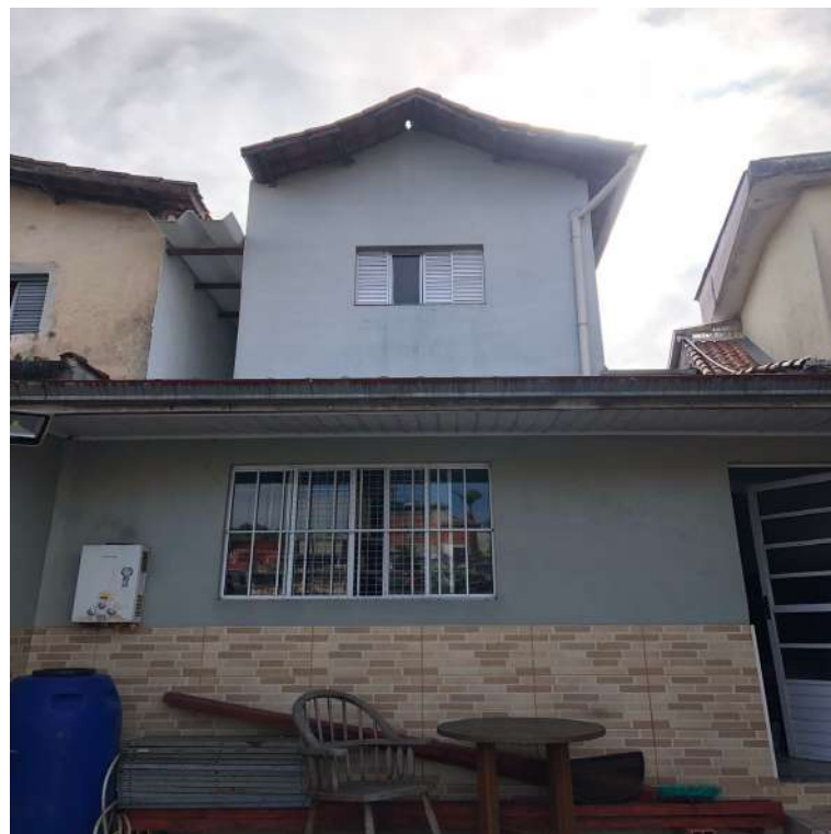
20 - Fachada dos fundos do imóvel - edificação em três pavimentos
