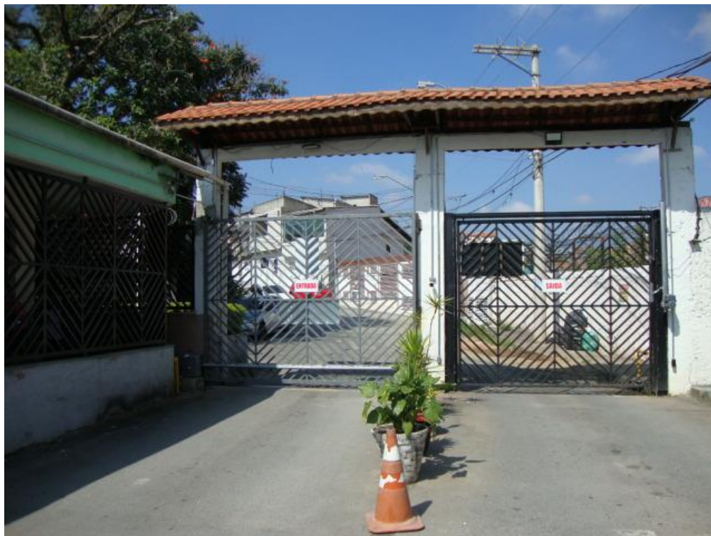
Entrada de Veículos
