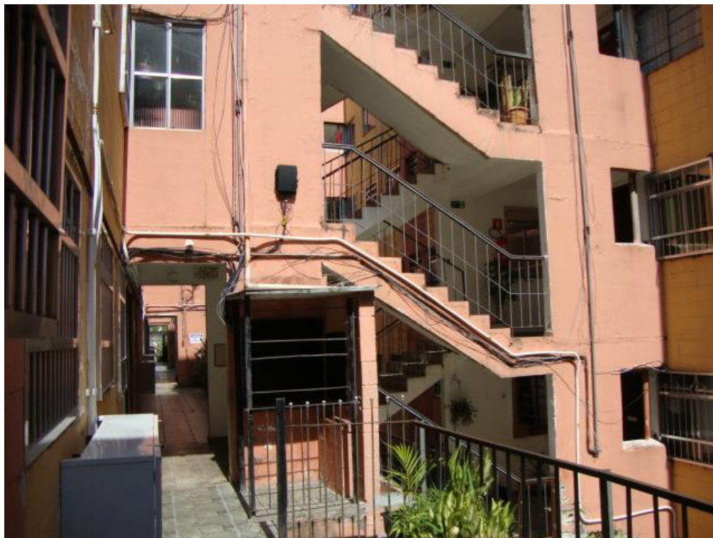
Escadas acesso à unidade
