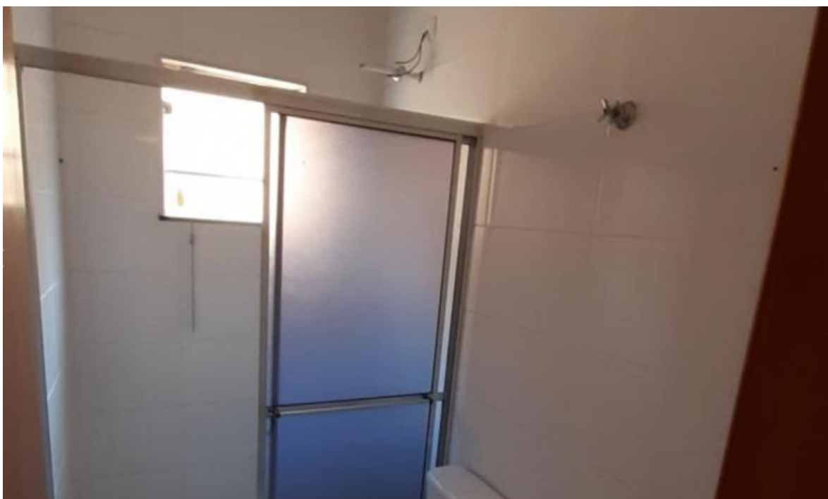
Imagem 04 – Banheiro - azulejo até o teto, esquadria em alumínio, instalações elétricas e hidráulicas embutidas e as Louças e Metais sanitários são no padrão econômico.
