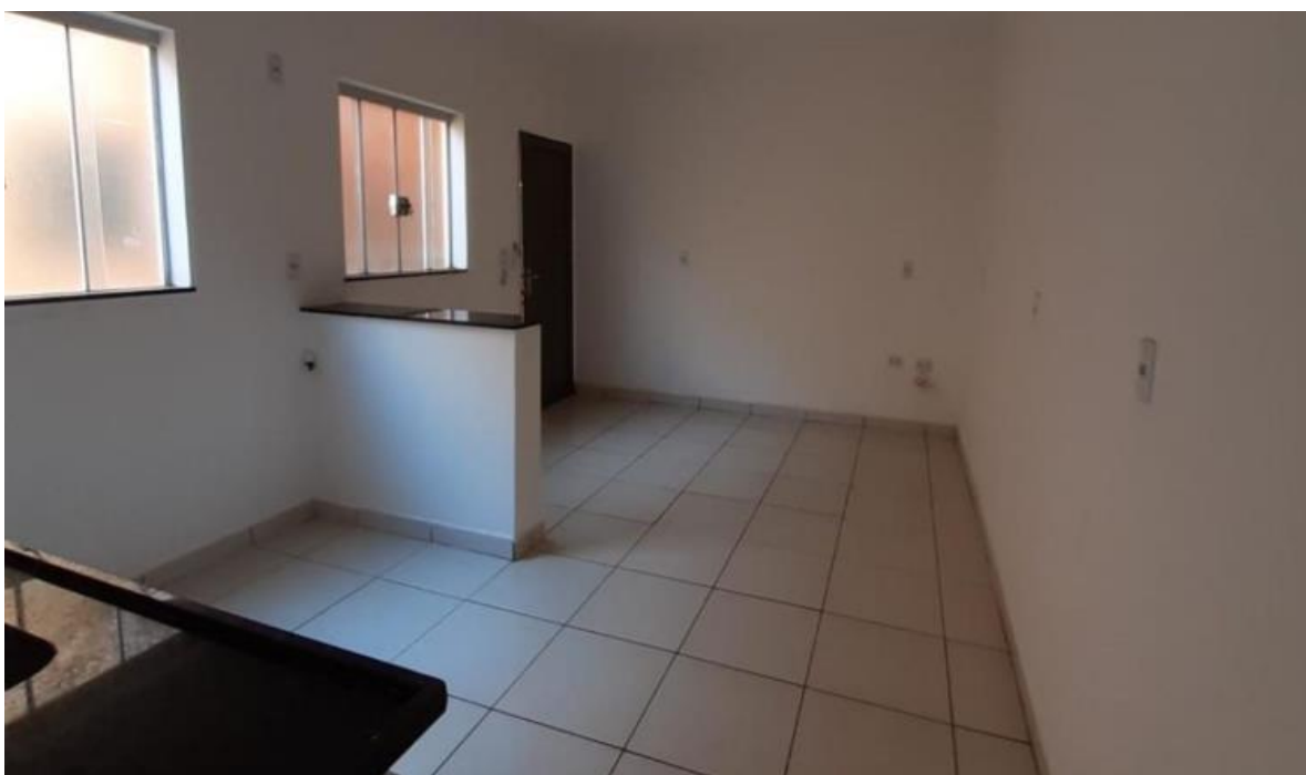
Imagem 02 - O padrão construtivo é de boa qualidade, pisos cerâmicos em todos os ambientes, esquadrias em alumínio, instalações elétricas embutidas e Pintura sobre massa corrida.
