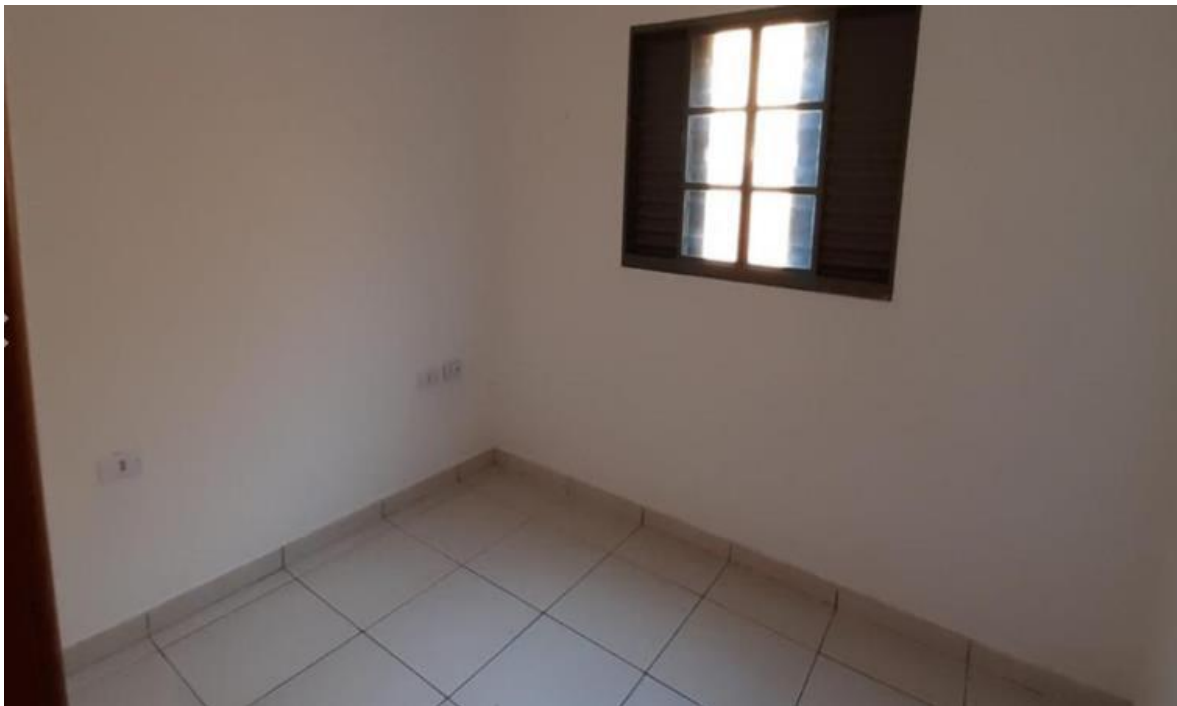
Imagem 05 – Um dos Dormitórios existentes no Apartamento - piso cerâmico, esquadria em metal, instalação elétrica embutida e Pintura sobre massa corrida, bom padrão construtivo.
