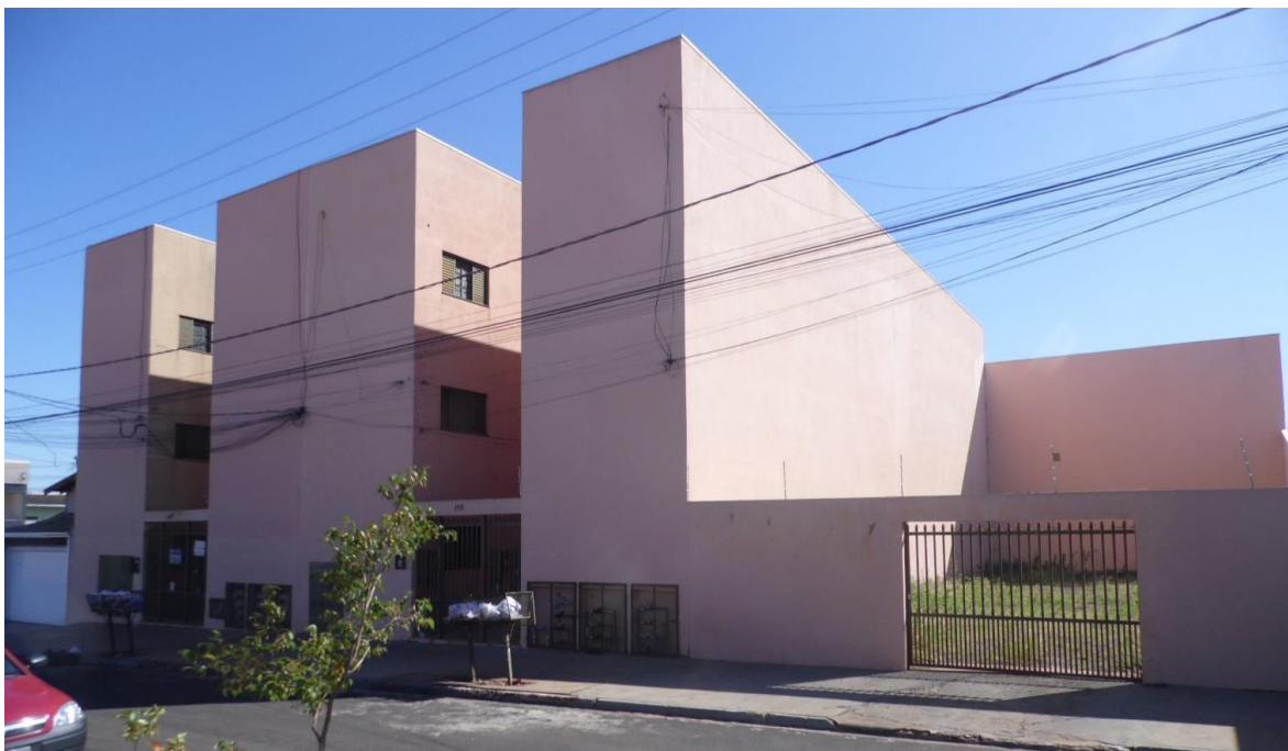
Imagem 01 – Condomínio Residencial Portal - Edifício residencial composto por dois Blocos de Apartamentos na Rua Feliciano Barbosa de Carvalho, nº 165, Portal São Francisco, Assis/SP.
