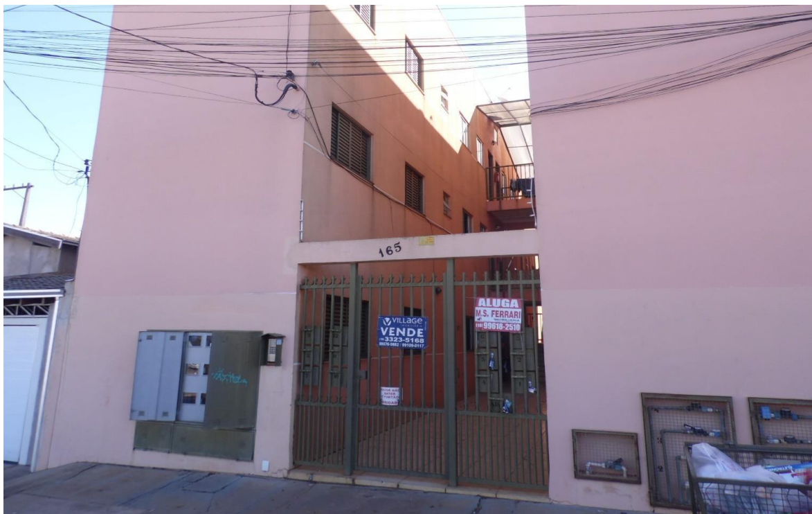
Imagem 02 – Entrada da Bloco de Apartamentos onde está localizado o Apartamento nº 08, Edifício em boas condições em relação a conservação/manutenção e sem Elevadores.
