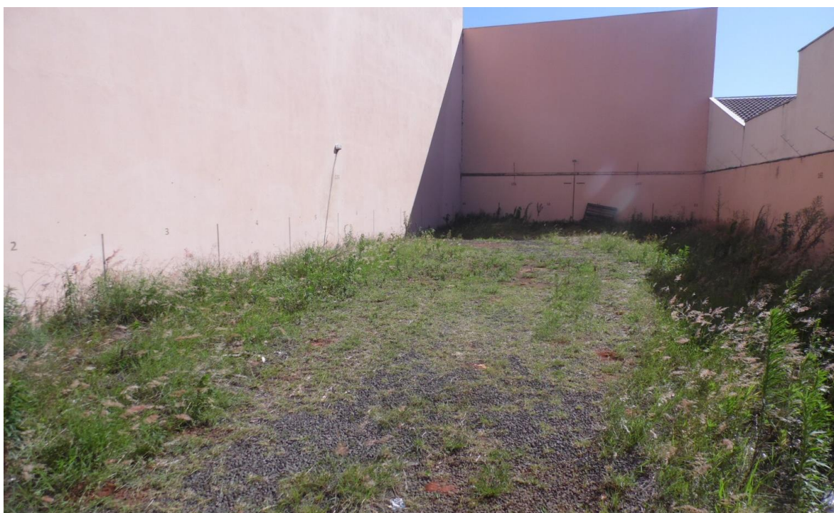
Imagem 03 – Terreno anexo ao Edifício utilizado como Garagem descoberta dos Apartamentos.
