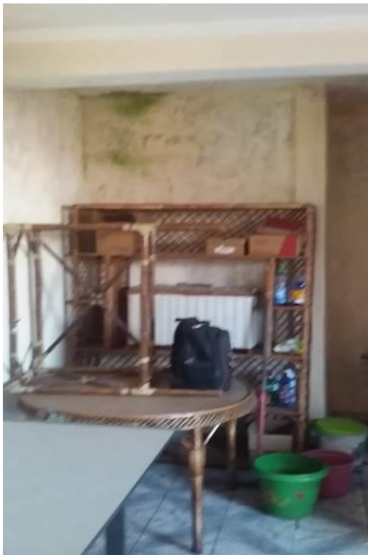
FOTO nº 13 Vista da sala I – pavimento térreo.
