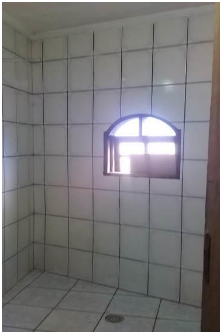
FOTO nº 12 Vista do banheiro – pavimento térreo.
