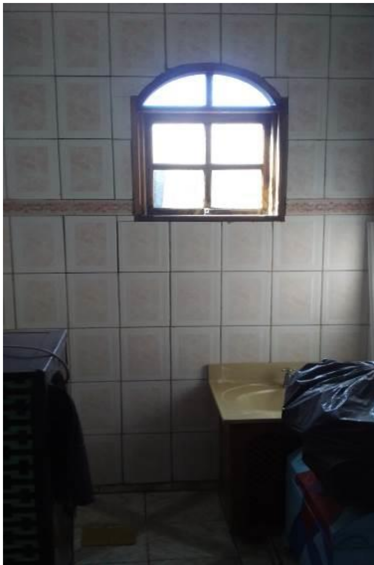
FOTO nº 18 Vista do banheiro - pavimento superior.
