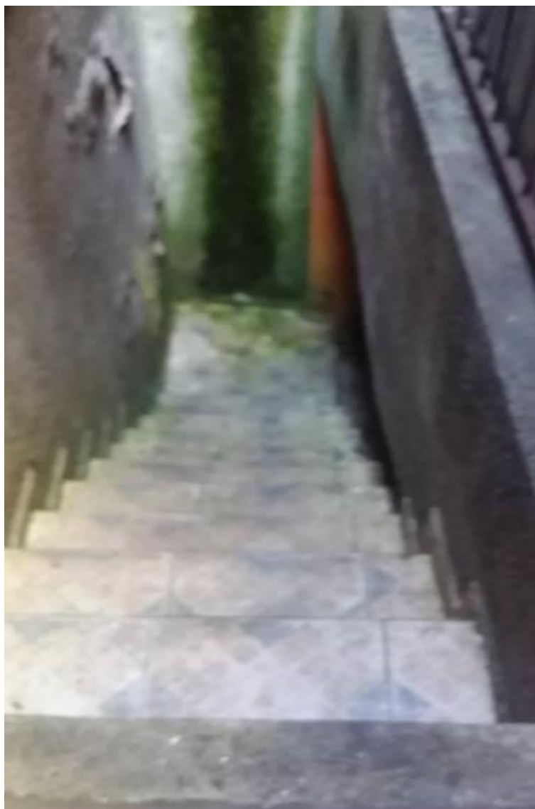
FOTO nº 05 Vista da escada de acesso do subsolo.
