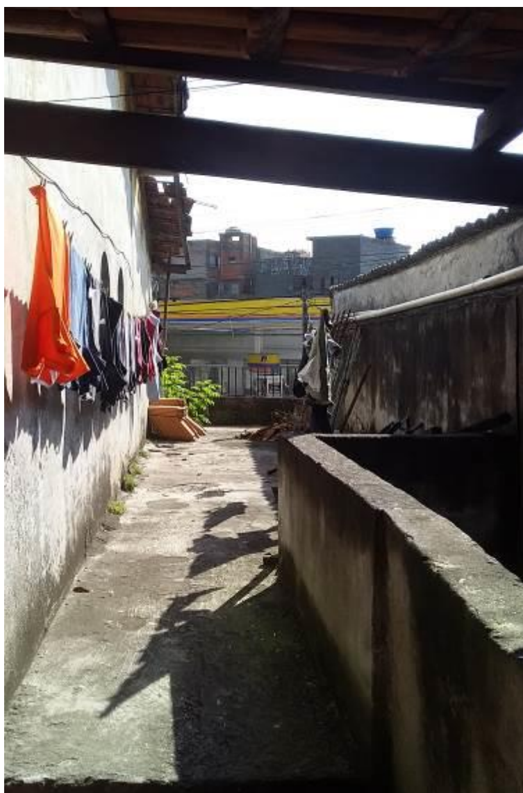
FOTO nº 20 Vista da sacada - pavimento superior.
