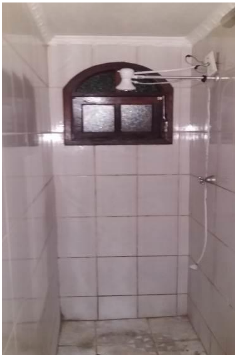
FOTO nº 09 Vista do banheiro - subsolo.
