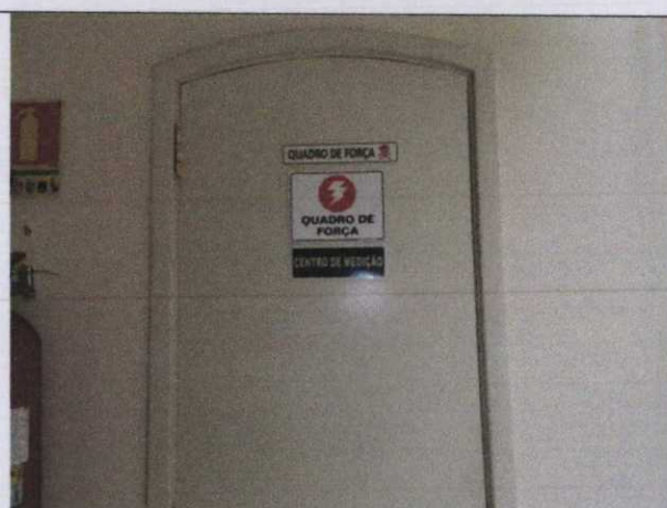
Foto 20 – Quadro de energia desatualizado.
