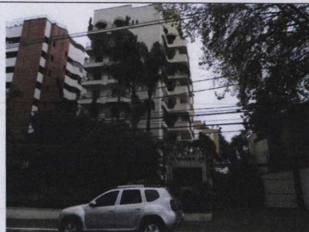
Foto 03 – Vista do Edifício Chamonix.
