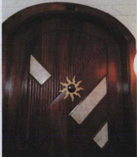
Foto 25 – Entrada do apt. 62(fundos) fechada.
