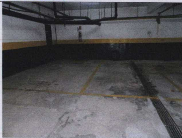
Foto 50 – Vagas de garagem demarcadas do apto avaliado.
