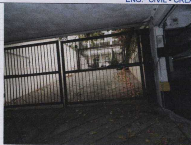
Foto 53 – Saída e entrada de veículos da garagem.
