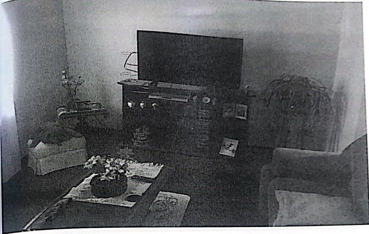
Sala Social com forro e paredes rebocados com pintura, vitrô de ferro com vidros e piso de tacaõ.
