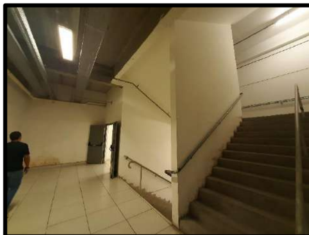
FOTO 18 - HALL DE ESCADAS
