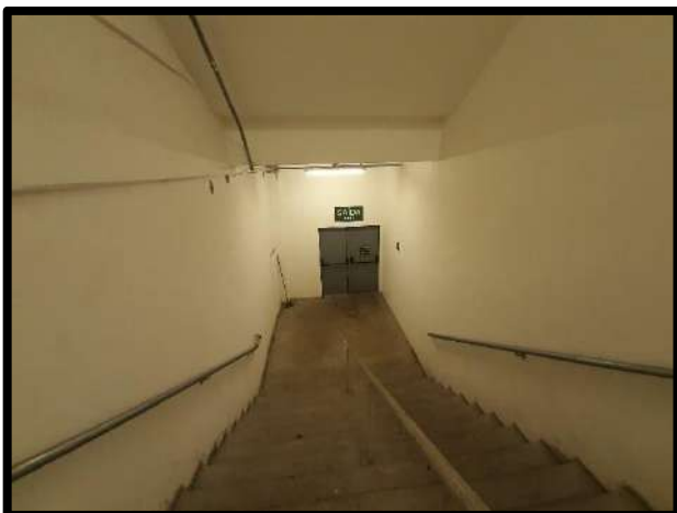
FOTO 15 - ESCADAS DE CIRCULÇÃO
