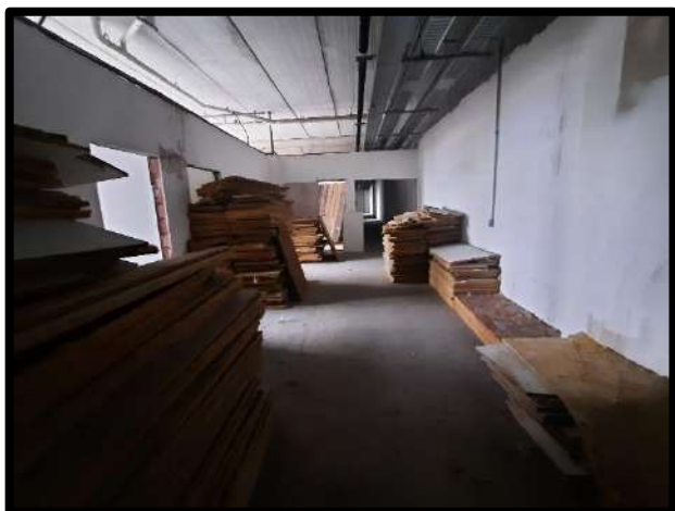
FOTO 25 - SALAS DO 4º PAVIMENTO
