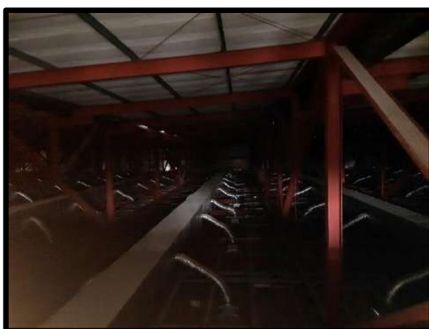
FOTO 40 - VIGAS E SISTEMA DE AR CONDICIONADO
