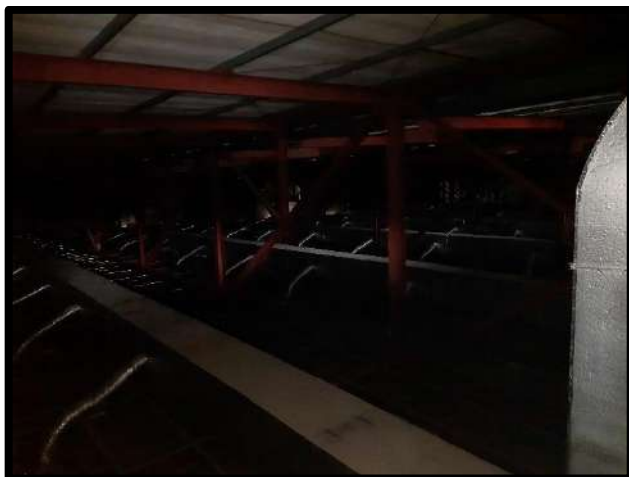
FOTO 42 - VIGAS E SISTEMA DE AR CONDICIONADO
