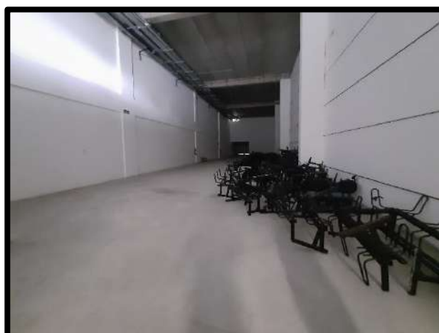
FOTO 20 - SALAS DO 2º PAVIMENTO
