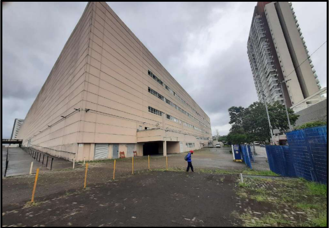
FOTO 1 - FACHADA DO IMÓVEL
