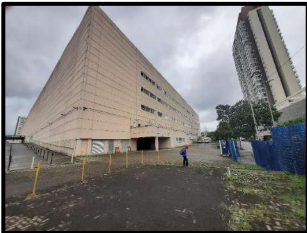
FOTO 11 - FACHADA DO IMÓVEL
