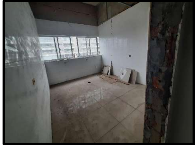
FOTO 28 - BANHEIROS DO 4º PAVIMENTO
