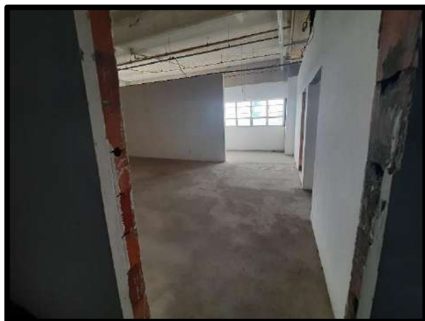
FOTO 26 - SALAS DO 4º PAVIMENTO
