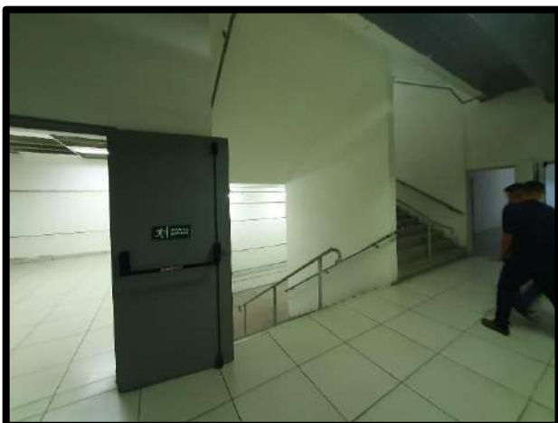
FOTO 17 - HALL DE ESCADAS
