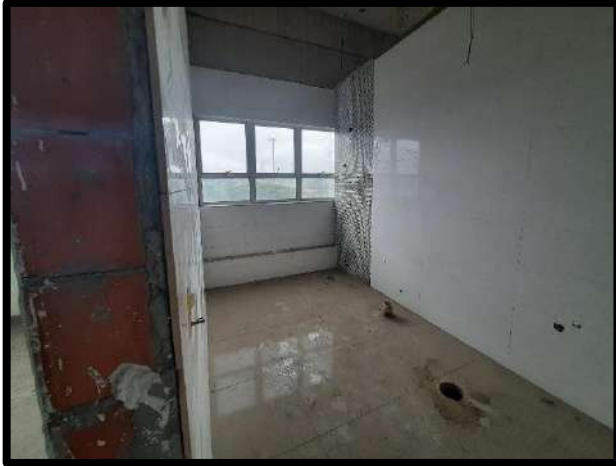
FOTO 27 - BANHEIROS DO 4º PAVIMENTO
