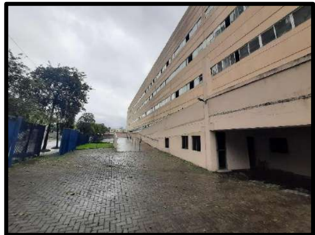
FOTO 12 - FACHADA DO IMÓVEL
