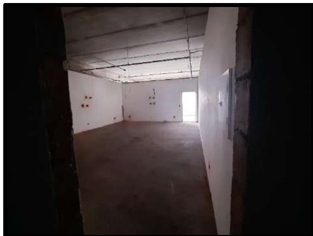
FOTO 22 - SALAS DO 3º PAVIMENTO
