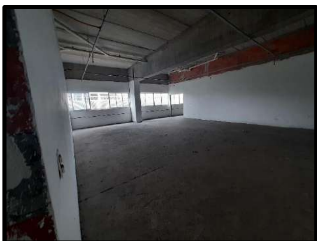
FOTO 23 - SALAS DO 3º PAVIMENTO
