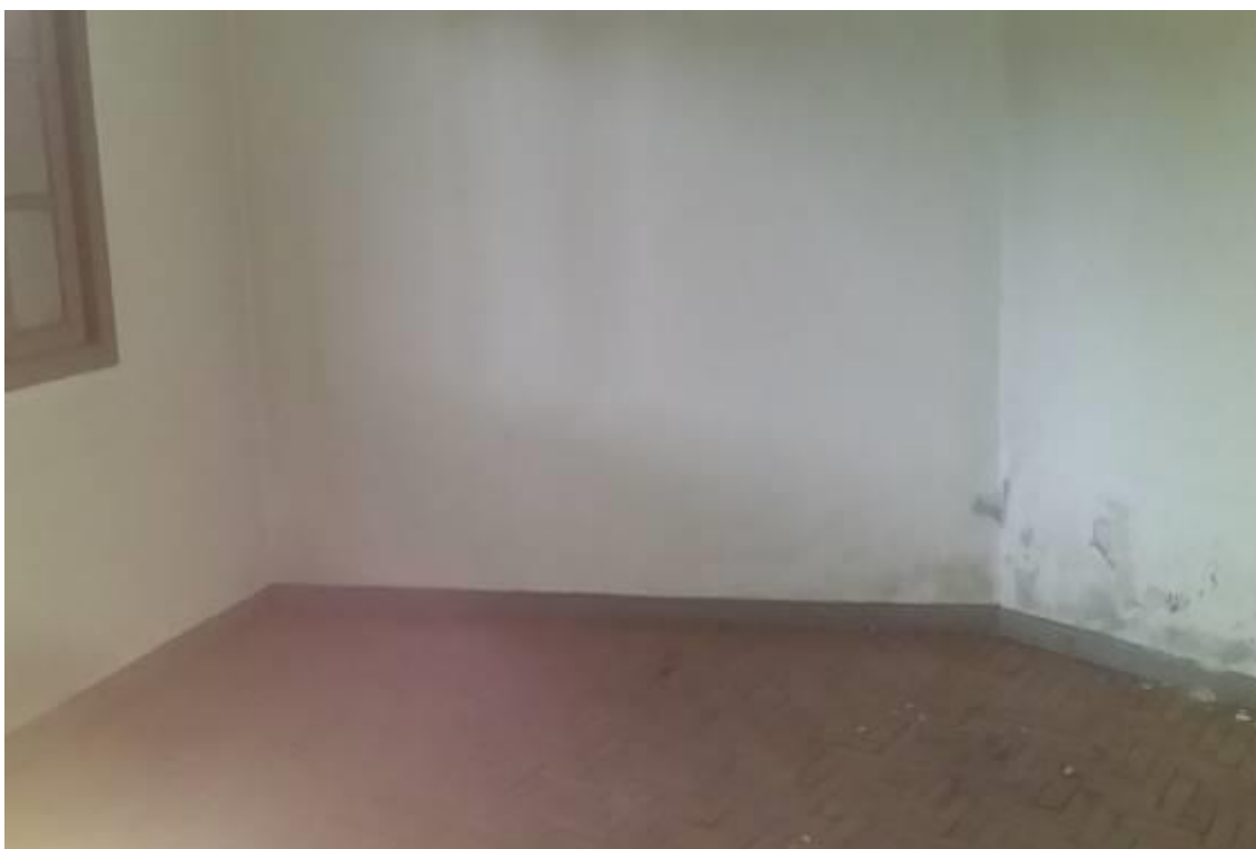
FOTO nº 16 Vista do dormitório I – pavimento superior - construção I.
