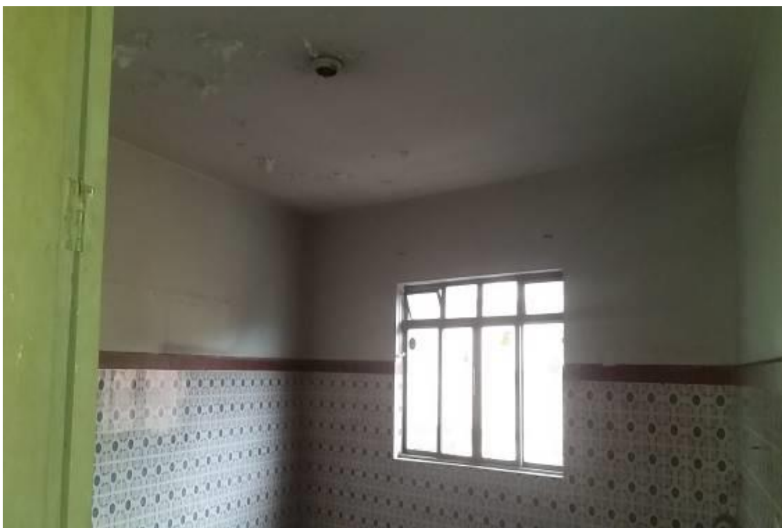
FOTO nº 14 Vista do banheiro – pavimento superior - construção I.
