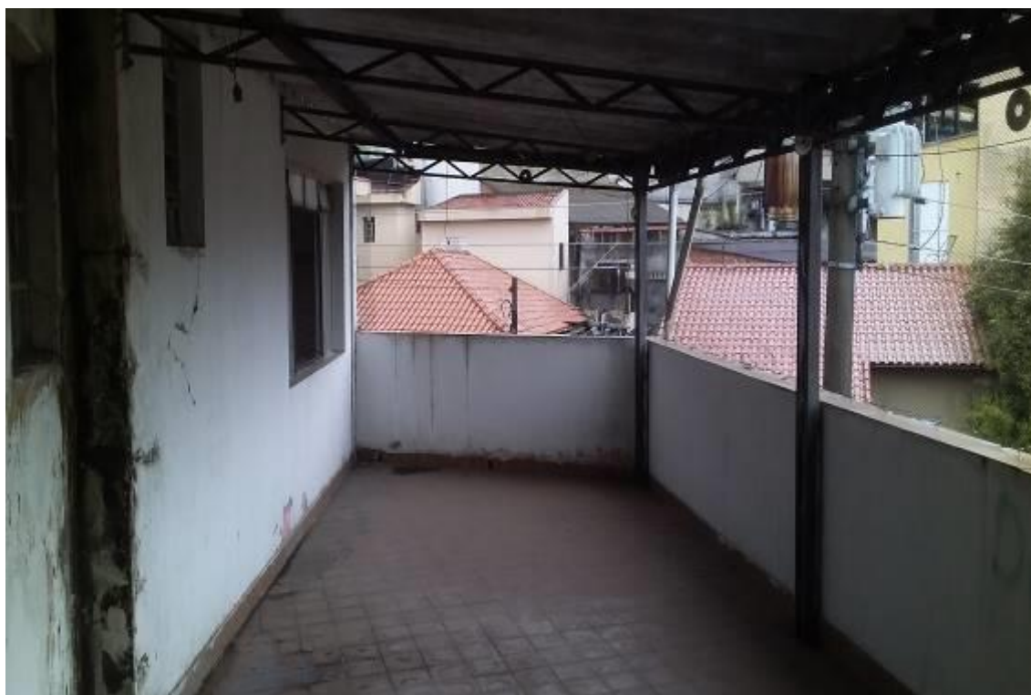
FOTO nº 11 Vista da varanda – pavimento superior - construção I.
