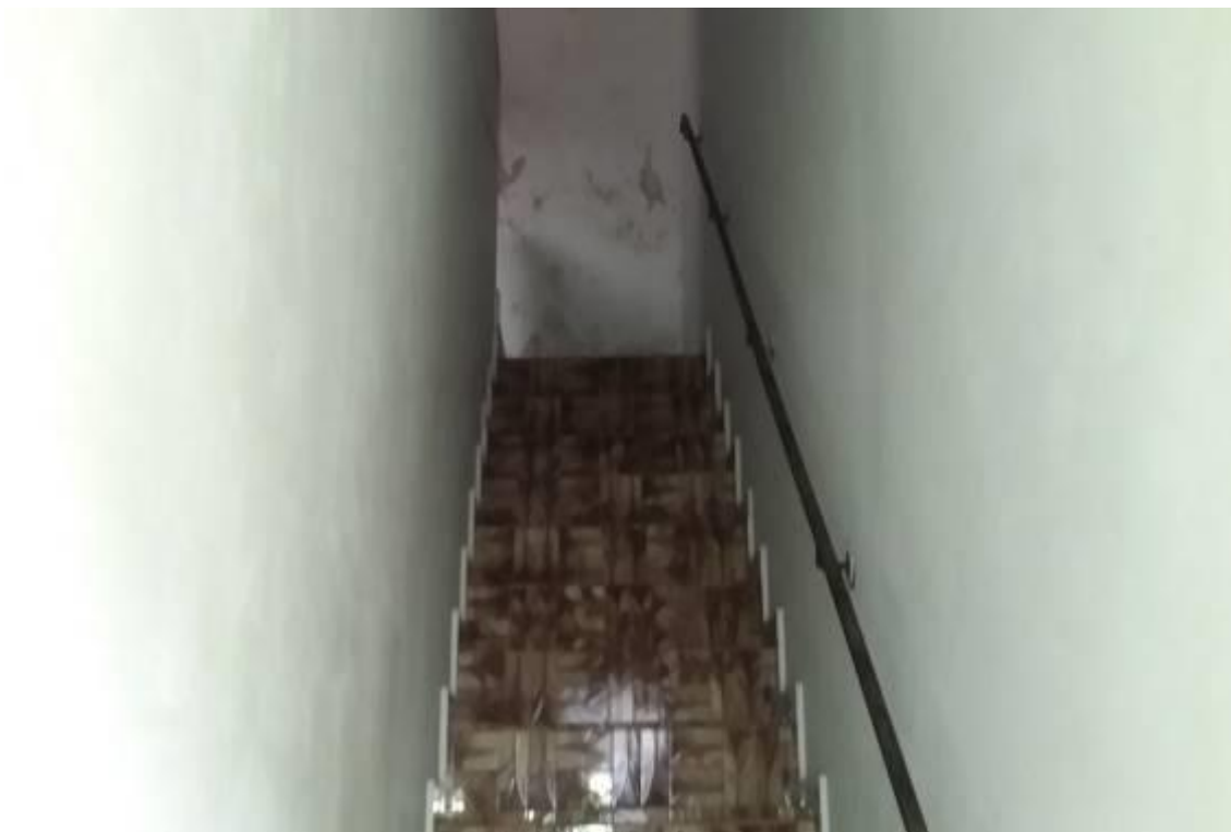
FOTO nº 13 Vista da escada de acesso ao pavimento superior - construção I.
