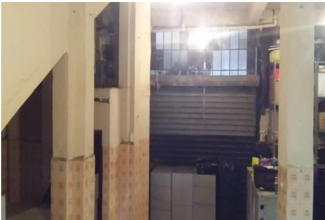
FOTO nº 03 Vista do salão comercial – pavimento térreo - construção I.
