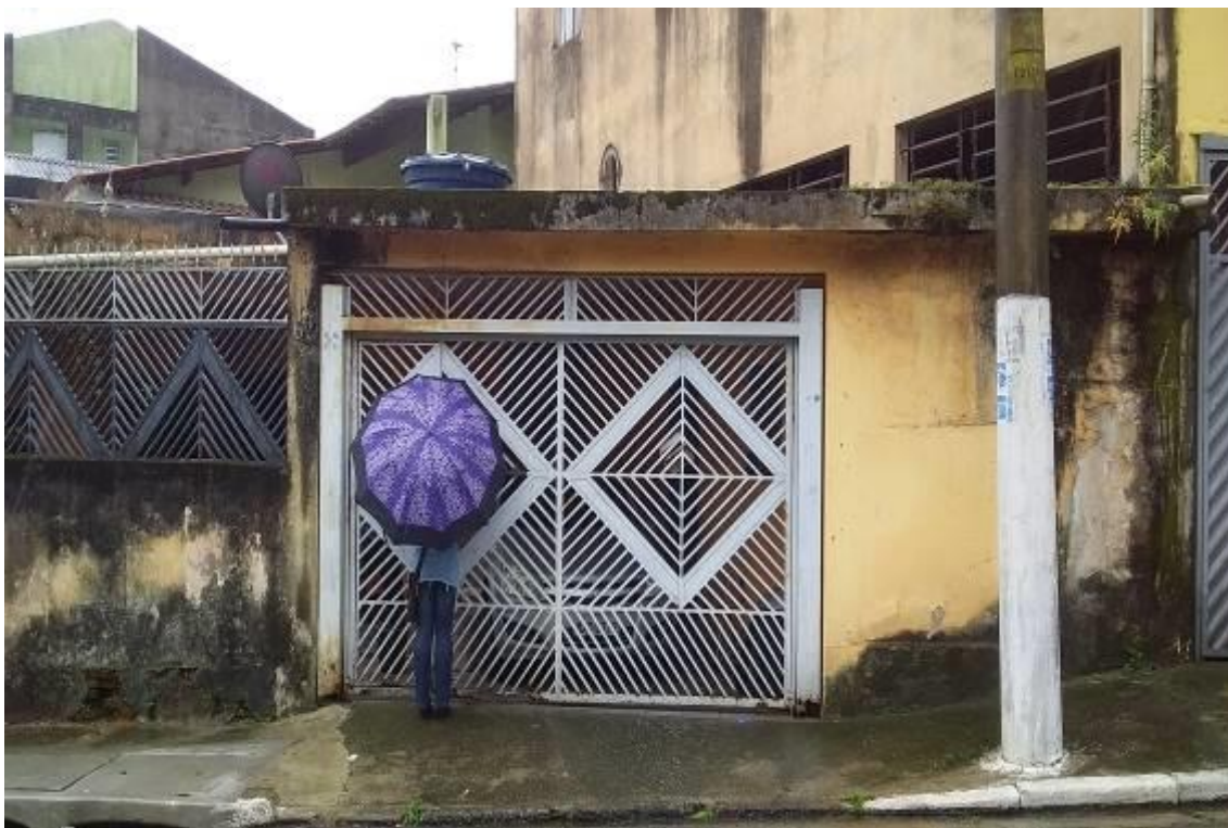
FOTO nº 17 Vista da fachada da construção II.
