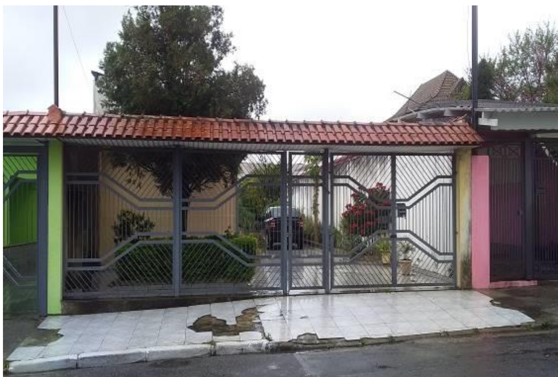
FOTO nº 02 Vista da fachada do imóvel, objeto da ação.
