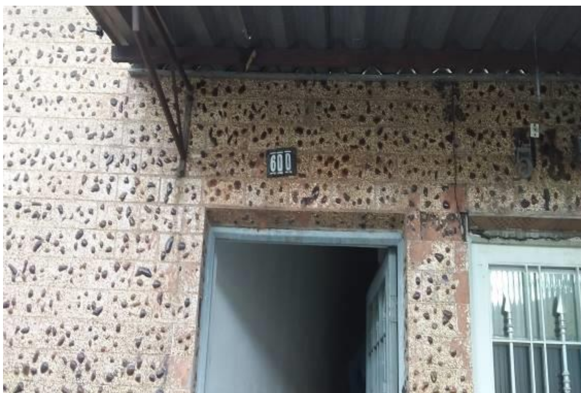
FOTO nº 12 Vista do nº 600, residência no pavimento superior - construção I.
