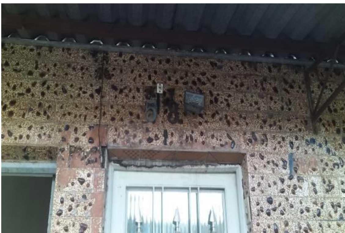
FOTO nº 04 Vista do nº 518, residência no pavimento superior - construção I.
