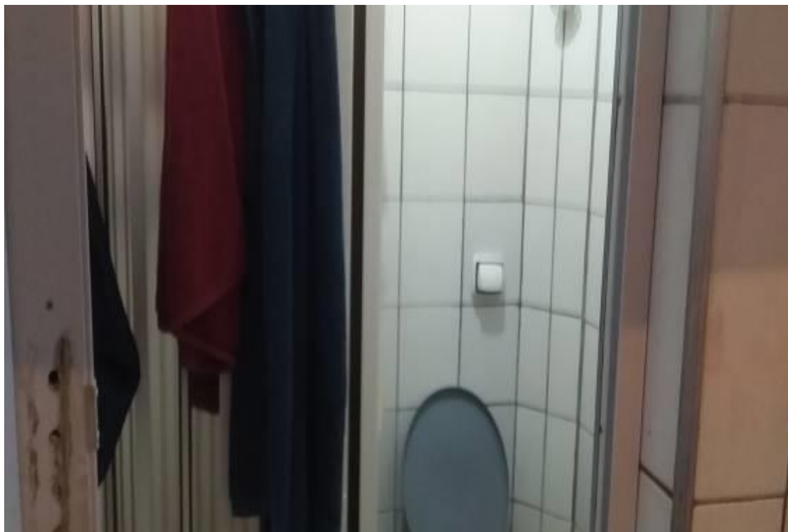
FOTO nº 21 Vista do banheiro - construção II.
