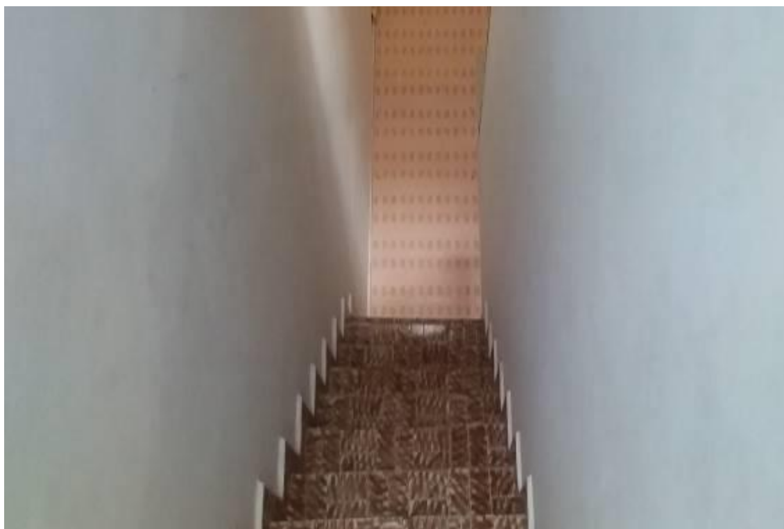
FOTO nº 05 Vista da escada de acesso ao pavimento superior - construção I.
