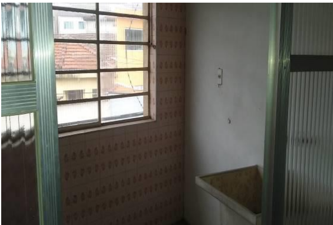
FOTO nº 08 Vista da lavanderia – pavimento superior - construção I.
