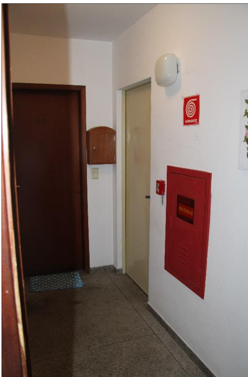
O hall do elevador de serviço.
