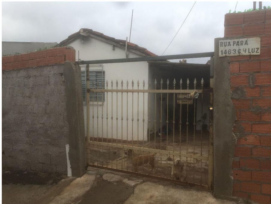
Foto 7 - Vista do imóvel avaliando 2 – Casa 04 nº 1463
