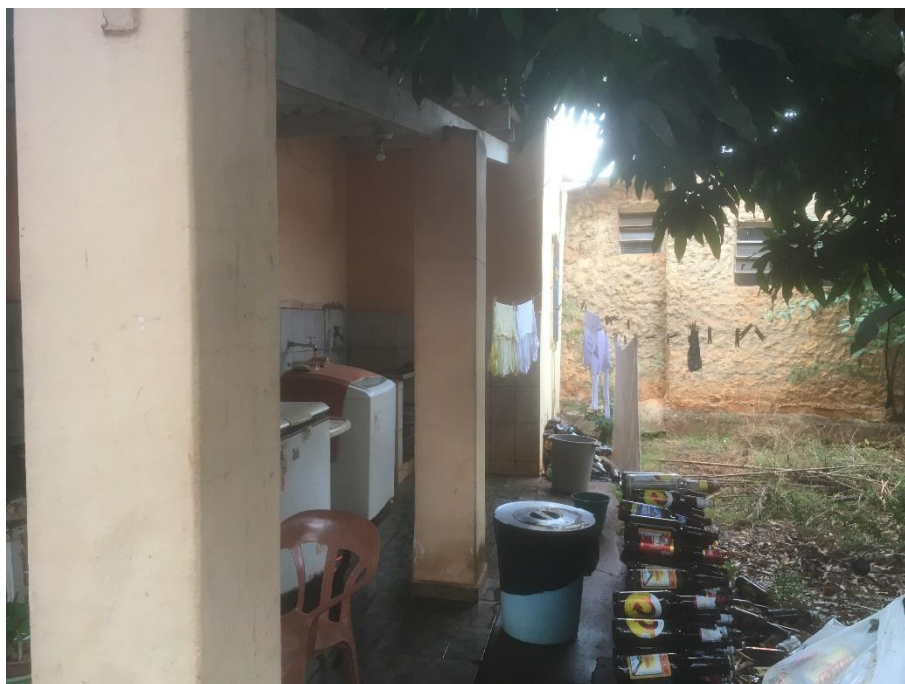
Foto 2 - Área de Serviço / Varando do Imóvel Avaliando 1
