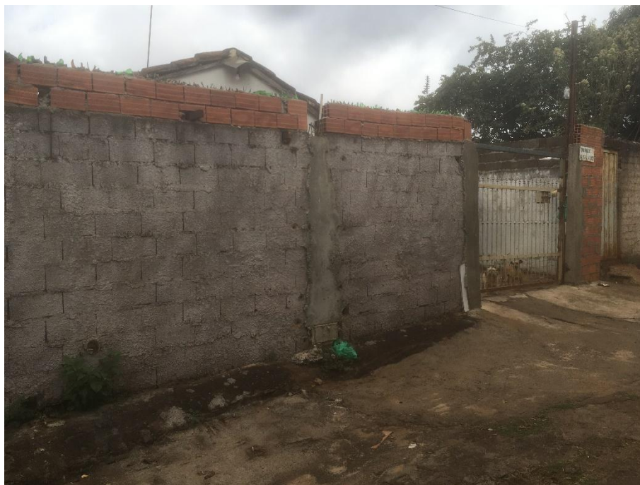
Foto 8 - Outra vista do imóvel avaliando 2
