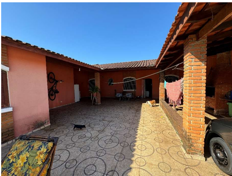
Imagem 5 - Vista geral do imóvel.
