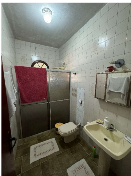
Imagem 15 - Vista geral do banheiro.
