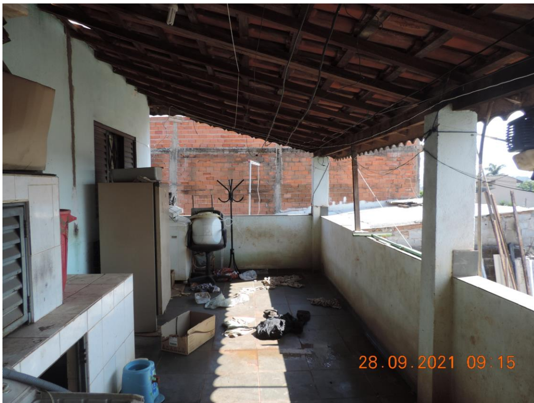
FOTO Nº 11 – COBERTURA NOS FUNDOS DA EDIFICAÇÃO
