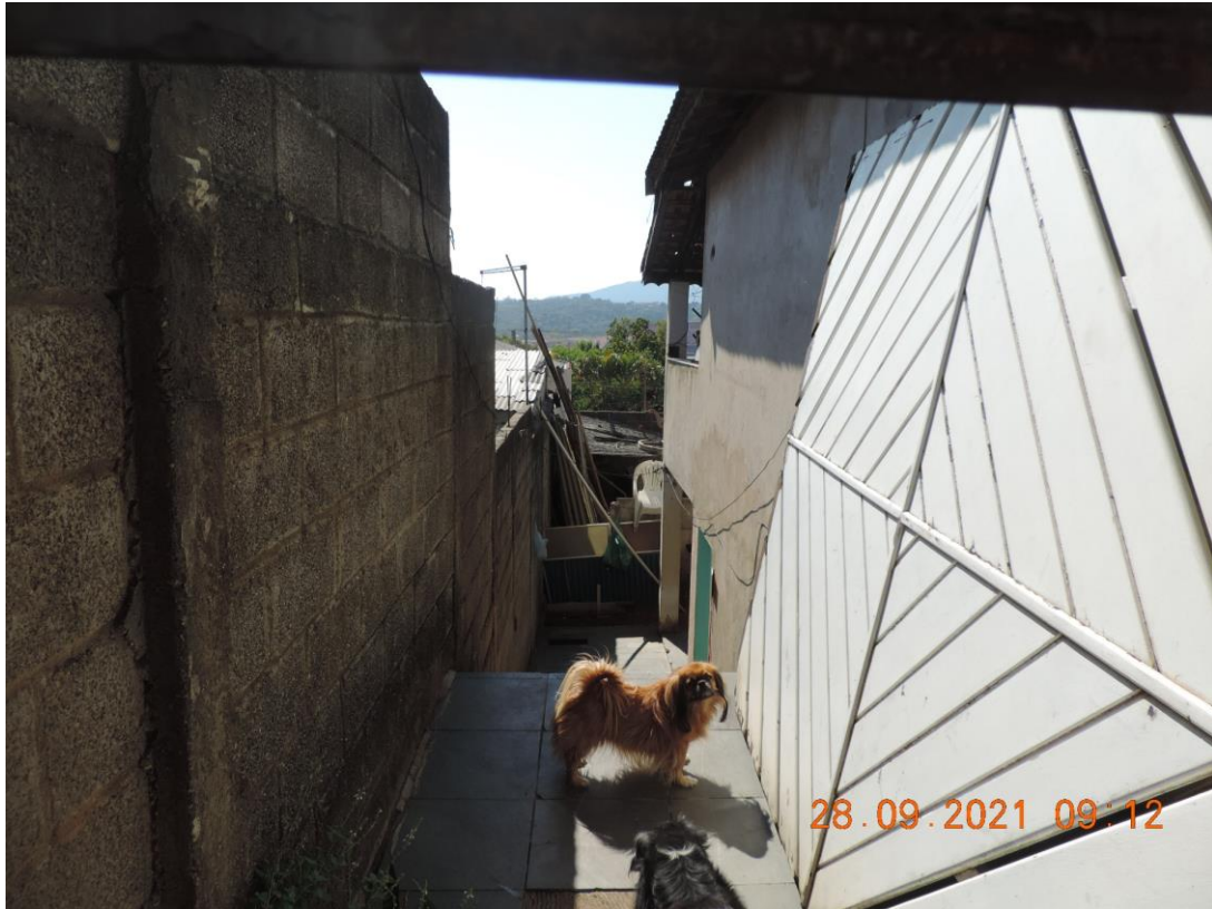
FOTO Nº 05 – CORREDOR LATERAL EXTERNO, ACESSO AOS FUNDOS
