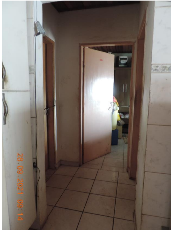
FOTO Nº 09 – CORREDOR DE CIRCULAÇÃO
