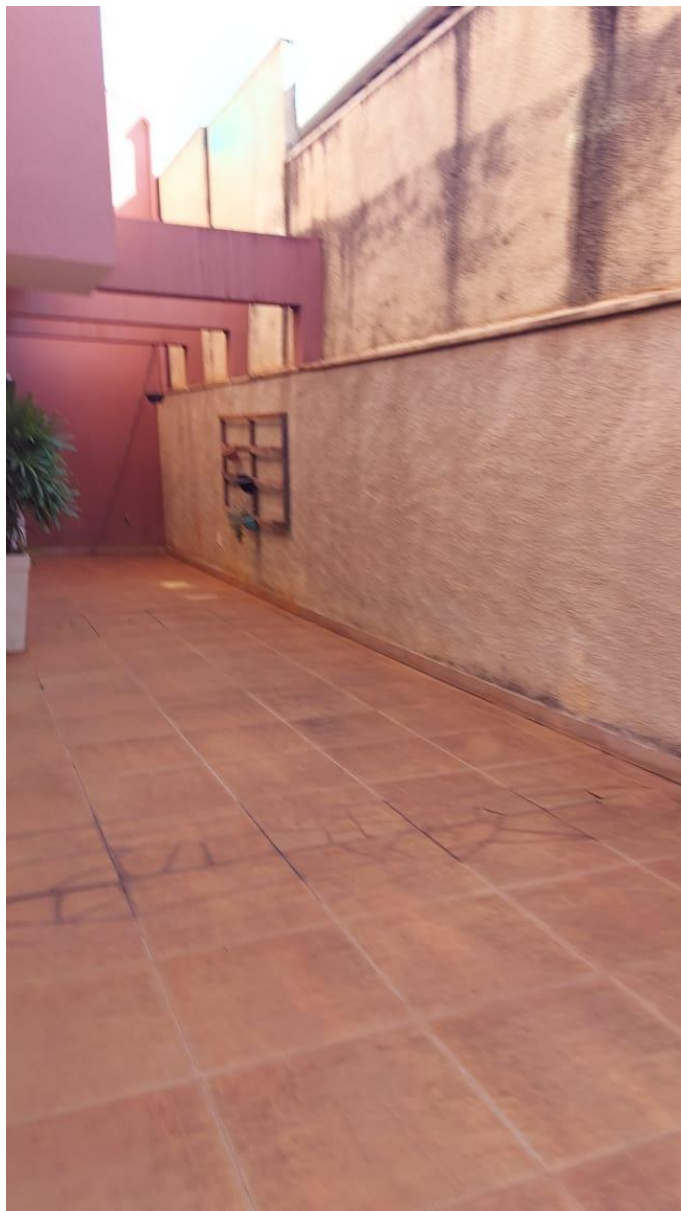
Foto 8: mostra o corredor lateral esquerdo
