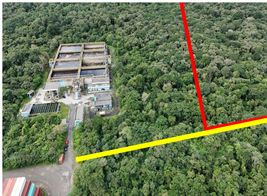
Foto 3 – Vista da Rua de acesso e testada do Imóvel Avaliando
