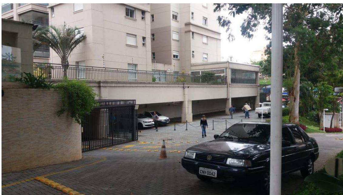
FOTO 01 B – ENTRADA SERVIÇO COND. MANSÃO IMPERIAL
