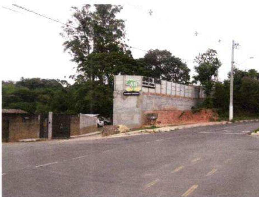
23- Via de acesso ao condomínio
