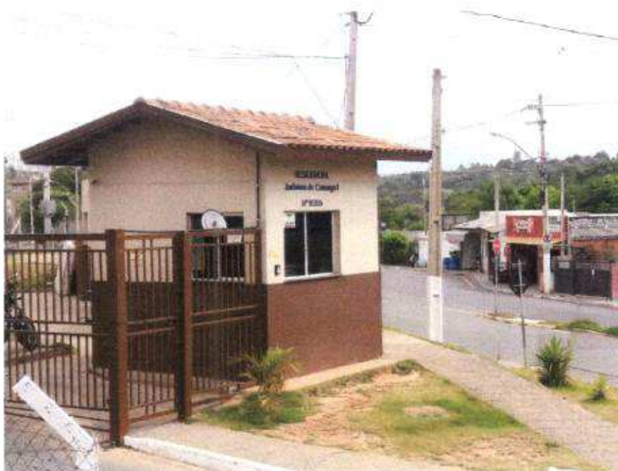
1- Portaria – Entrada Condomínio Residencial Gerônimo I
