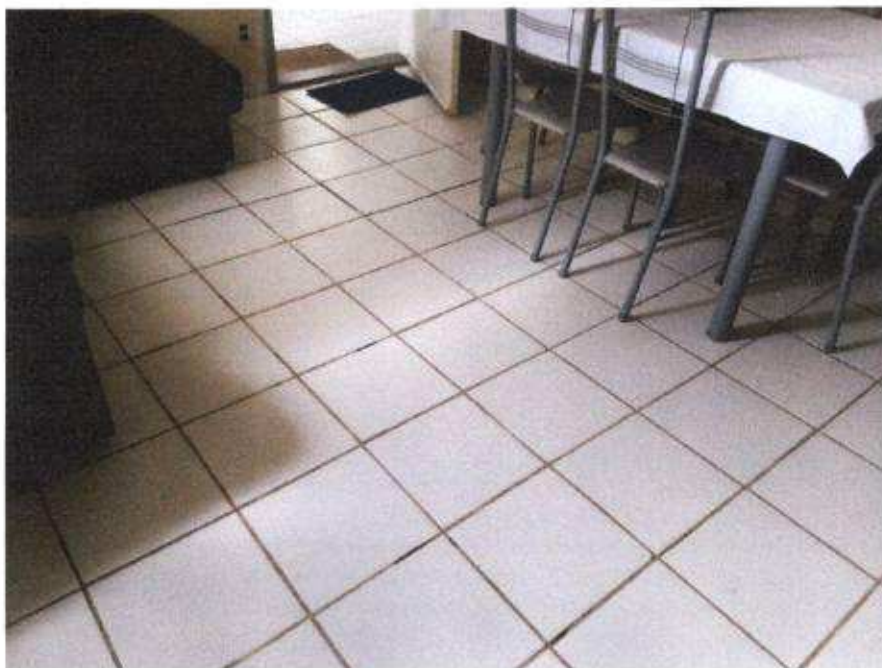
5- Apartamento 13 – Sala de estar – detalhe do piso
