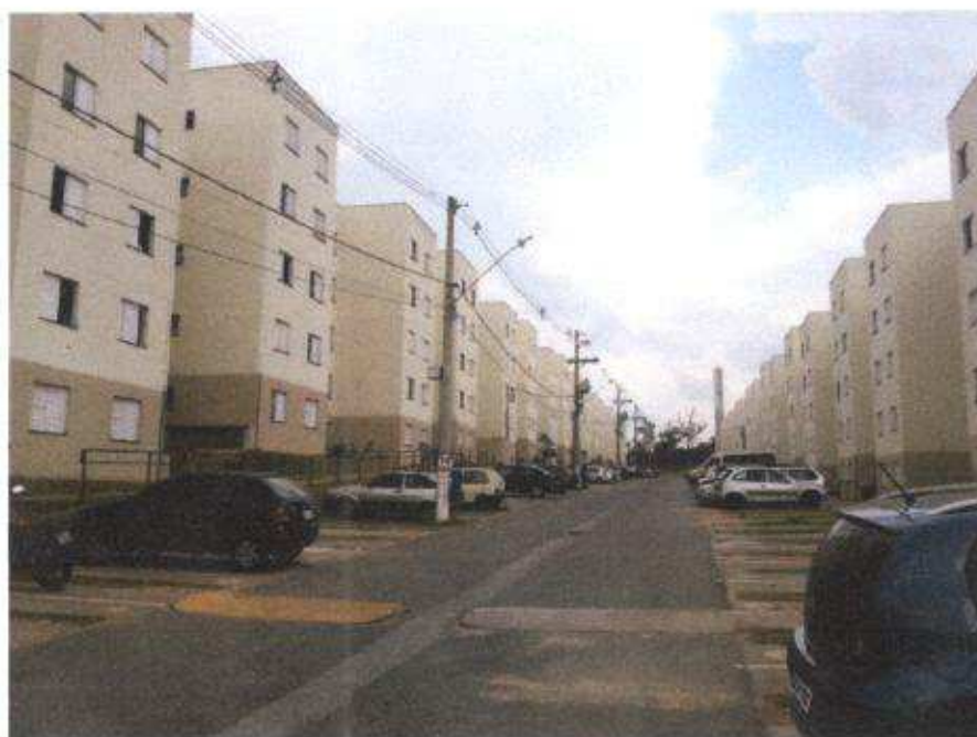
20- Via de acesso às torres
