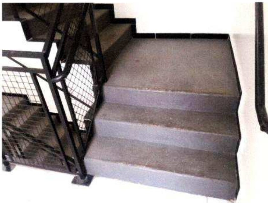
8- Acesso aos pavimentos
