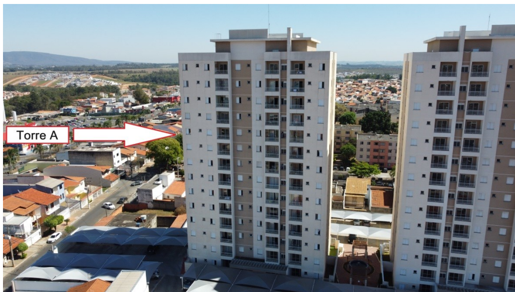
Matricula 91.208, Apartamento nº 02, localizado no térreo da Torre A
