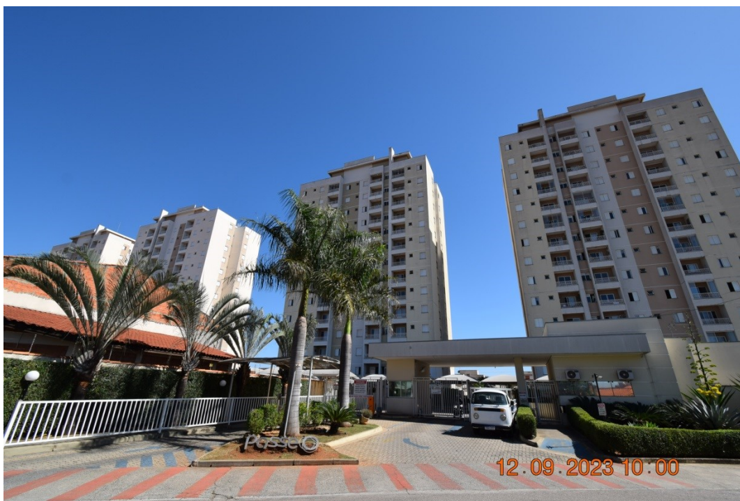
Vista do Imóvel Avaliando
