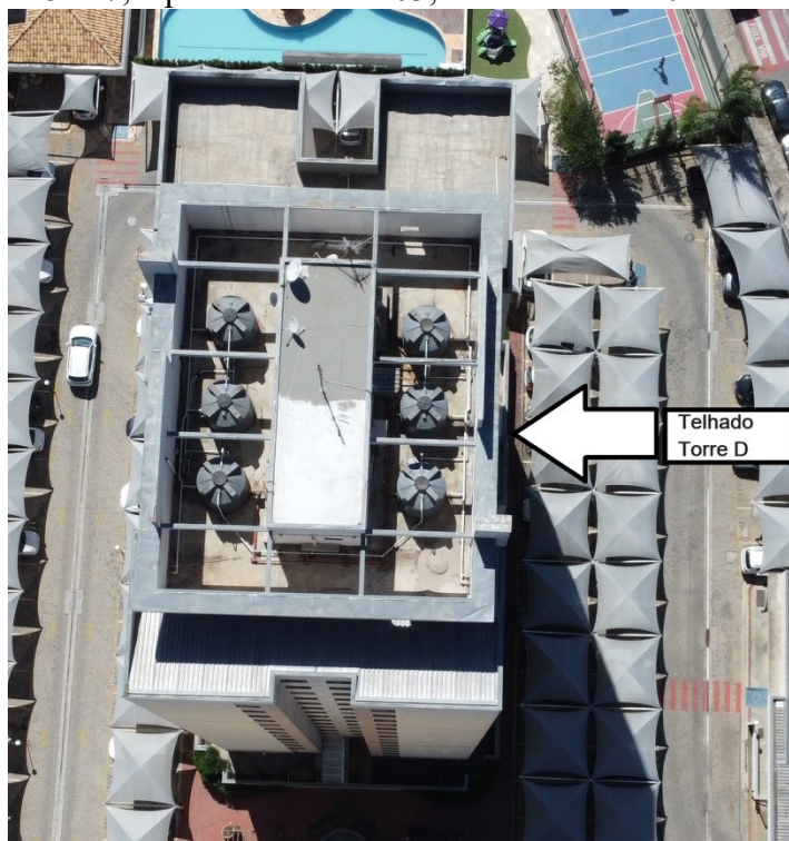
Telhado Torre D.
