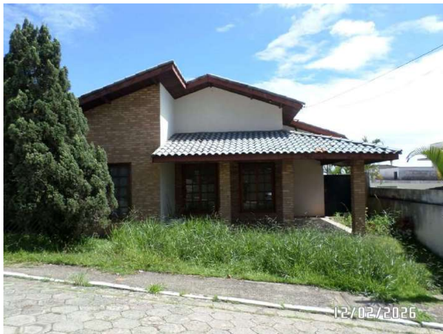
FOTO N ° 02 – VISTA PARCIAL DO IMÓVEL AVALIANDO - FACHADA.
