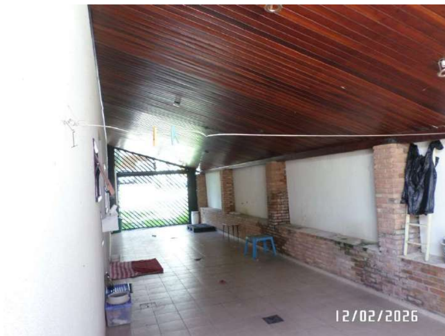
FOTO N ° 22 – VISTA PARCIAL DO IMÓVEL AVALIANDO – GARAGEM.
