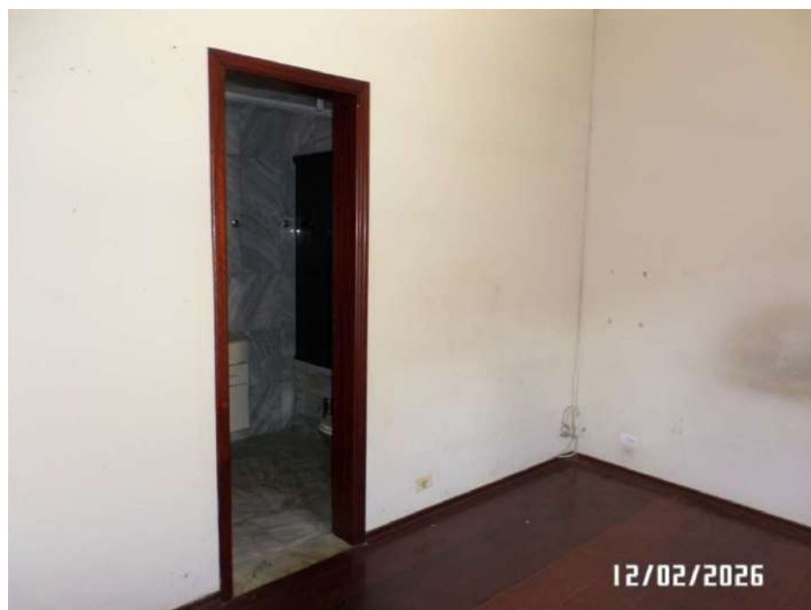
FOTO N º 11 – VISTA PARCIAL DO IMÓVEL AVALIANDO – SUÍTE MASTER.
