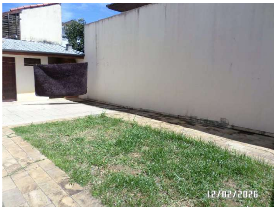
FOTO N º 19 – VISTA PARCIAL DO IMÓVEL AVALIANDO – QUINTAL.
