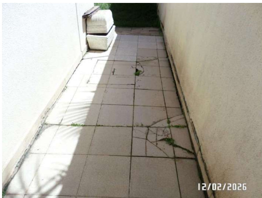
FOTO N º 18 – VISTA PARCIAL DO IMÓVEL AVALIANDO – CORREDOR EXTERNO.
