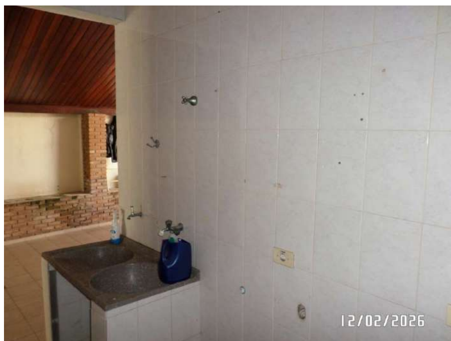
FOTO N º 10 – VISTA PARCIAL DO IMÓVEL AVALIANDO – ÁREA DE SERVIÇO.
