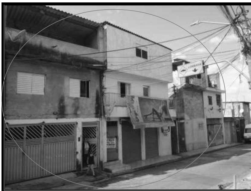
Vista das fachadas do imóvel, com diversas casas edificadas.
