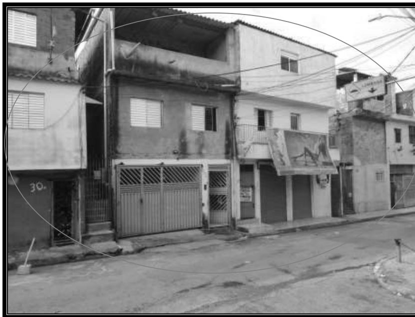
Rua Paulo Lazzetti, nº 30a, 309, 310, 313 e 31b.
