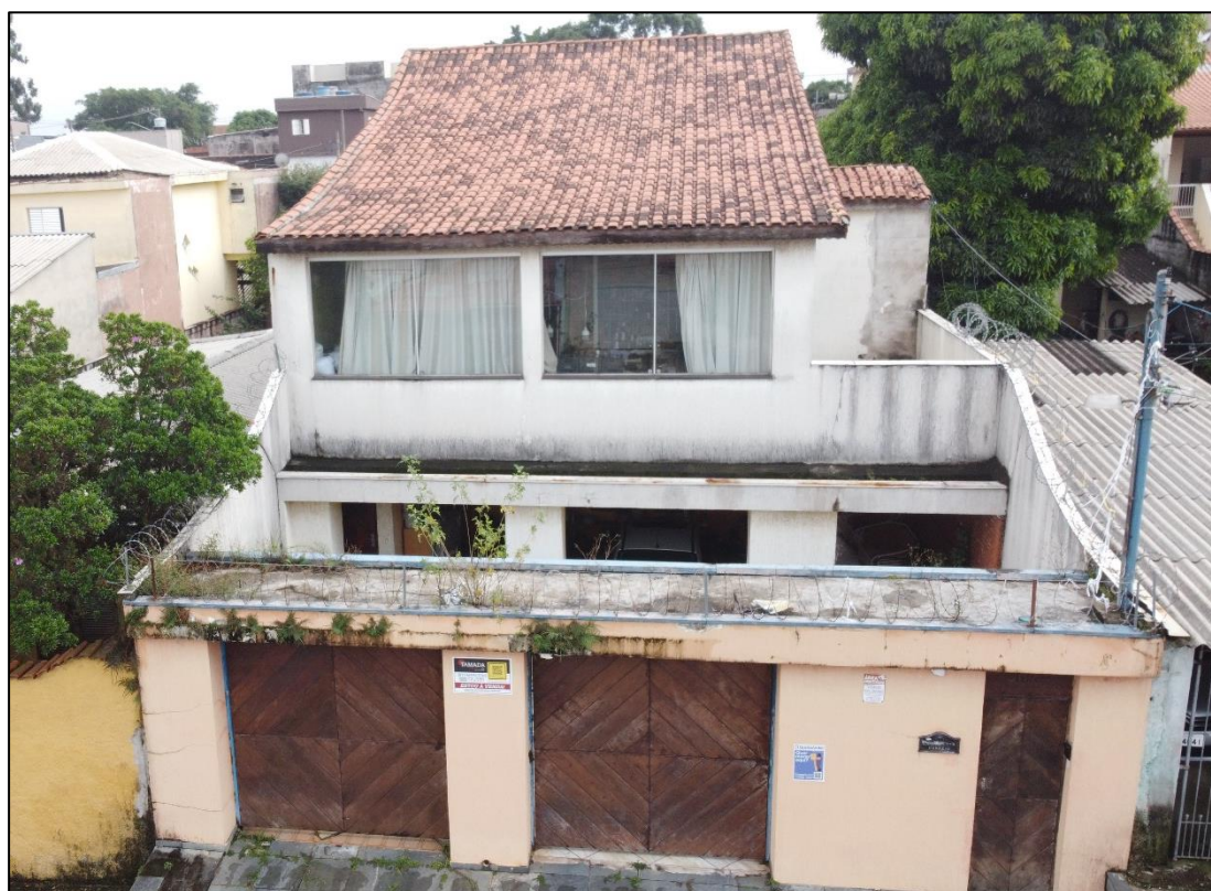
Fachada do imóvel avaliando.
