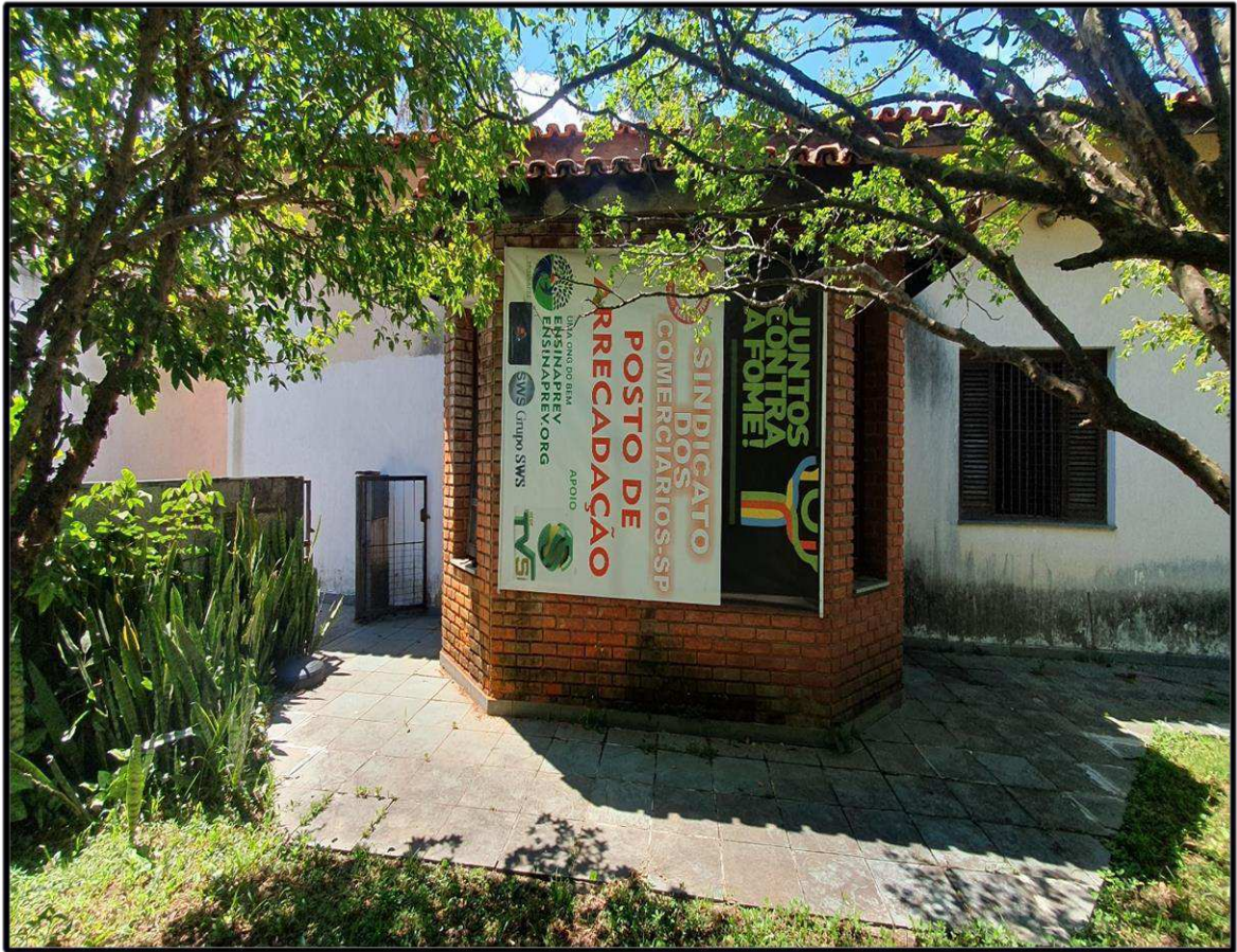
Foto 5 - Outra vista da fachada.
