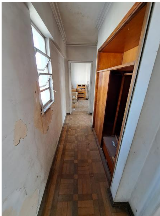
FOTO 21: Corredor de acesso aos dormitórios.
