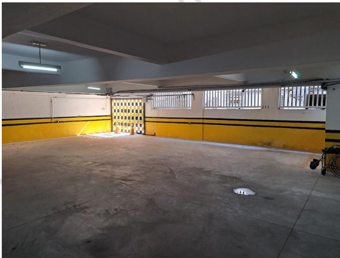
FOTO 03: Acesso de veículo pelo lado interno
