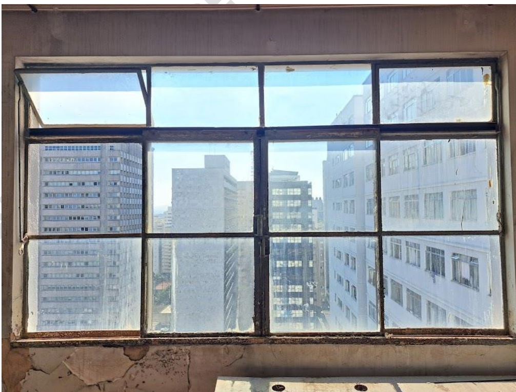
FOTO 26: Dormitório 02 – janela existente em ferro.
