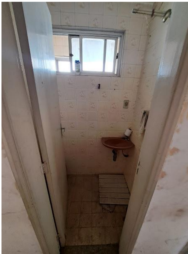
FOTO 13: Sanitário, segundo cômodo.
