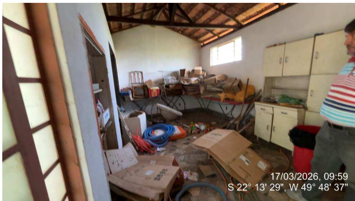
25. Vista interna da Benfeitoria 7, utilizada como depósito de materiais.
