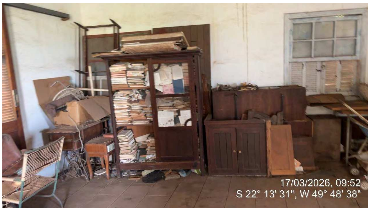
17. Vista interna do piso superior da Benfeitoria 5, utilizada como depósito de materiais.
