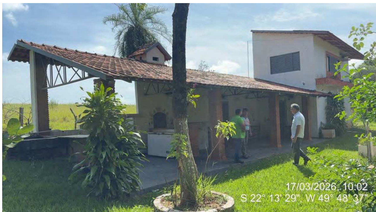
27. Vista da Benfeitoria 8, utilizada como área de lazer.
