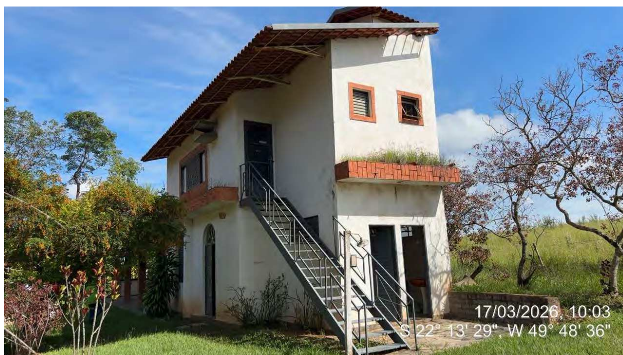
30. Vista da Benfeitoria 8, utilizada como área de lazer.
