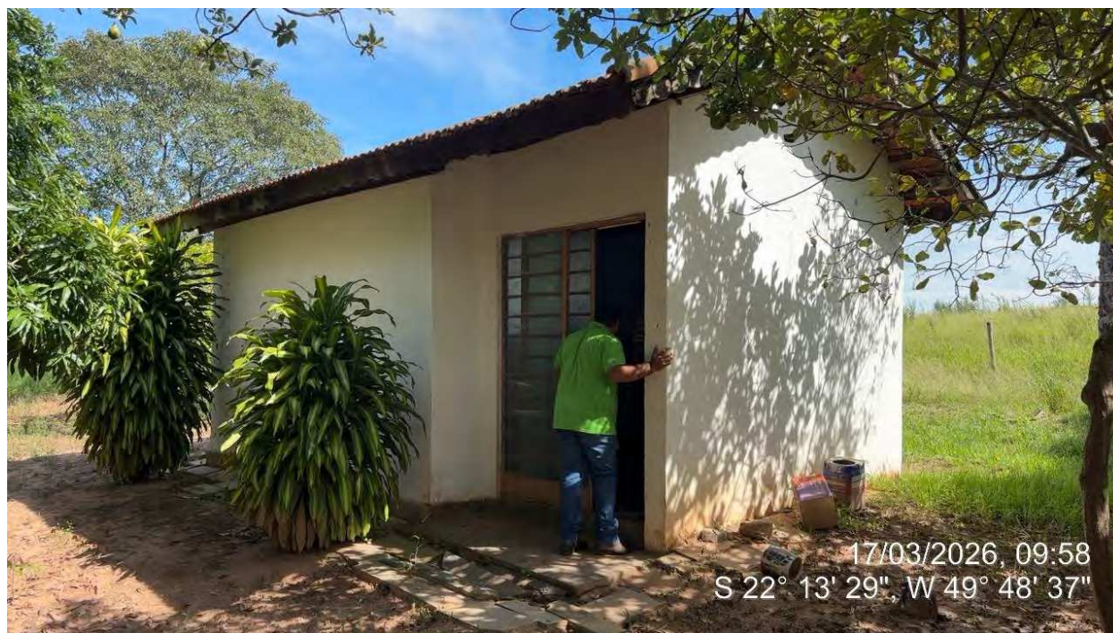
24. Vista da Benfeitoria 7, utilizada como depósito de materiais.
