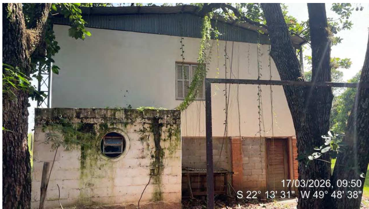
15. Vista da Benfeitoria 5, utilizada como depósito de materiais.
