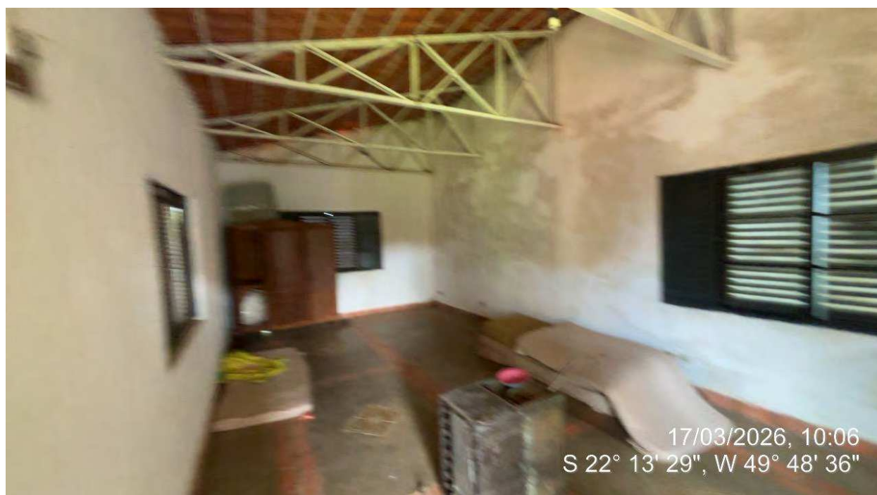
34. Vista da sala localizada no piso superior da Benfeitoria 8, utilizada como área de lazer.
