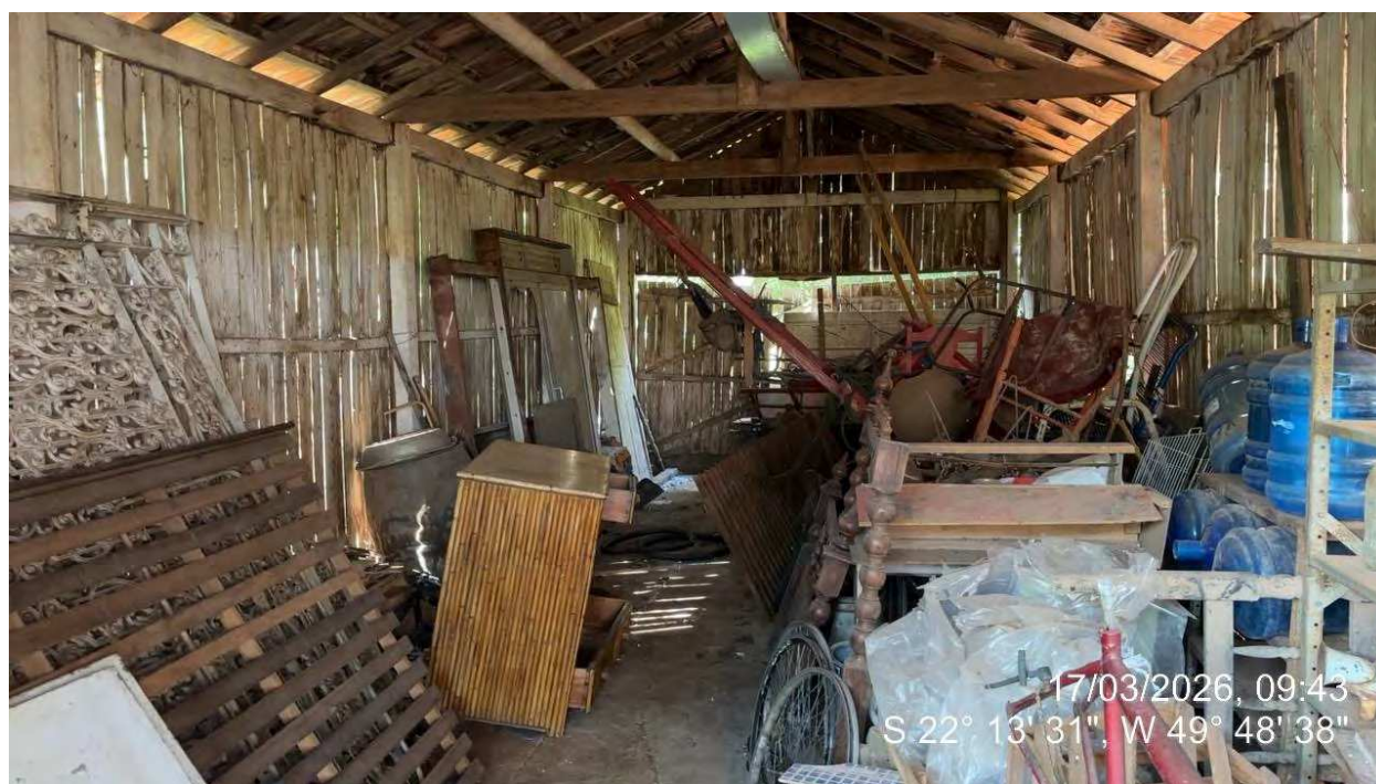
7. Vista interna da benfeitoria 2.
