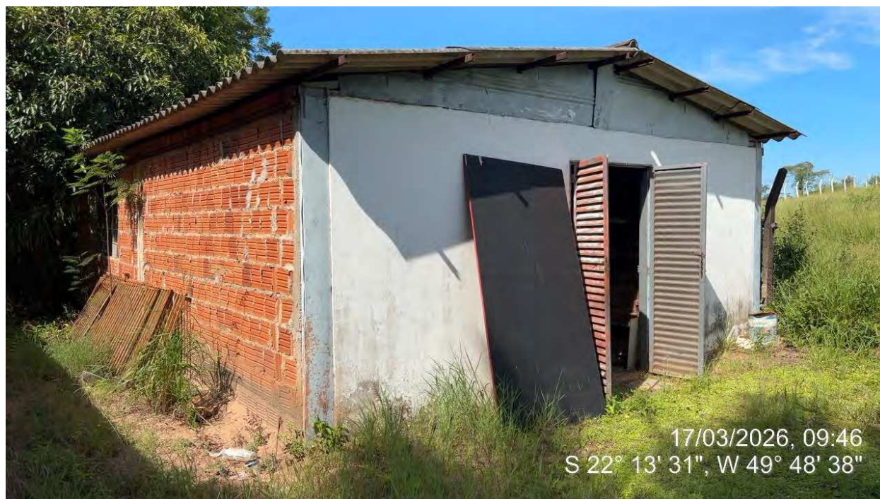
11. Vista da Benfeitoria 4, utilizada como depósito de equipamentos e de materiais.
