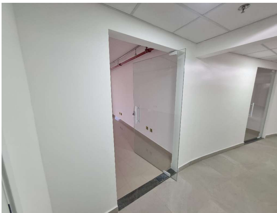
Foto 9 – Vista da Porta da Sala Comercial 101 no 10º Andar do Condomínio Edifício Senador
