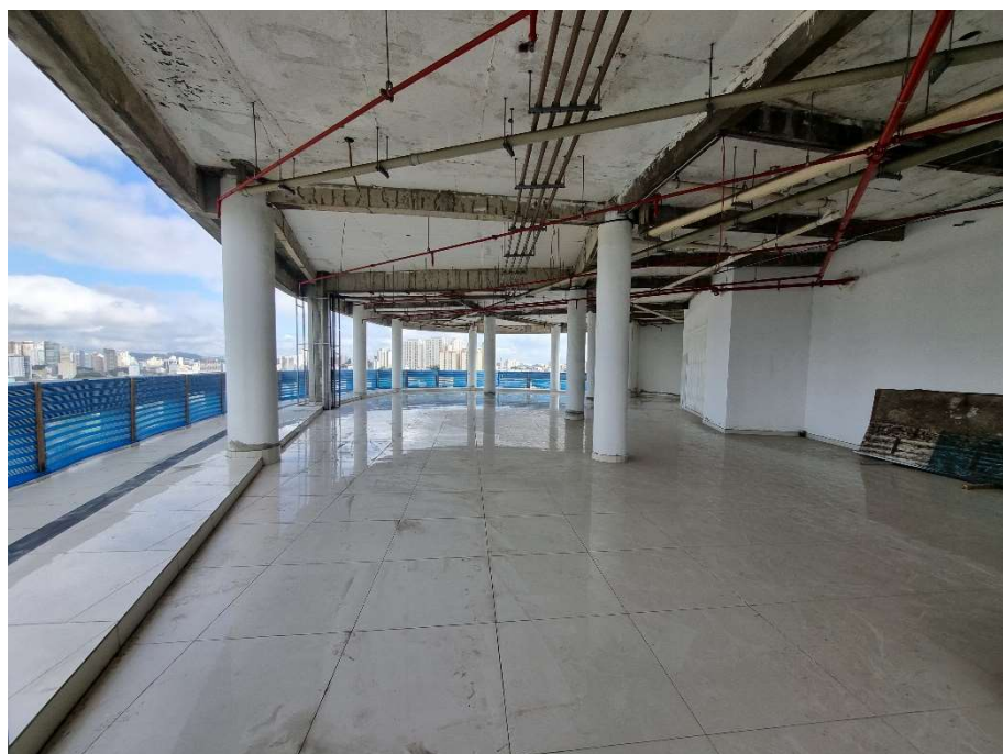
Foto 5 – Vista da Área de Lazer no 13º Andar do Condomínio Edifício Senador
