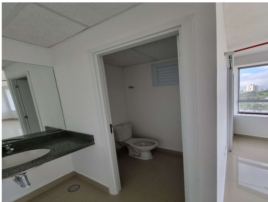
Foto 15 – Vista do Banheiro 1 da Sala Comercial 101 no 10º Andar do Condomínio Edifício Senador
