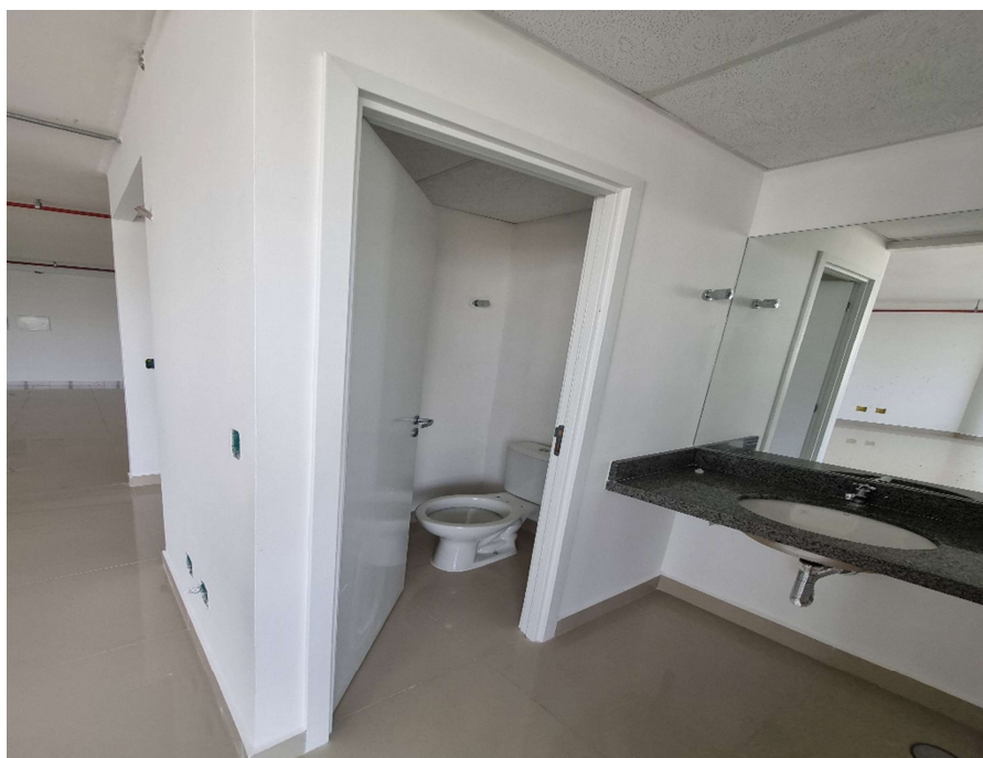
Foto 16 – Vista do Banheiro 2 da Sala Comercial 101 no 10º Andar do Condomínio Edifício Senador
