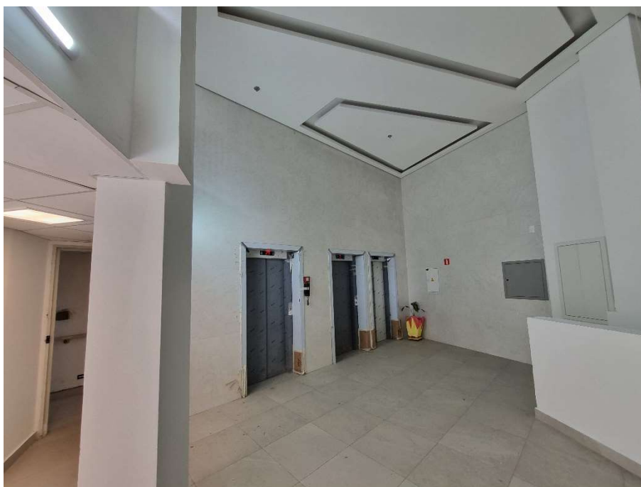
Foto 3 – Vista dos Elevadores do Hall Social do Condomínio Edifício Senador
