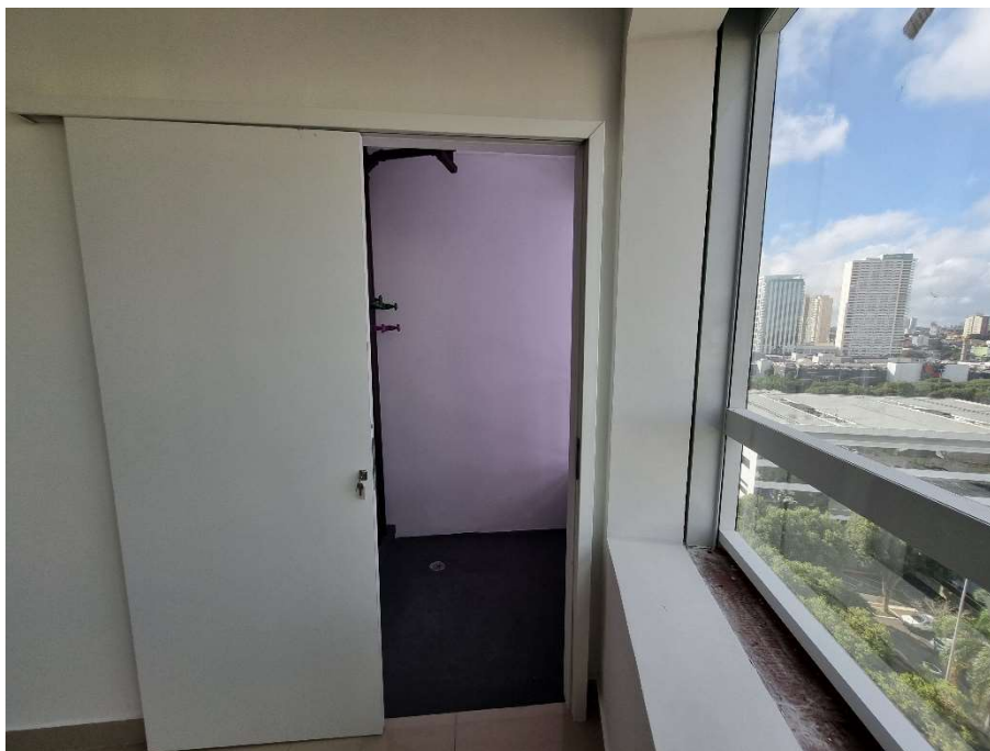
Foto 17 – Vista da Porta da Área Técnica da Sala Comercial 101 no 10º Andar do Condomínio Edifício Senador
