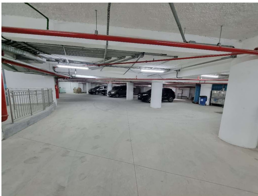
Foto 4 – Vista das Vagas de Estacionamento no Subsolo do Condomínio Edifício Senador
