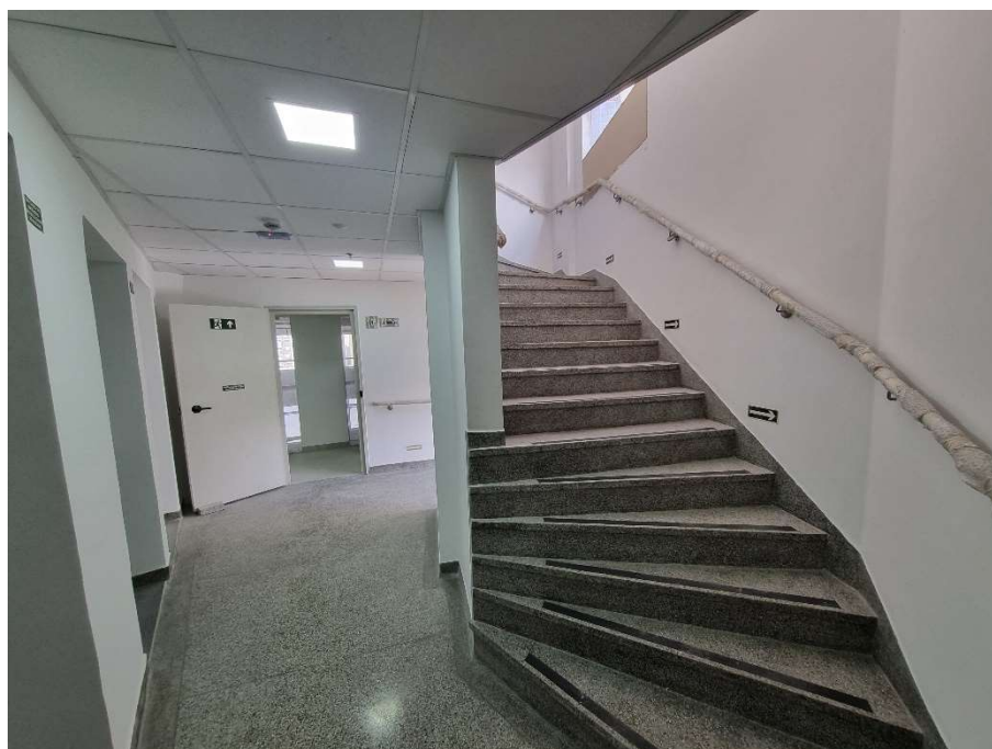
Foto 6 – Vista da Escadaria no 10º Andar do Condomínio Edifício Senador
