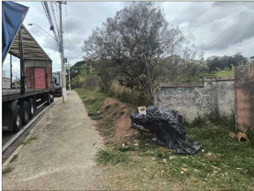
FOTO 01: Imagem da testada do imóvel Rua Atilio Biscuola nº 1950- Louveira-SP
