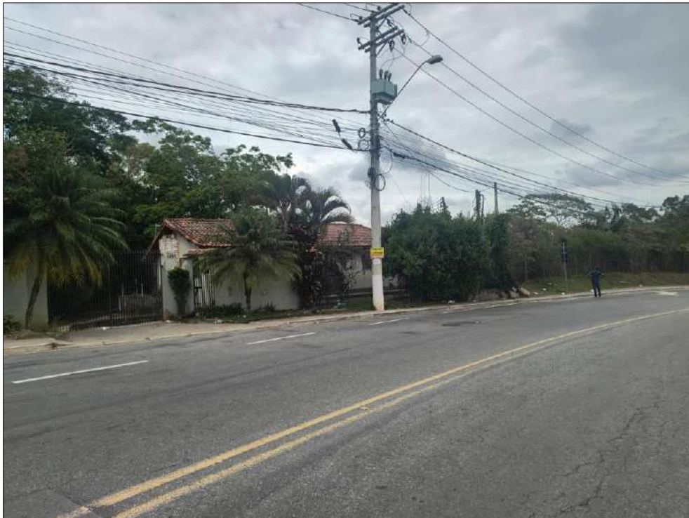
FOTO 04: Imagem da testada do imóvel Rua Atilio Biscuola nº 1950- Louveira-SP
