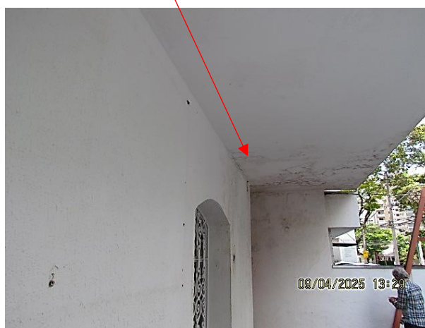
Detalhe de infiltração no canto da entrada
