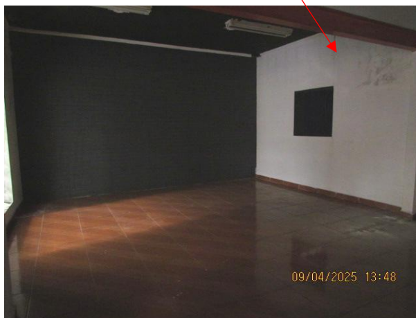
parede de sala com infiltração
