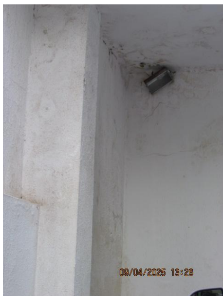
Parede e teto com manchas de infiltração
