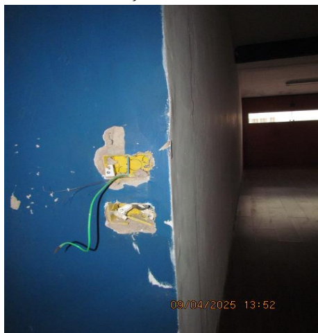
Parede danificada com retirada de instalação elétrica
