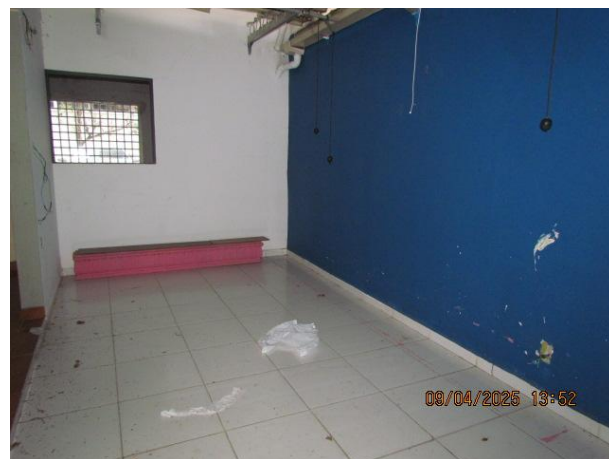
trecho de parede acima da viga (trilho) com fiação à vista e parede com pintura danificada
