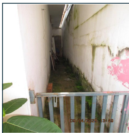
trecho de parede e teto - manchas de infiltração
