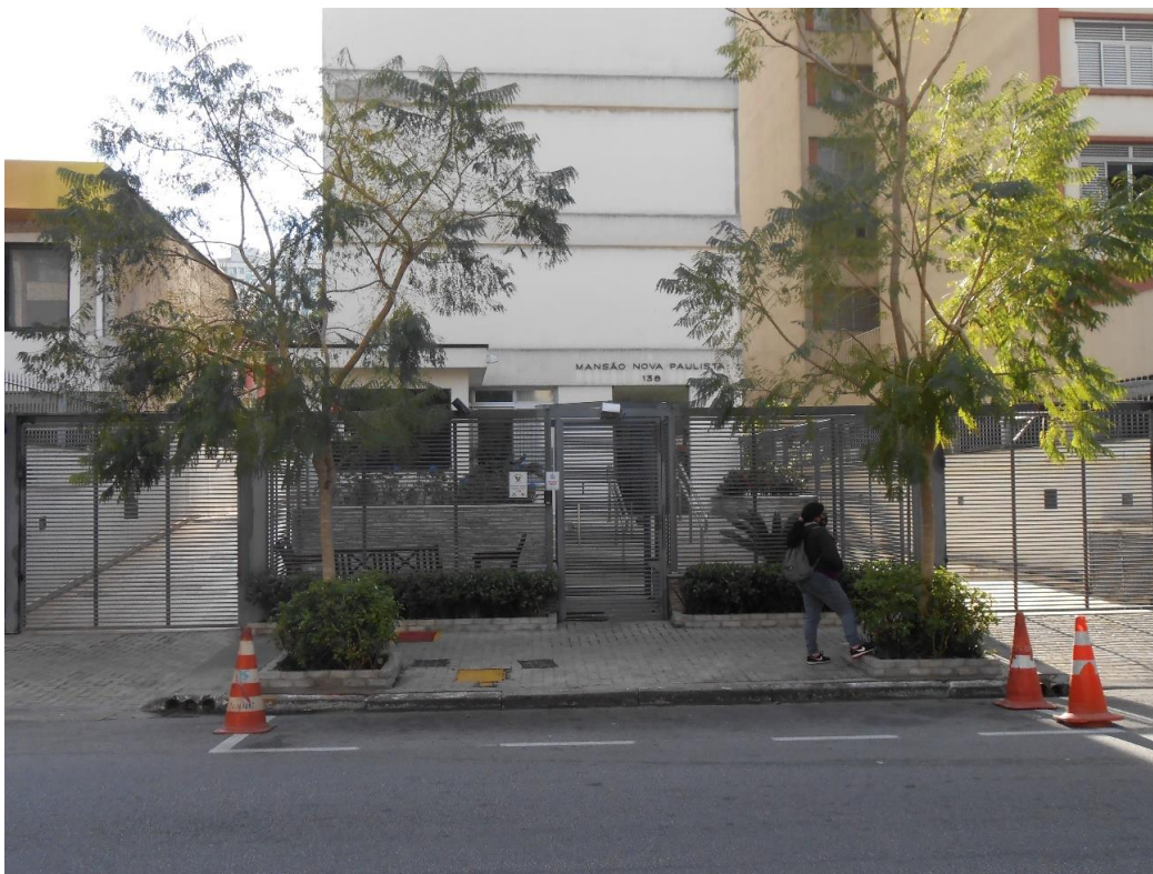
Foto 19: Portaria do edifício
