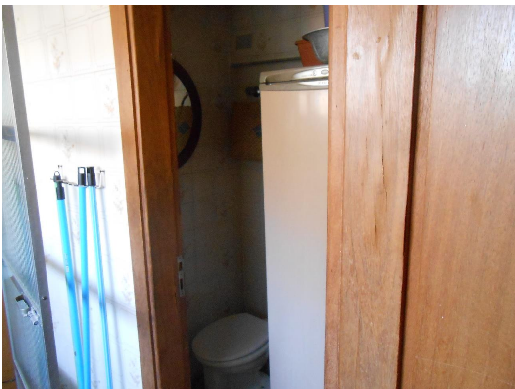
Foto 7: Sanitário de serviço da unidade 71
