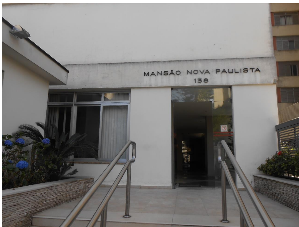
Foto 16: Entrada do edifício
