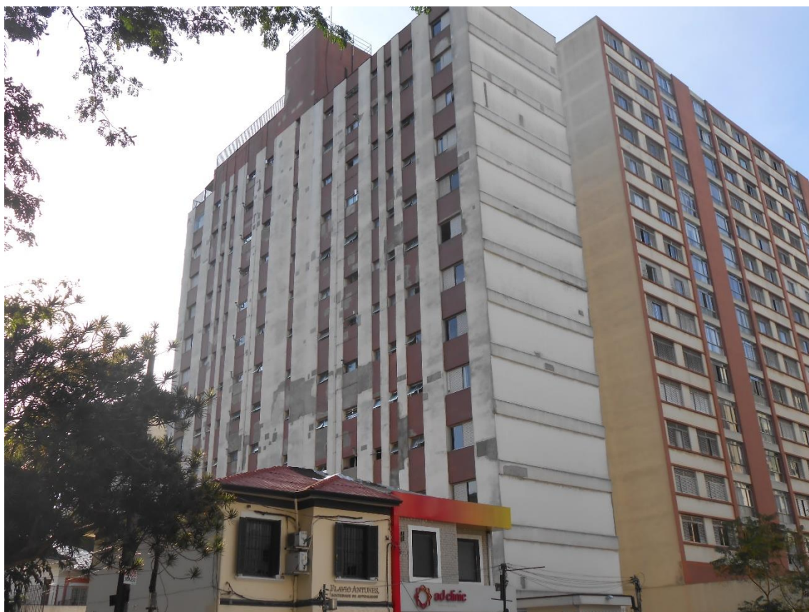
Foto 20: Fachada do edifício
