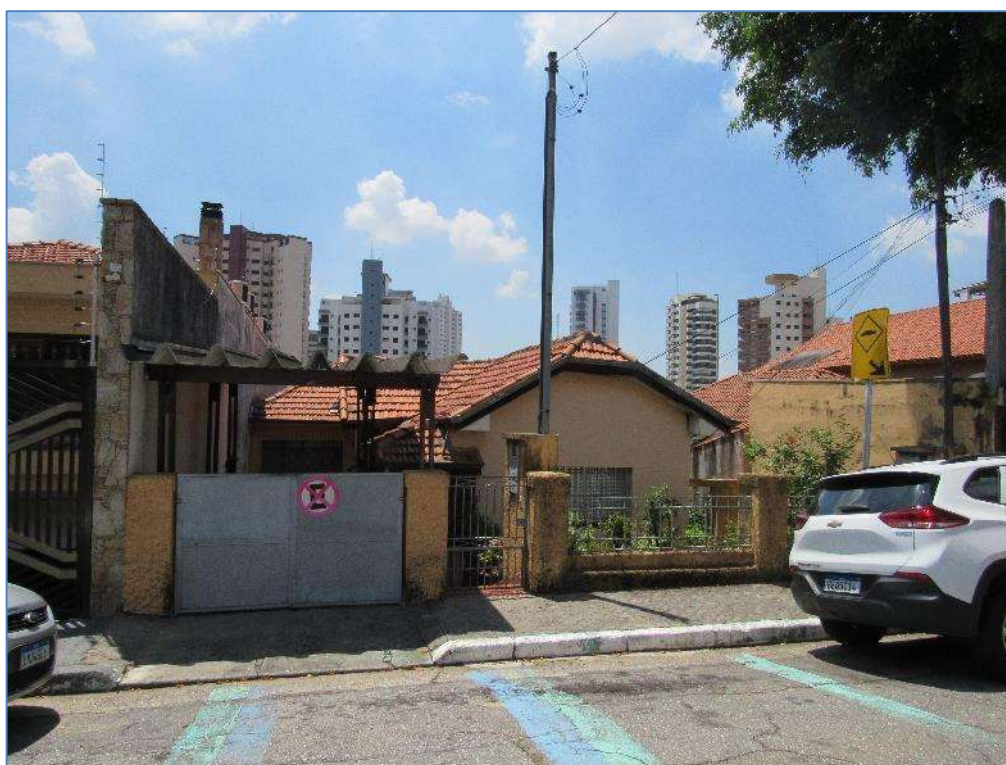
FACHADA DO IMÓVEL AVALIANDO.
