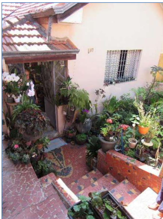
ESCADA DE ACESSO À EDIFICAÇÃO.
