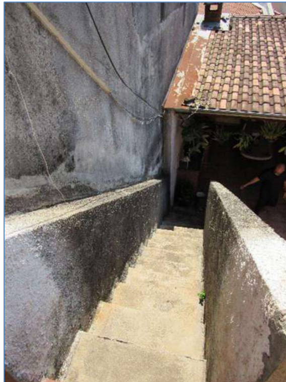
ESCALADA DE ACESO AO PAVIMENTO INFERIOR.
