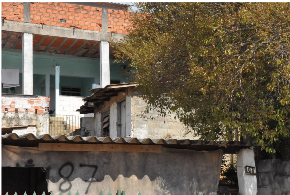
Figura 7. No interior do imóvel constam várias alterações, que integram o imóvel avaliando, que por estimativa, foi adotado que o imóvel avaliando possui construção residencial somando 154 m 2 e edificada em terreno com a área de 250 m 2 .
