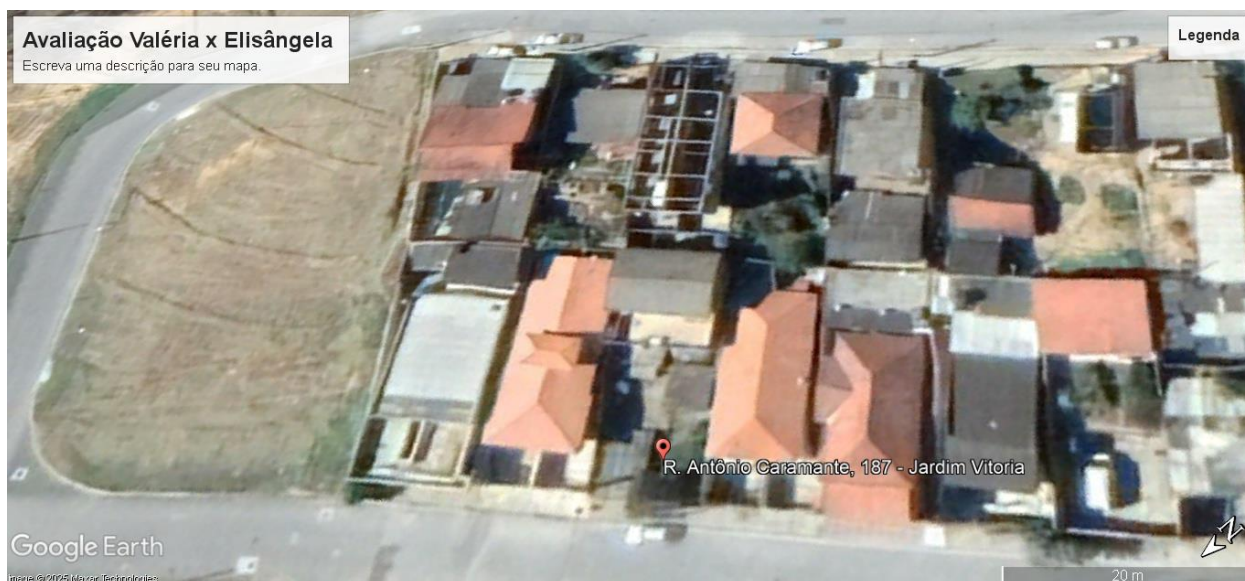
Figura 3. Imagem Google Earth, datada de 07/2013, evidenciando que as obras da edificação existente no interior do imóvel se apresentavam finalizada e sem alterações.
