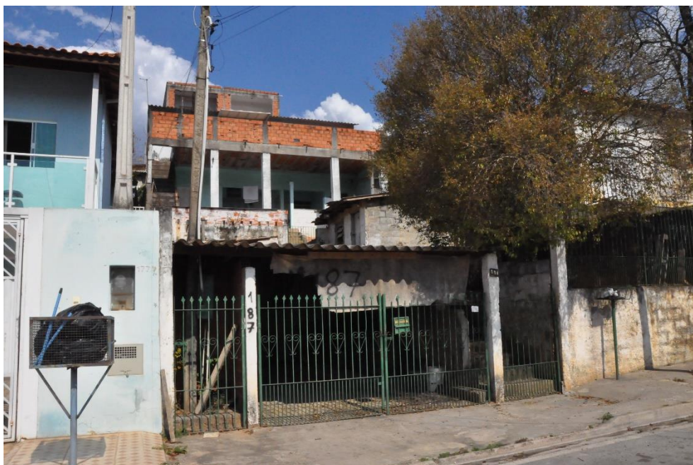
Figura 5. Na ocasião da vistoria pericial, não foi possível adentrar no imóvel e em consenso com as partes, chegou-se por estimativa, que o imóvel avaliando possui edificação com 154 m 2 e com base nos documentos dos autos, que o terreno possui a área de 250 m 2 .
