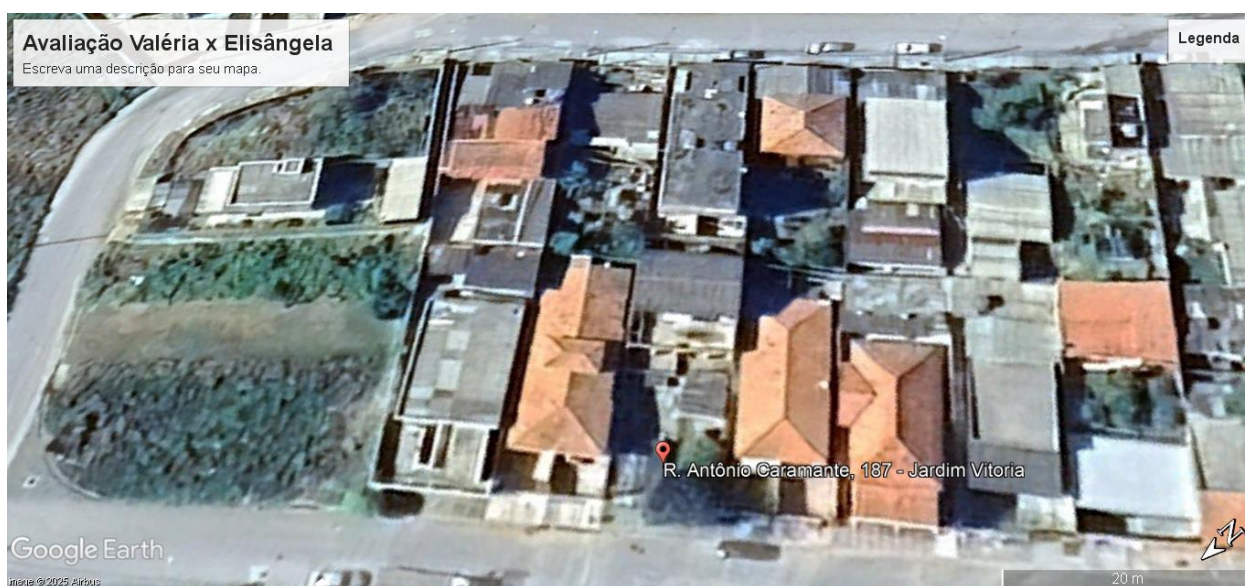
Figura 4. Imagem Google Earth, datada de 07/2025, denotando que a edificação existente no imóvel avaliando se encontra sem alterações evidentes desde a data de 04/2011, caracterizando a idade construtiva nessa data e, portanto, somando a idade construtiva de 14 anos.
