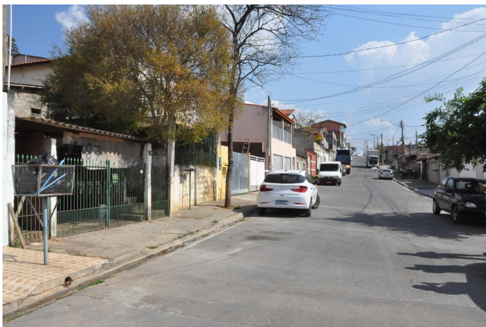
Figura 4. Visão da Rua Antonio Caramante, nº 187, Jardim Vitória, Mairinque, SP, onde o imóvel avaliando se encontra localizado.
