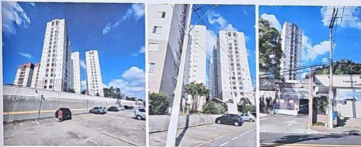
Vista torres e estacionamento superior
