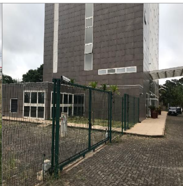
Imagem 04 – Tomada fotográfica obtida à partir da rampa de acesso, ilustrando entrada do estacionamento e acesso até a entrada principal.
