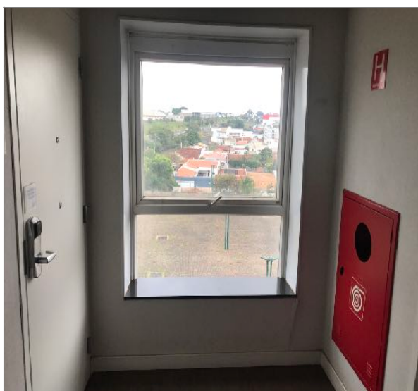
Imagem 15 – Ilustrando tipo de esquadria da área comum do pavimento tipo. Detalhe para tipo de fechadura existentes nas portas dos quartos.
