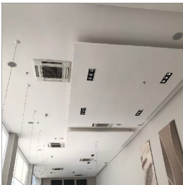
Imagem 09 – Tomada fotográfica destinada a ilustrar pé-direito duplo, ar condicionado central, padrão de acabamento.
