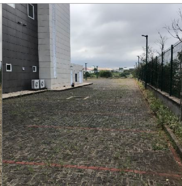
Imagem 06 – Área externa dos fundos.
