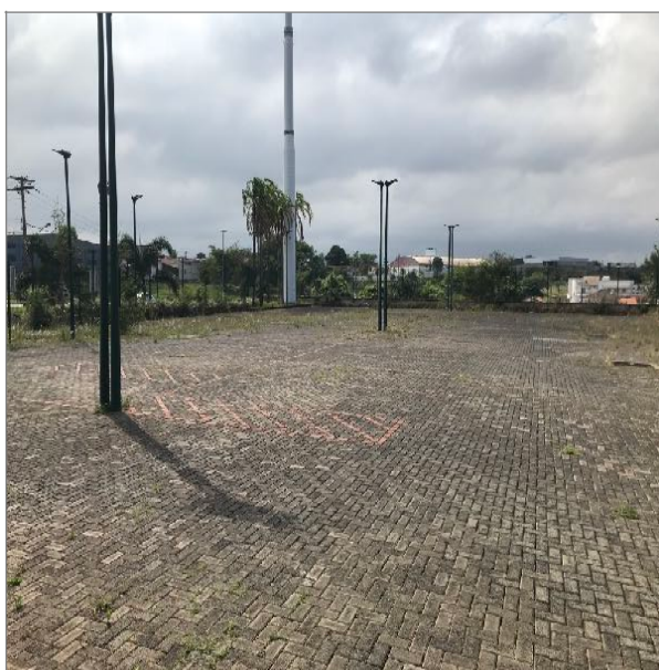
Imagem 05 – Área de estacionamento
