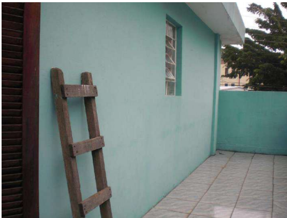
Foto - Vista dos terraços do avaliando.
